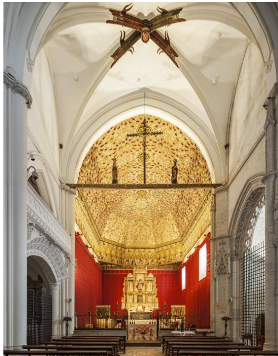
Vista general de la iglesia
