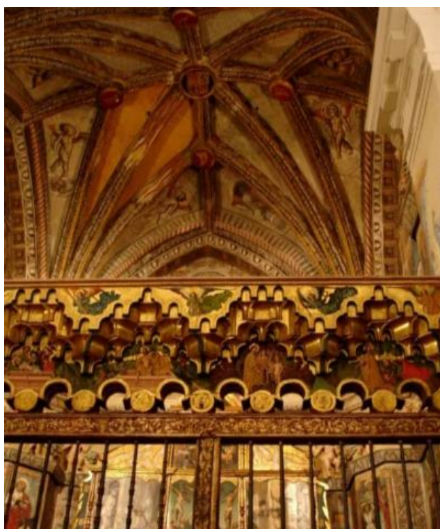
Detalle de la cubierta del Coro Largo
