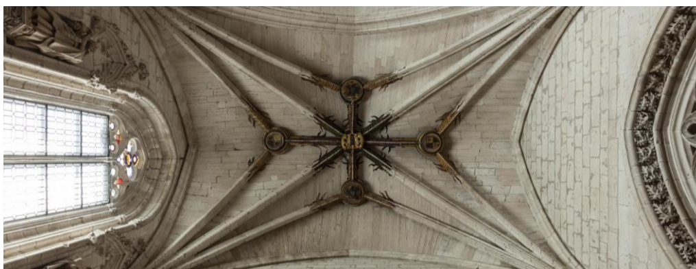
Bóveda de la capilla
