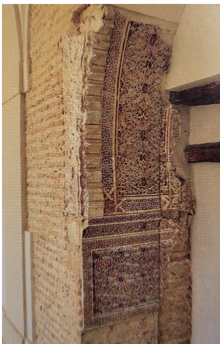
Arco de yesería policromada descubierto en el Patio de El Vergel gracias a las restauraciones
