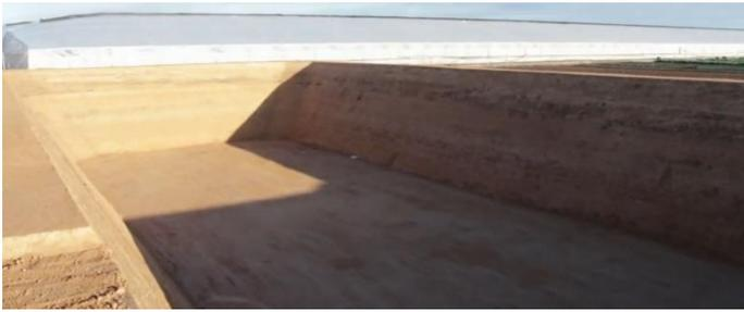
En cuanto a los espesores de la lámina, se pondrán entre 0,8 que es muy fino, hasta 1,1 – 1,5 cm. Debemos de recubrir por debajo con un geotextil para protegerlo de las piedras. El presente embalse tendrá una salida y un llenado y luego deberemos de vallar por tema de seguridad (8 euros/ metro cuadrado). Le colocaremos una valla perimetral de 2 metros de altura.
