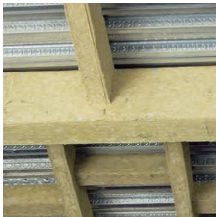
Figura 11.- Viga metálica protegida mediante placas
