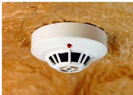
Figura 6. Detector de humo térmico
