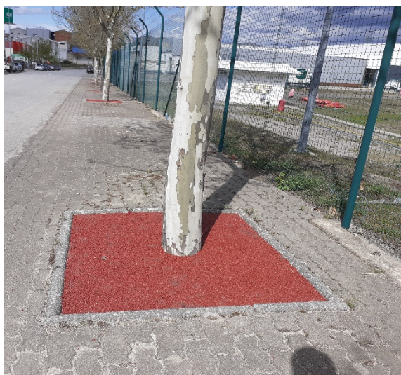
Figs. 76 y 77. Fotografías de alcorques con pavimento a base de resinas, hechas en julio de 2022. Fuente: M. Rosario del Caz Enjuto (UVa).
