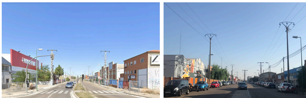
Figs. 1 y 2. A la izquierda: Tramo de la avenida Norte de Castilla, donde las líneas eléctricas discurren por las aceras. A la derecha: Tramos de la misma avenida donde puede observarse, al fondo, que la línea de media tensión discurre por el centro de la calzada. Fuente: M. Rosario del Caz Enjuto (UVA)
