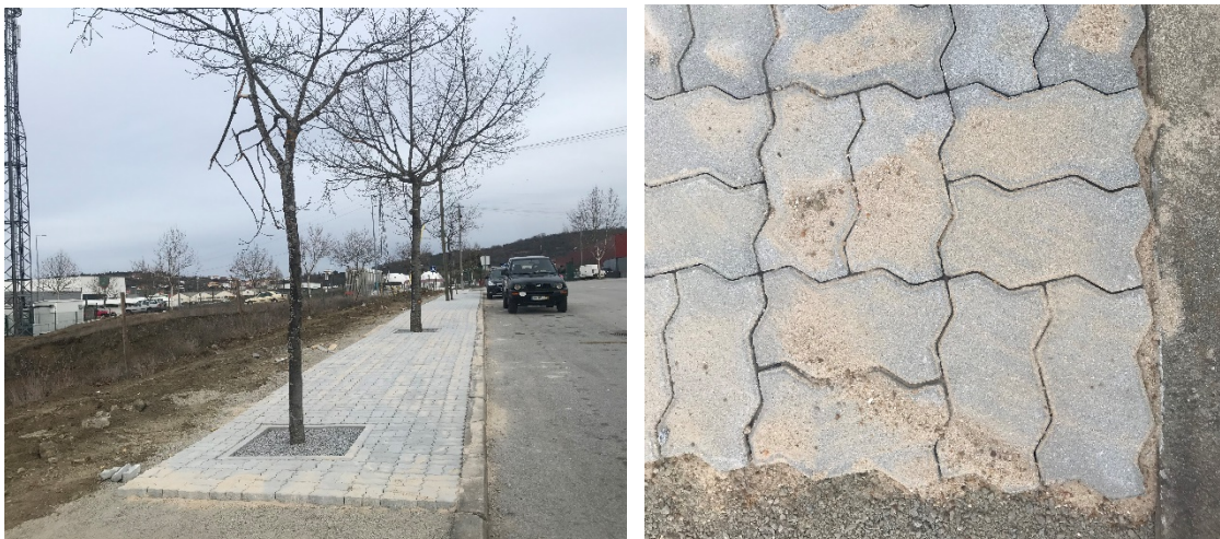
Figs. 78 y 79. Fotografías del pavimento a base de adoquines sobre lecho de arena, hechas en julio de 2022. Fuente: M. Rosario del Caz Enjuto (UVa).
