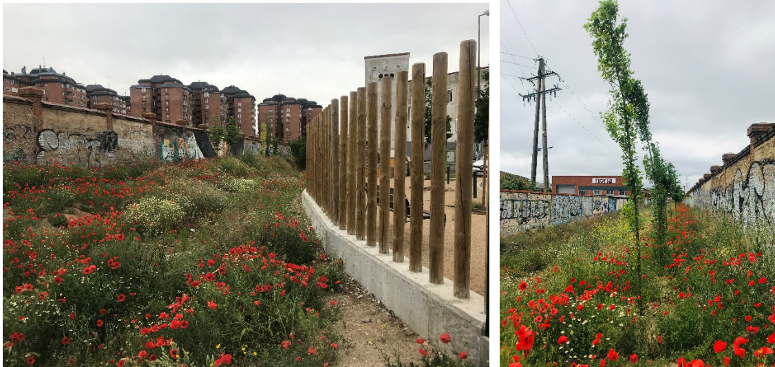
Fig. 60 y 61. Fotografías del cauce renaturalizado del arroyo Espanta, hechas en mayo de 2022. Fuente: M. Rosario del Caz Enjuto (UVa).
