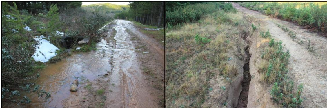
Imagen 12: Cuneta colmatada de sedimentos por lo que la escorrentía desagua por la pista forestal (izquierda) y reguero profundo en orilla de pista forestal (derecha). Fotografías propias (cuneta 01/05/2013; reguero 24/09/2011)
