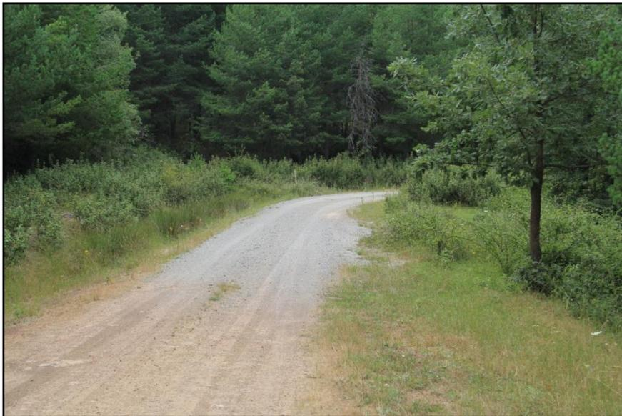
Imagen 21: Mejora del firme en tramo curvo mediante gravas. Fotografía propia (19/07/2014)
