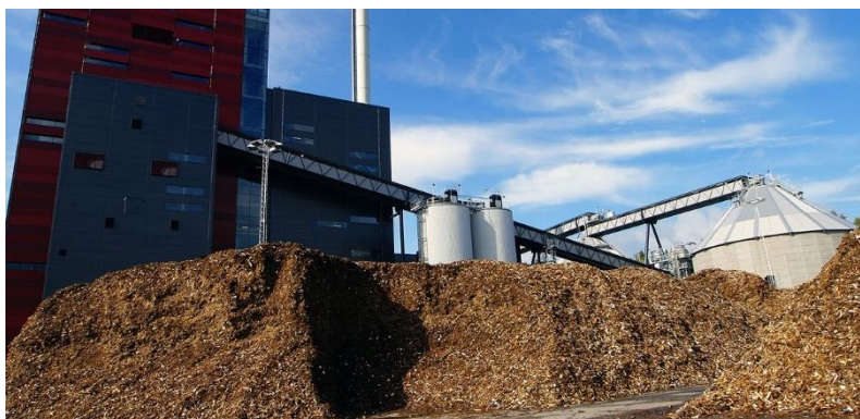
Figura 12: almacén exterior de biomasa
