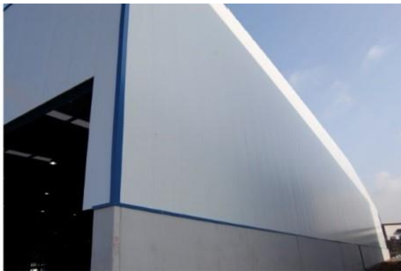
Figura 8: fachada en panel sándwich y hormigón.
