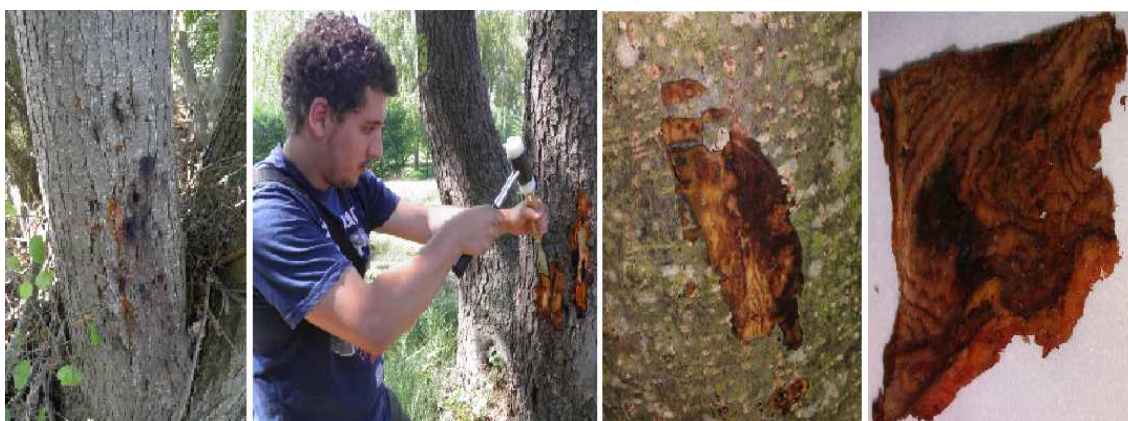
Figura 11. Protocolo de identificación y extracción de madera necrosada. Fuente: elaboración propia.
