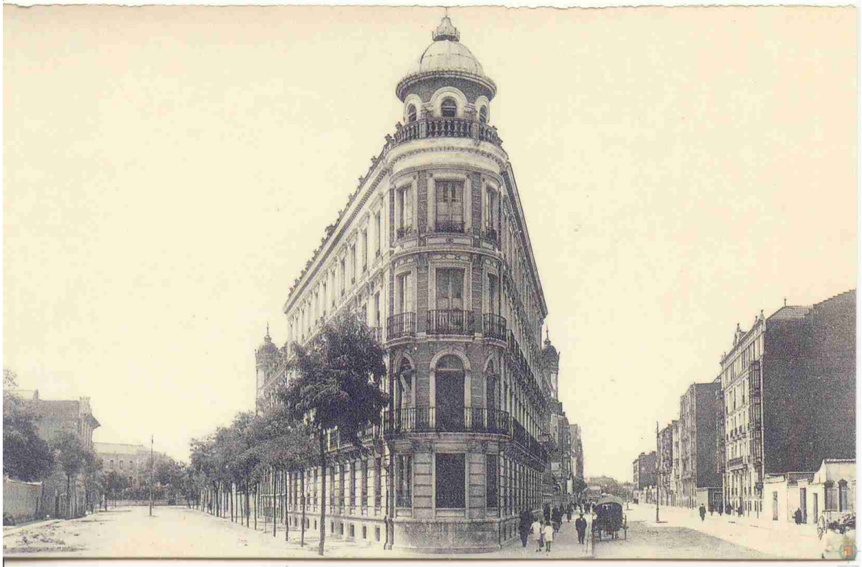
[02] Vista de las calles Gamazo y Muro hacia principios del siglo XX.
