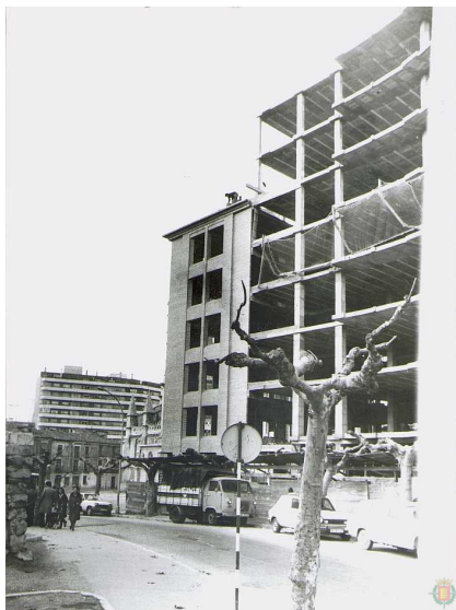
[79] Vista de una fase más avanzada de estas mismas obras.
