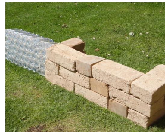
(74). Construcción de muro mixto de fábrica de adobe y PET
