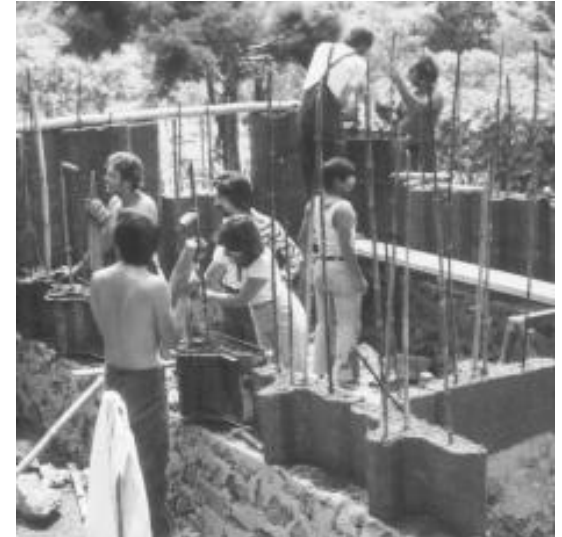
(40). Vivienda de tapial reforzada con bambú. Guatemala. 1978
