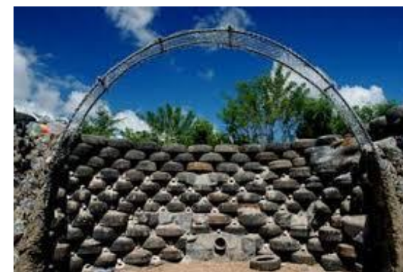
(34). Construcción de casas Earthships. Michael Reynolds.
