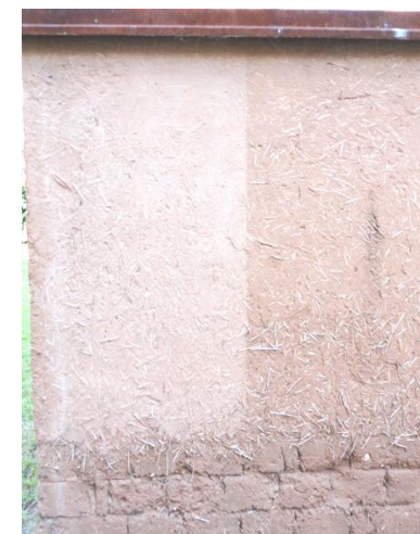
(46).Revoque de barro. Grupo Tierra de Universidad de Valladolid.
