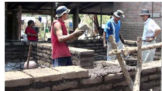
(9). Construcción de viviendas con adobes cuadrados.
