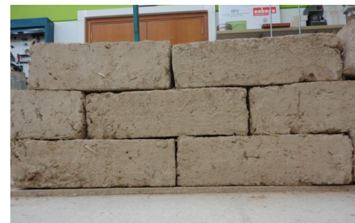
(42).Muro de adobes. Grupo Tierra de Universidad de Valladolid.
