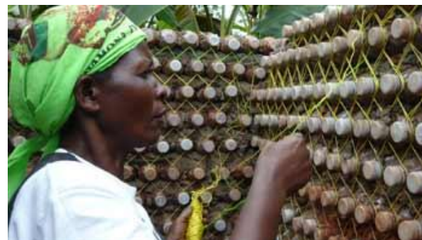
(30).Amarre de botellas en muro de PET
