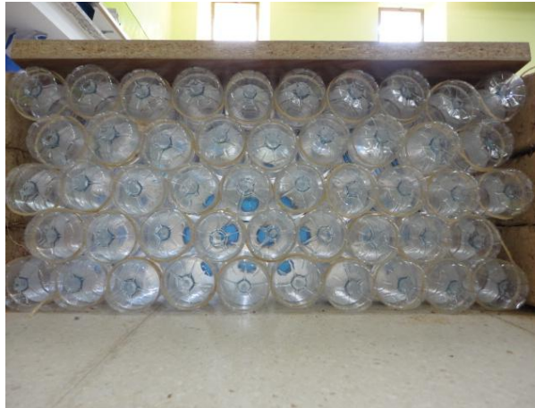
(69). Construcción de muro
