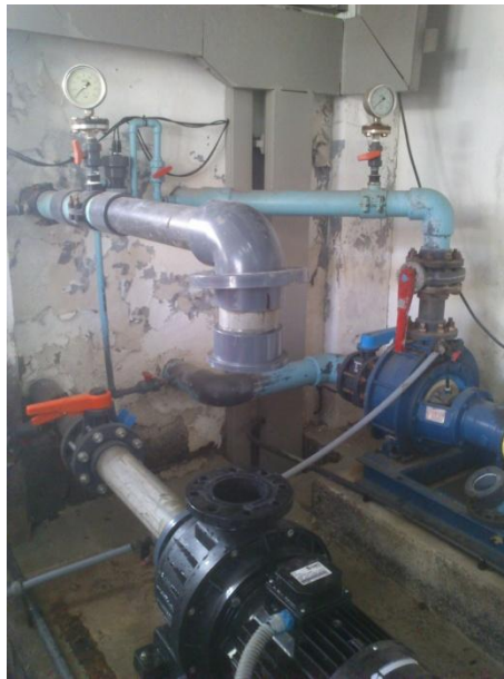
Fotografía 10: Detalle de reparación de bombas de inyección de ácido.
