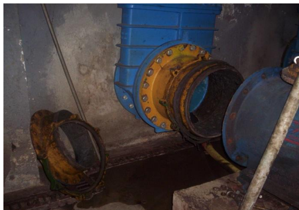
Fotografía 9: Detalle de bomba en reparación.
