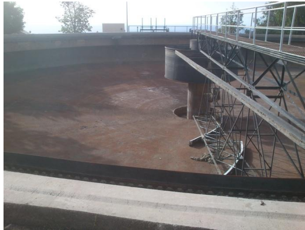
Fotografía 1: Decantador primario vacío.
