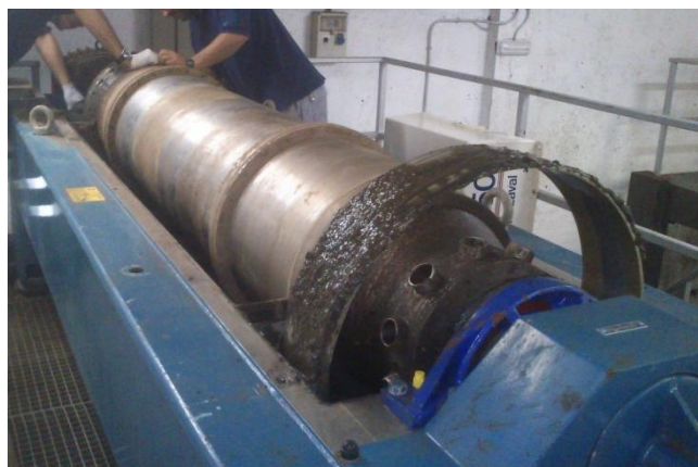
Fotografía 13: Detalle de la reparación de la centrifugadora.
