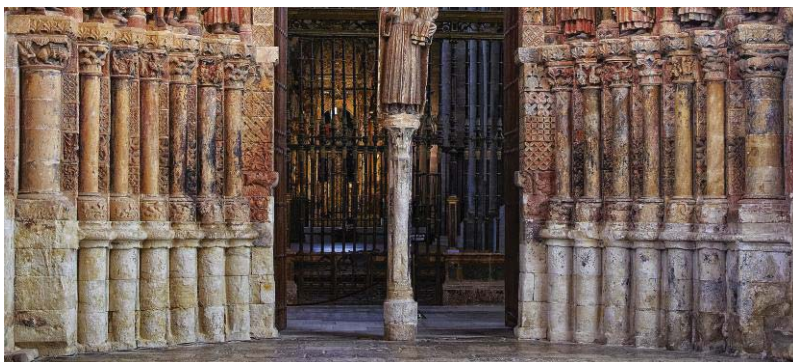
II. 1. Primera parte de la construcción, románica de principios del SXIII (aprox.1230): Parte inferior del Pórtico de la Majestad de Toro ( Estudio fotográfico , Toro). Colección particular de la autora.
