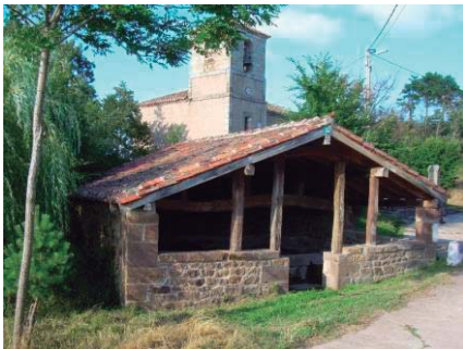
Lavadero de Alfoz de Bricia.
