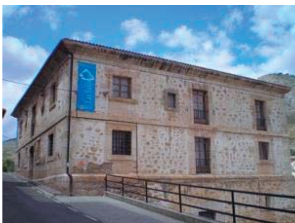
Casa de Administración de las Salinas. anchaescastilla.es
