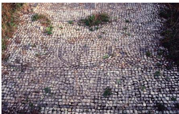
Calzada romana de Salinas del Rosío. ARCA Y PROYECTOS
