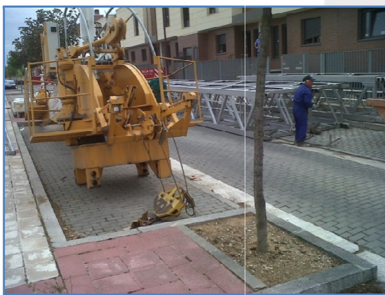
Trabajos de desmontaje de grúa.
