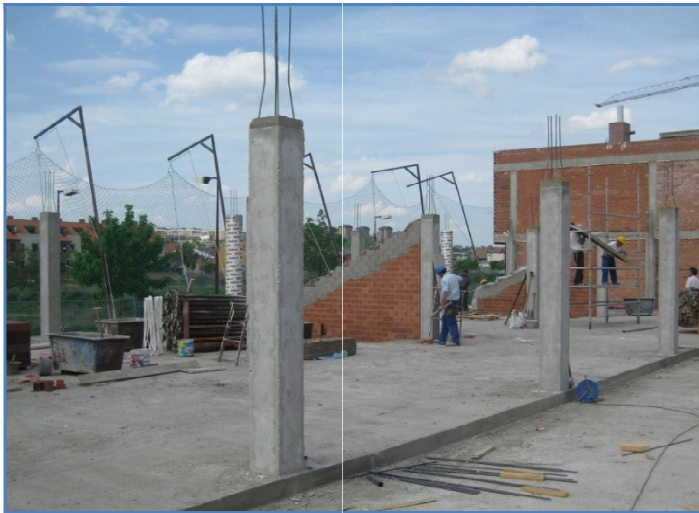
El recurso preventivo vigilando la ejecución de tareas con riesgo de caída.
