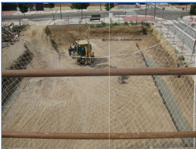
Correcta situación de la rampa de acceso según Plan de Seguridad y Salud. La retroexcavadora, finalizará la excavación del solar, ascendiendo y retirando las tierras por la rampa de acceso.
