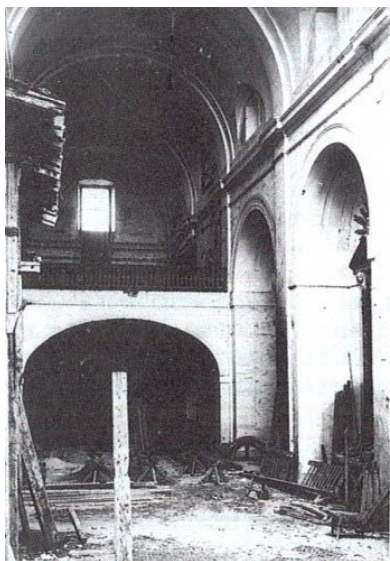
Fig. 3. Interior del templo conventual
