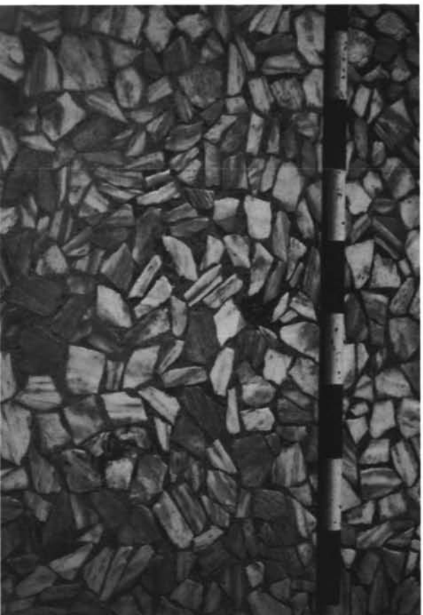
Ampurias. Pavimento n.º 1 de las termas de la Neápolis.
