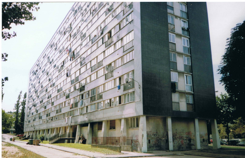
Fig. 5. Fachadas principales de grupos residenciales en Clichy-sous-Bois. Fuente: fotografías del autor.
