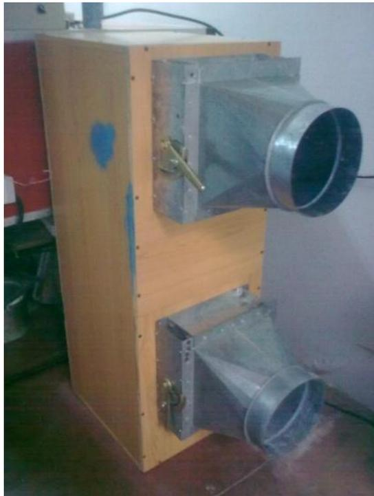
**Figura IV.8.** Vista del plenum de distribución conectado a la UTA.
