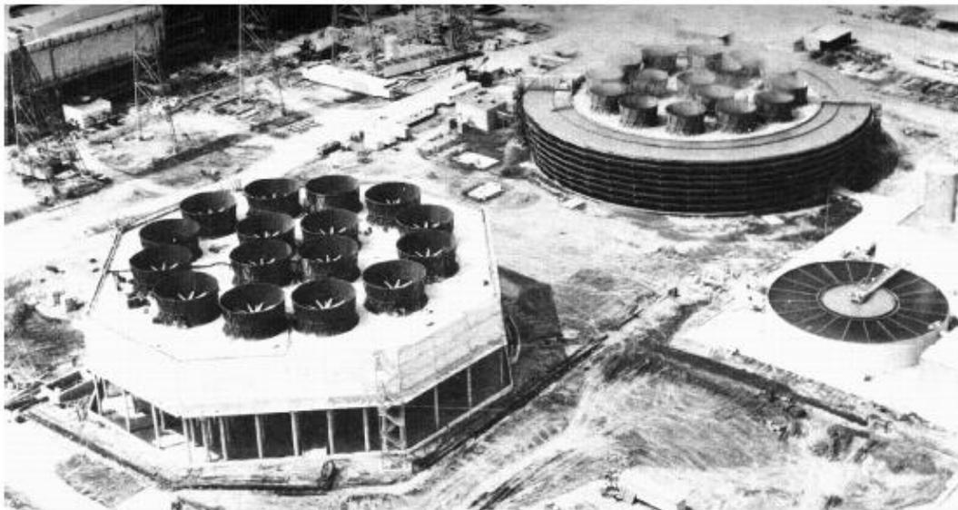
**Figura III.42.** Torres de refrigeración multicelda de tiro inducido mostrando la disposición de corrientes cruzadas y contracorriente en planta octogonal. [11]
