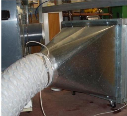
**Figura IV.10.** Colectores empleados en la conexión de los conductos a la batería.
