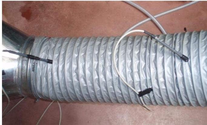
**Figura IV.7.** Detalle de un conducto de aire flexible.
