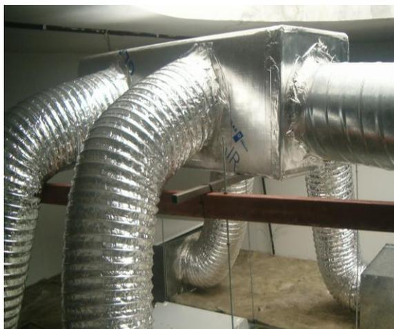
**Figura IV.9.** Vista de la conexión del plenum de distribución a la cámara climática.
