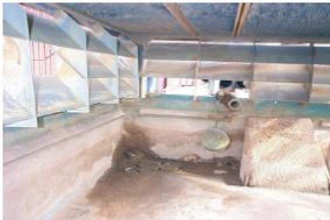
**Figura III.54.** Detalle de la pendiente en el interior de una torre de refrigeración.
