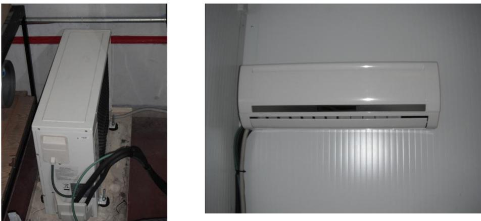
**Figura IV.5.** Unidades exterior (izquierda) e interior (derecha) de la Bomba de Calor aire-aire de marca Ferroli instalada en la cámara climática.
