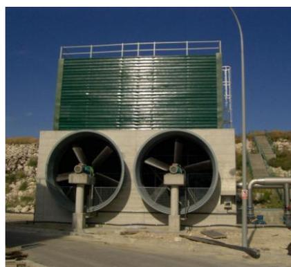
**Figura III.37.** Disposición de los ventiladores en torres de tiro forzado. [11]
