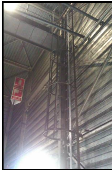
Ilustración 10. Escala fija con protección circundante. (Fuente: Michelin)
