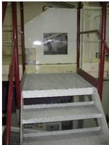
Ilustración 5. Plataforma fija de trabajo (Fuente: Michelin)
