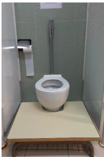
Figura 14. Instalación de una plataforma en el inodoro.
