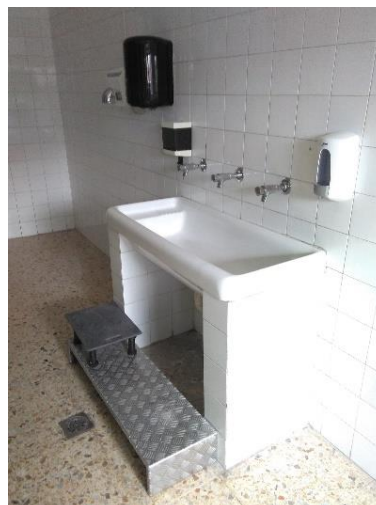
Figura 15. Instalación de una plataforma para poder acceder al lavabo.
