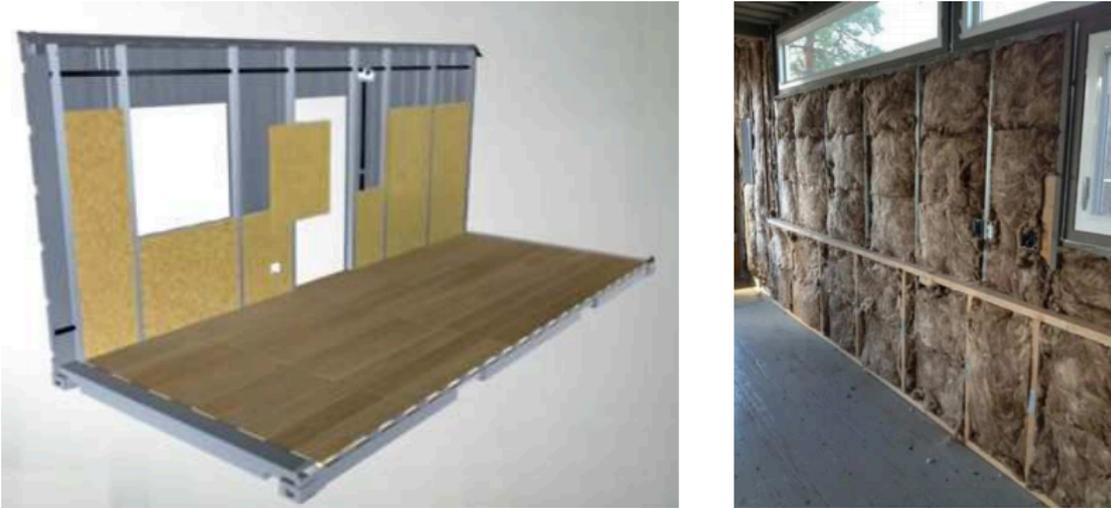
IMAGEN 36: colocación del aislamiento interior
