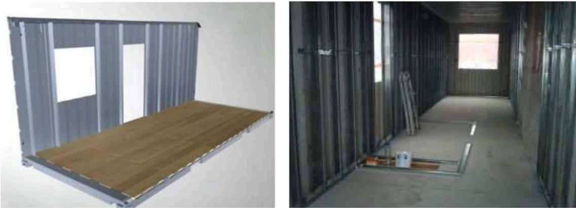
IMAGEN 34: colocación de la perfilería en las paredes interiores
