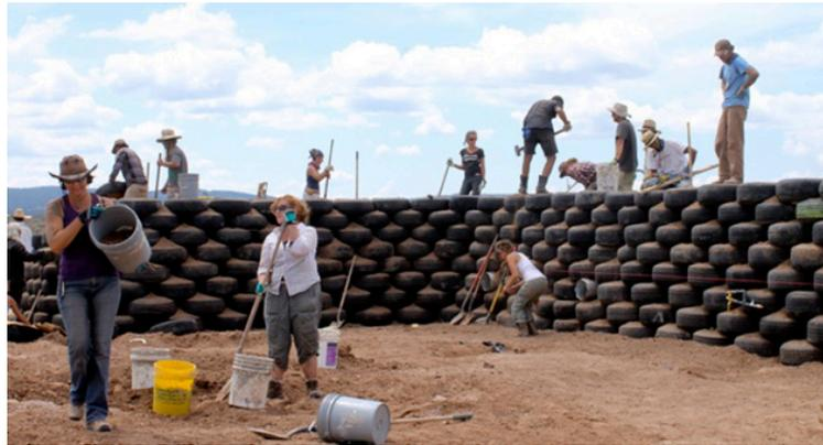
IMAGEN 14: Construcción de un muro con neumáticos fuera de uso.
