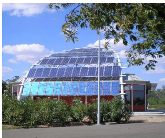
Figura 1.2 Vela solar del Centro Municipal de Acústica de Valladolid
