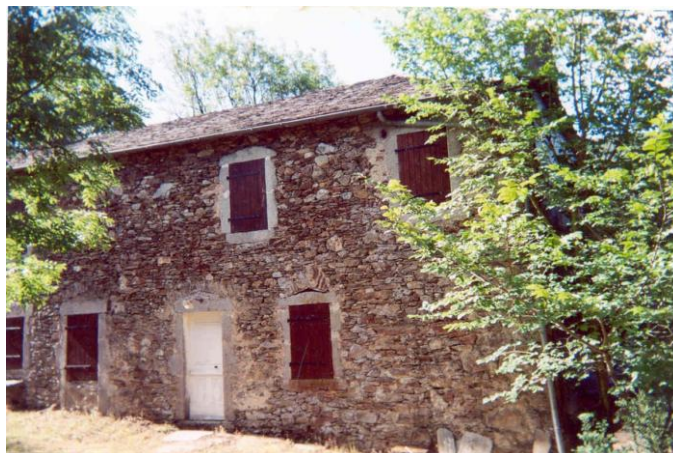
Fig. 80. Escuela de Cruzi 165 (Tarn): estado actual. Foto : M. Bardou Aimé
