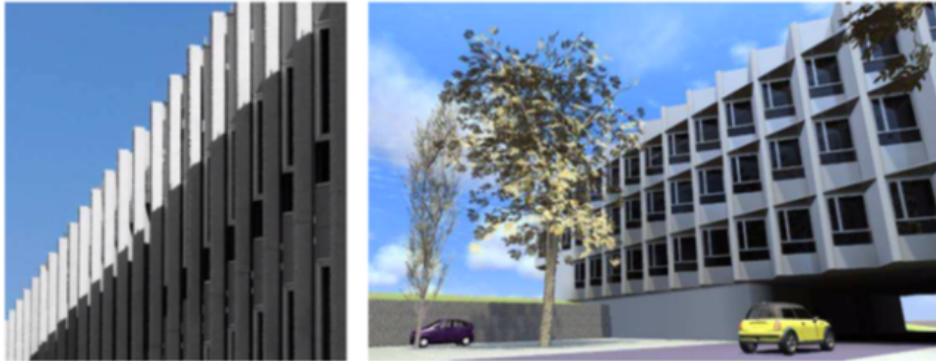
Figura 11. Diente de sierra y parasoles para producir efecto de auto sombra. [15]
