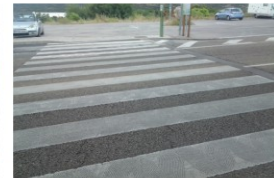
Paso de peatones con acera rebajada.
