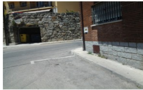
Ancho de paso de las aceras escaso para las personas que circulan en silla de ruedas.
