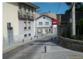
Acera con bolardos de separación entre zona vehicular y peatonal.
