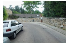
Aceras sin rebaje e irregulares en el ancho de paso
