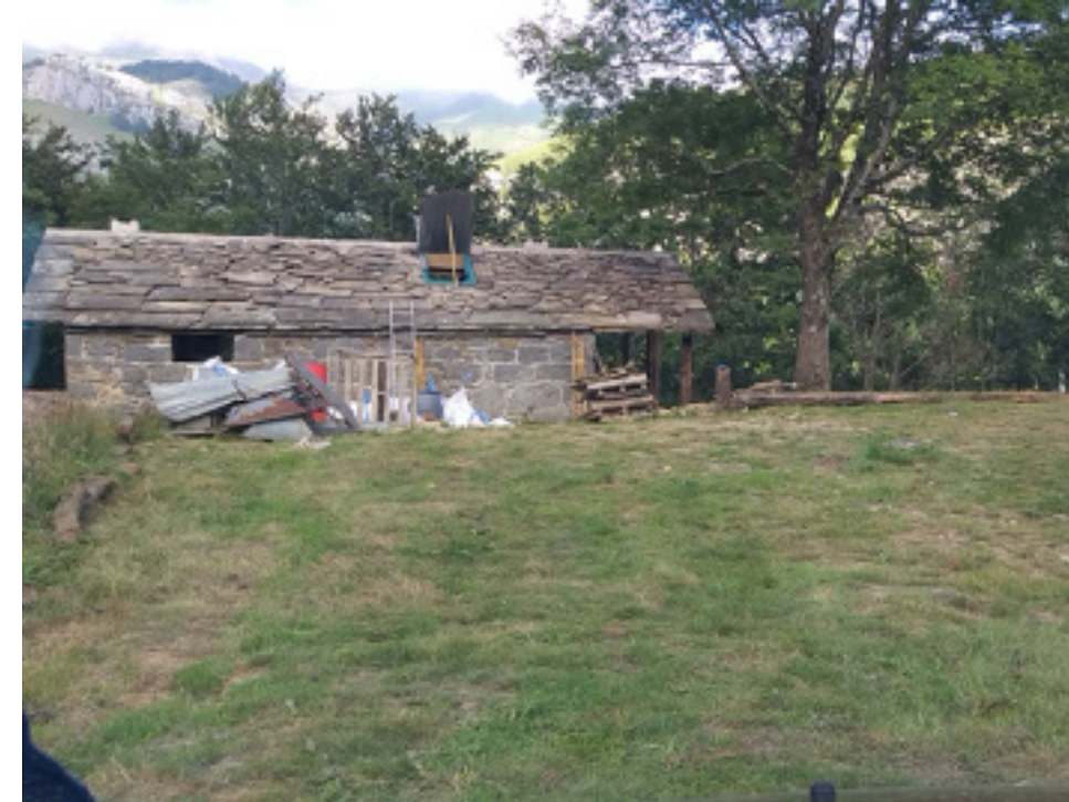
Colocación de lasras de piedra en cubierta
