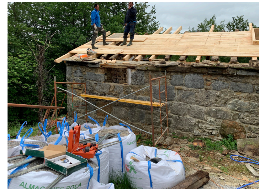
Colocación de tablazón de madera
