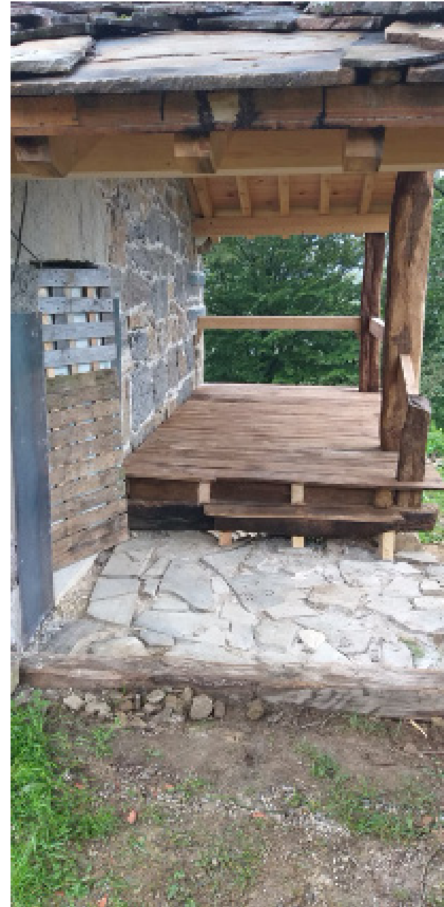
Constucción forjado porche planta primera
