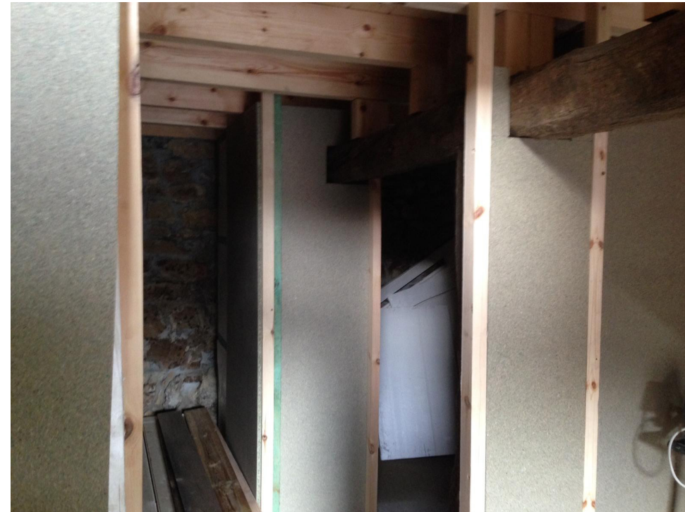
Construcción de tabiques divisorios en planta baja
