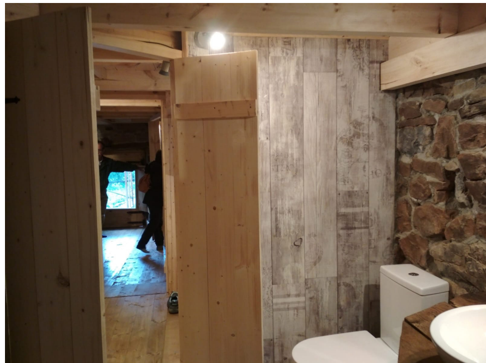
Colocación de fisos en tabiques húmedos
