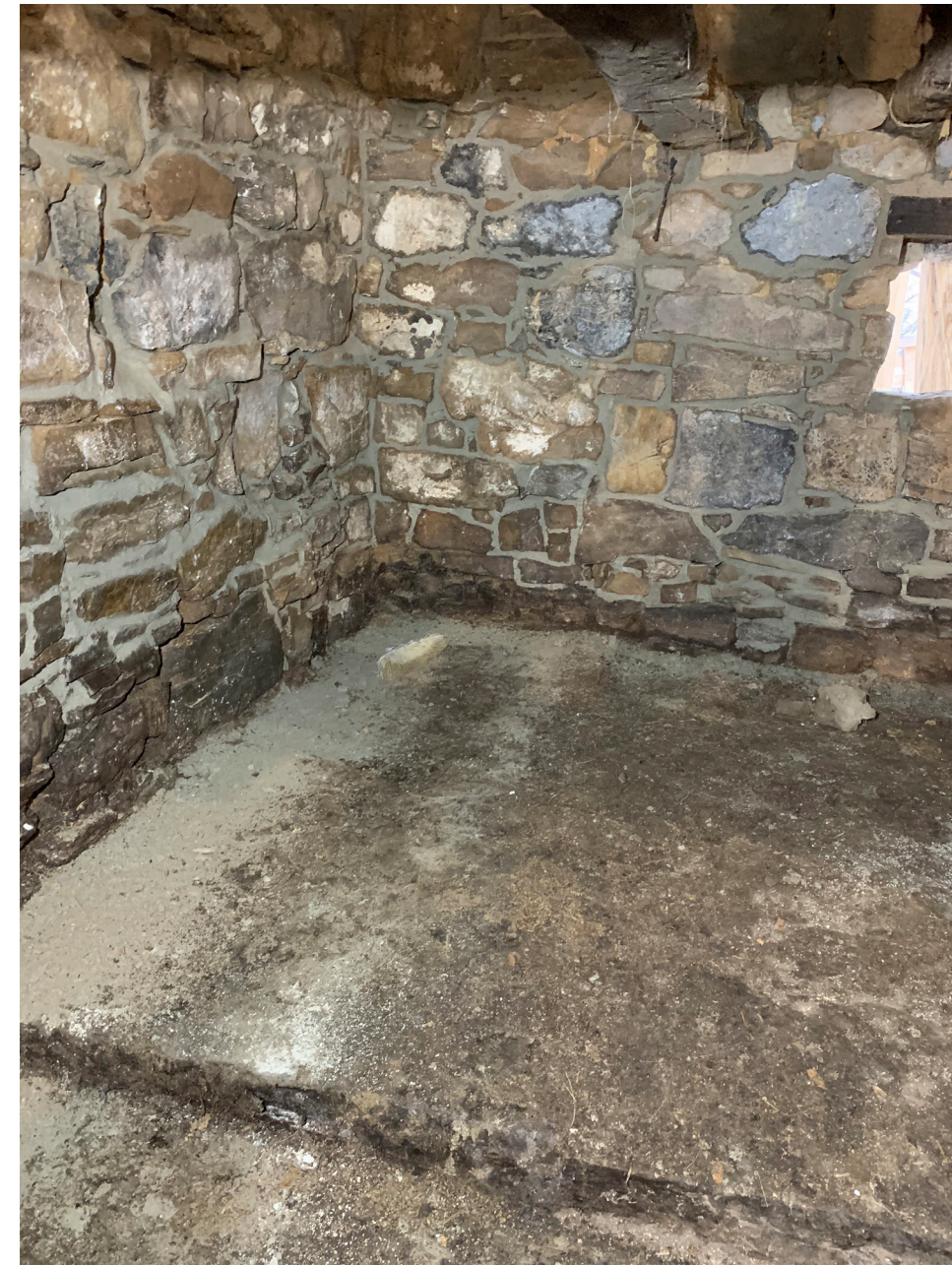
Rejunteo de yendas con mortero de cemento
