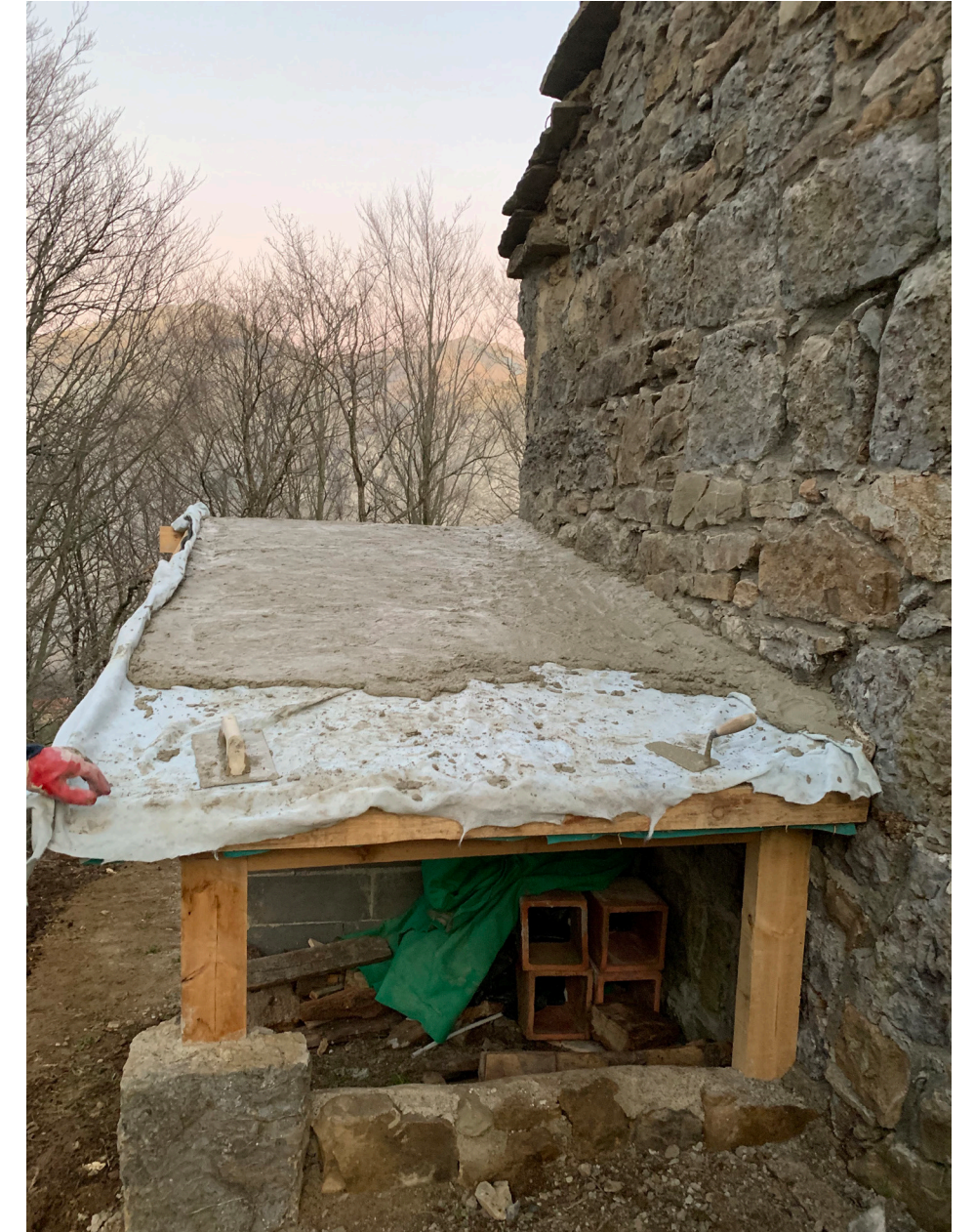
Solera de hormigón en cubierta de cuarto de instalaciones
