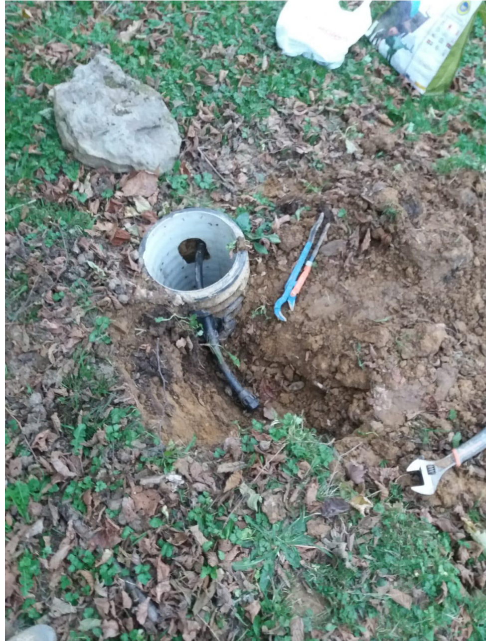
Apertura de zanja para acometida de agua
