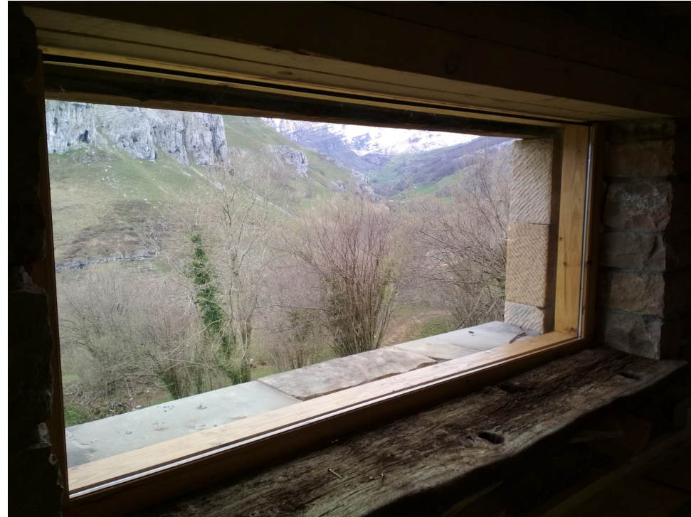
Colocación de cristal del ventanal
