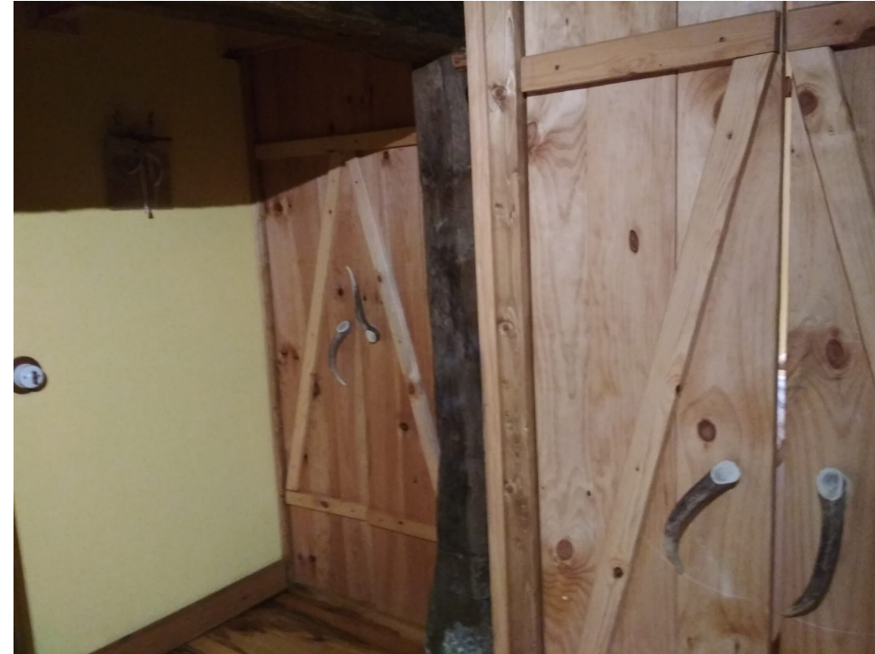
Colocación de carpinterías interiores
