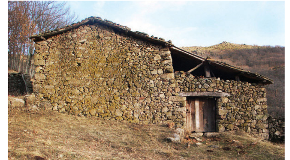
Estado original de la construcción
