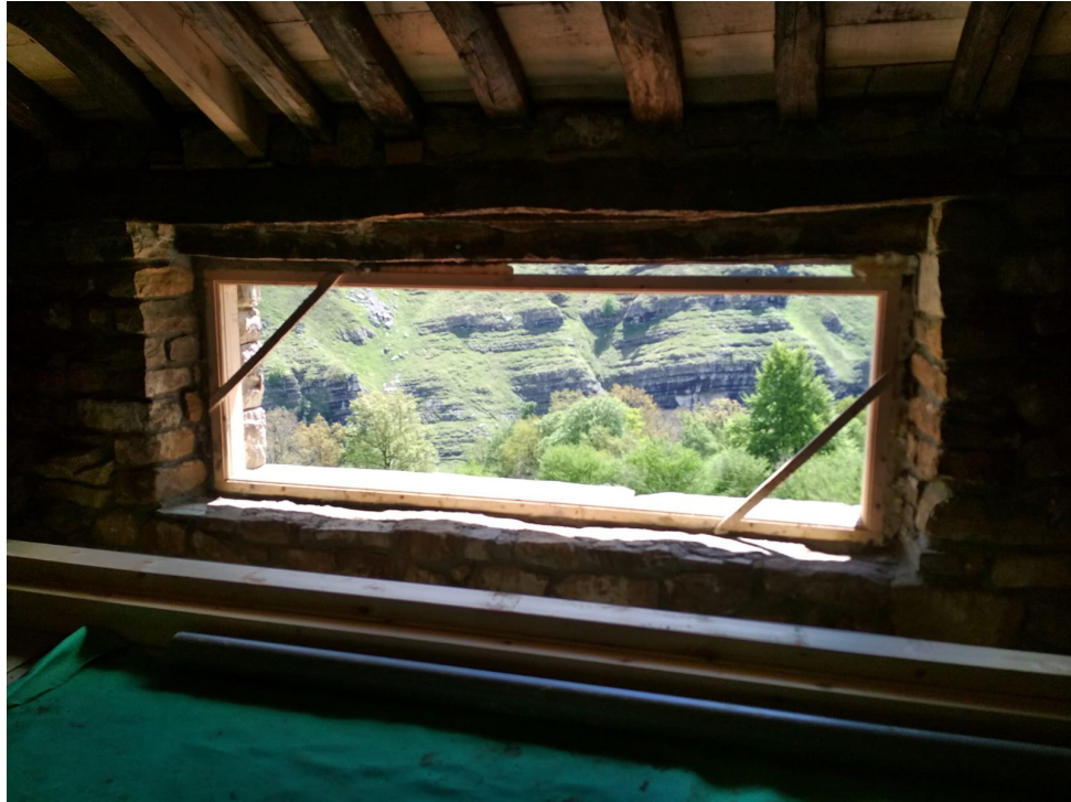
Colocación de pre-marco y marco del ventanal
