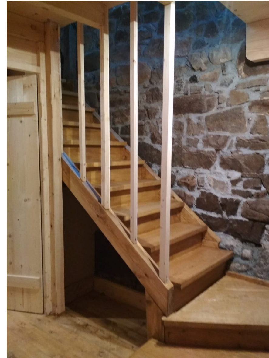
Construcción de escalera interior
