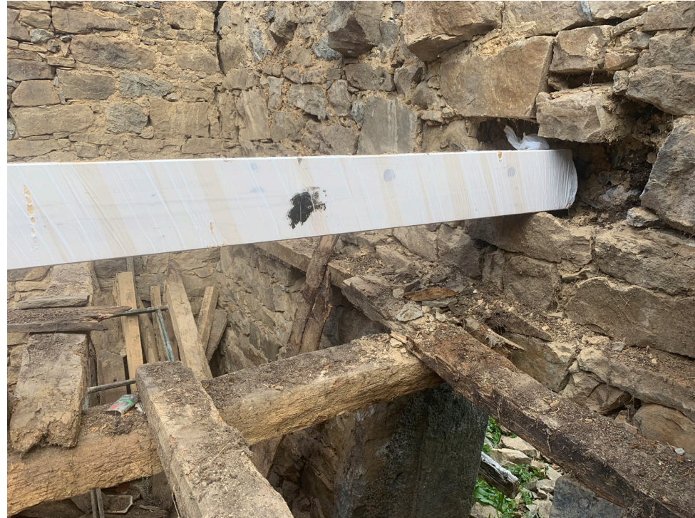
Detalle apoyo viga forjado planta primera
