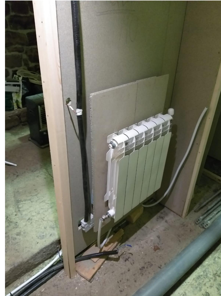
Instalación de sistema de calefacción por medio de radiadores
