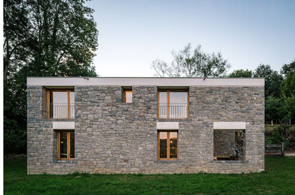
Fachada sur estado rehabilitado
