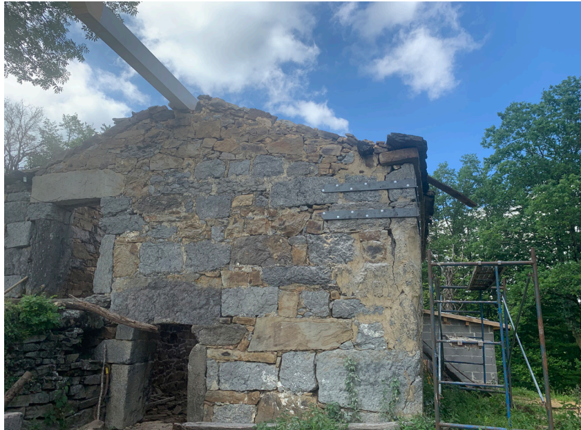
Colocación de viga cumbreira
