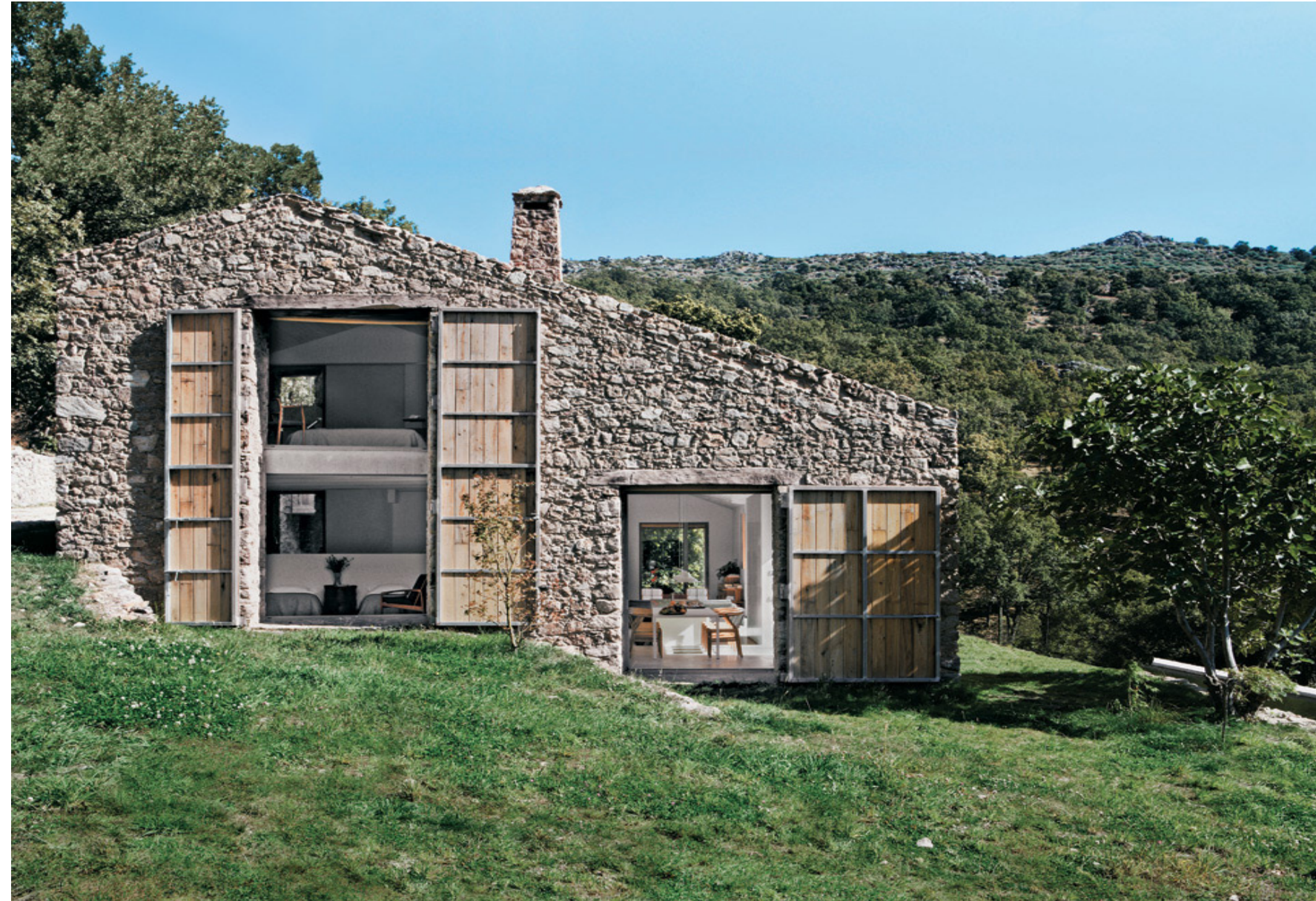
Fachada este estado rehabilitado
