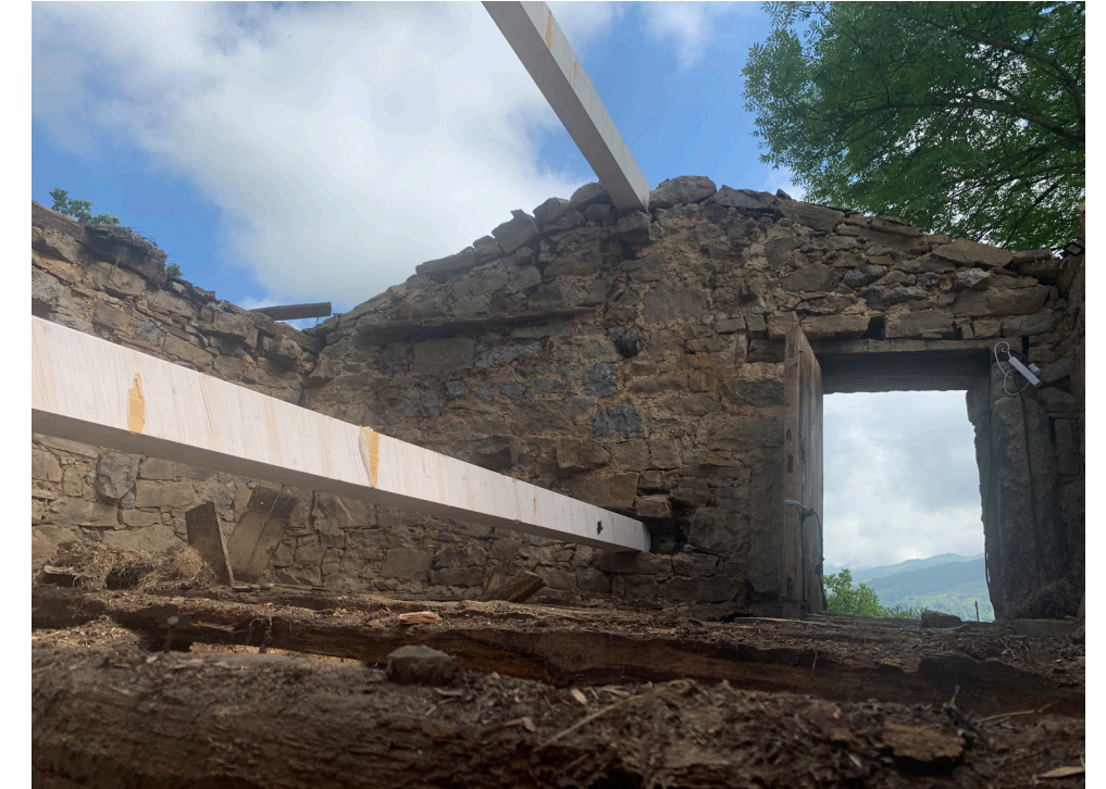
Montaje viga cumbreira y viga forjado planta primera
