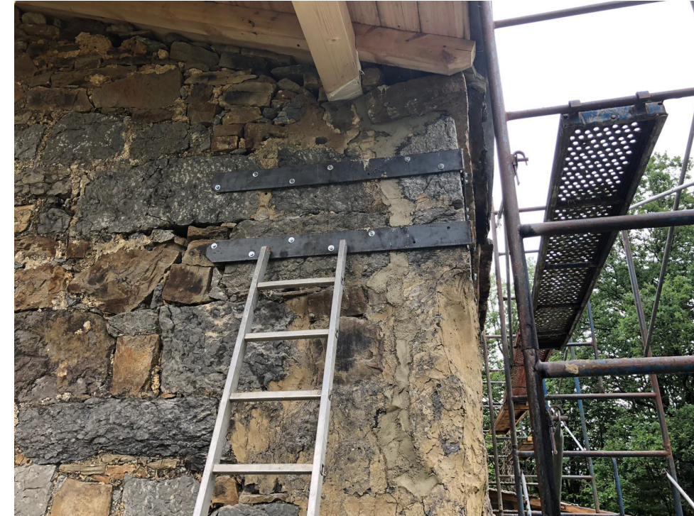
Refuerzo escuadra de acero para solucionar patologia en esquina
