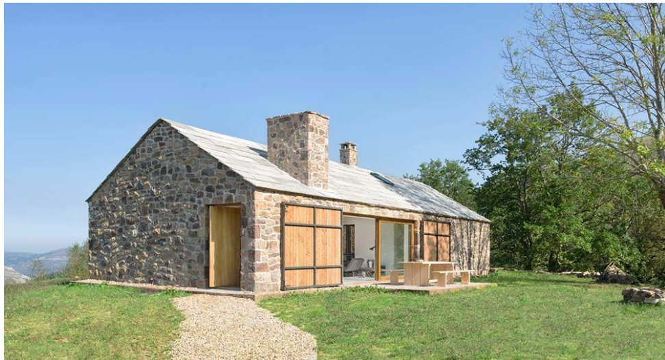
Fachadas sur y oeste estado rehabilitado
