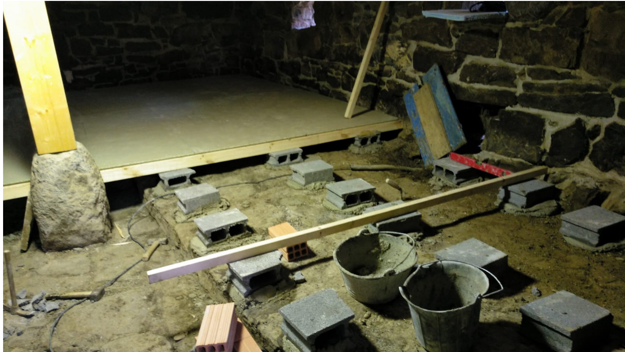
Colocación de suelo en planta baja
