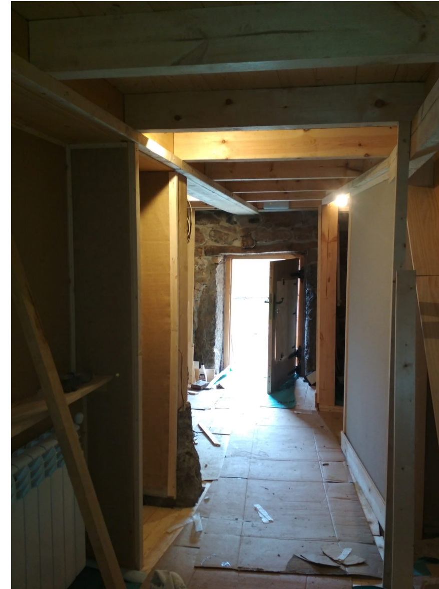
Construcción de tabiques divisorios en planta baja
