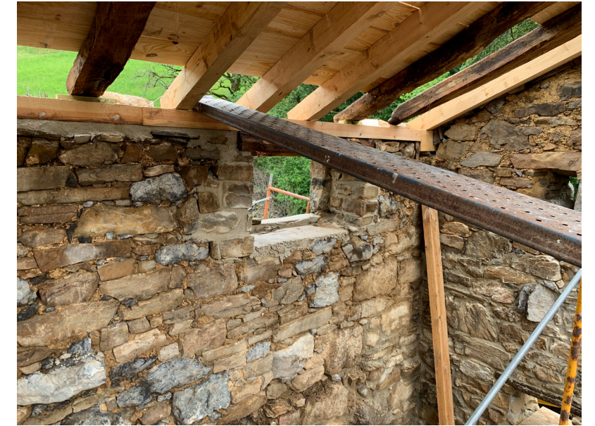
Colocación de tablazón de madera
