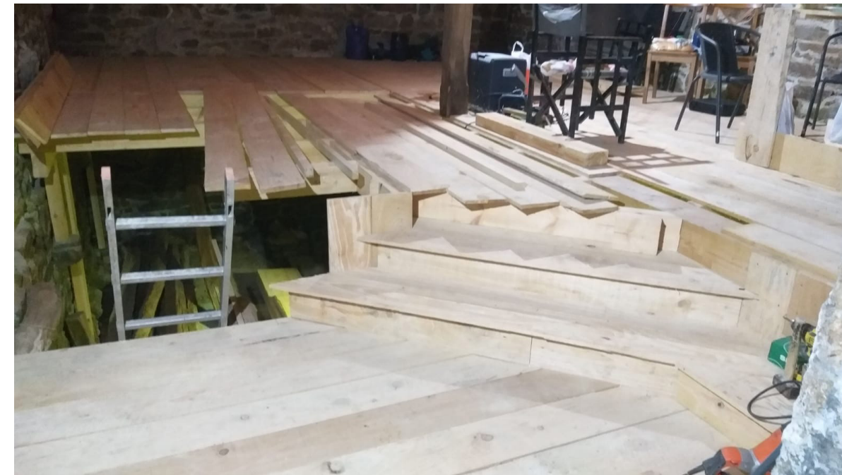
Montaje de tarima de madera aserrada forjado planta primera
