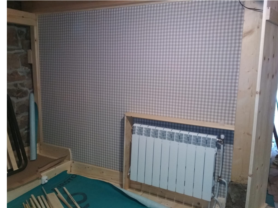
Montaje de detalles de junquillo y rodapiés en tabiques
