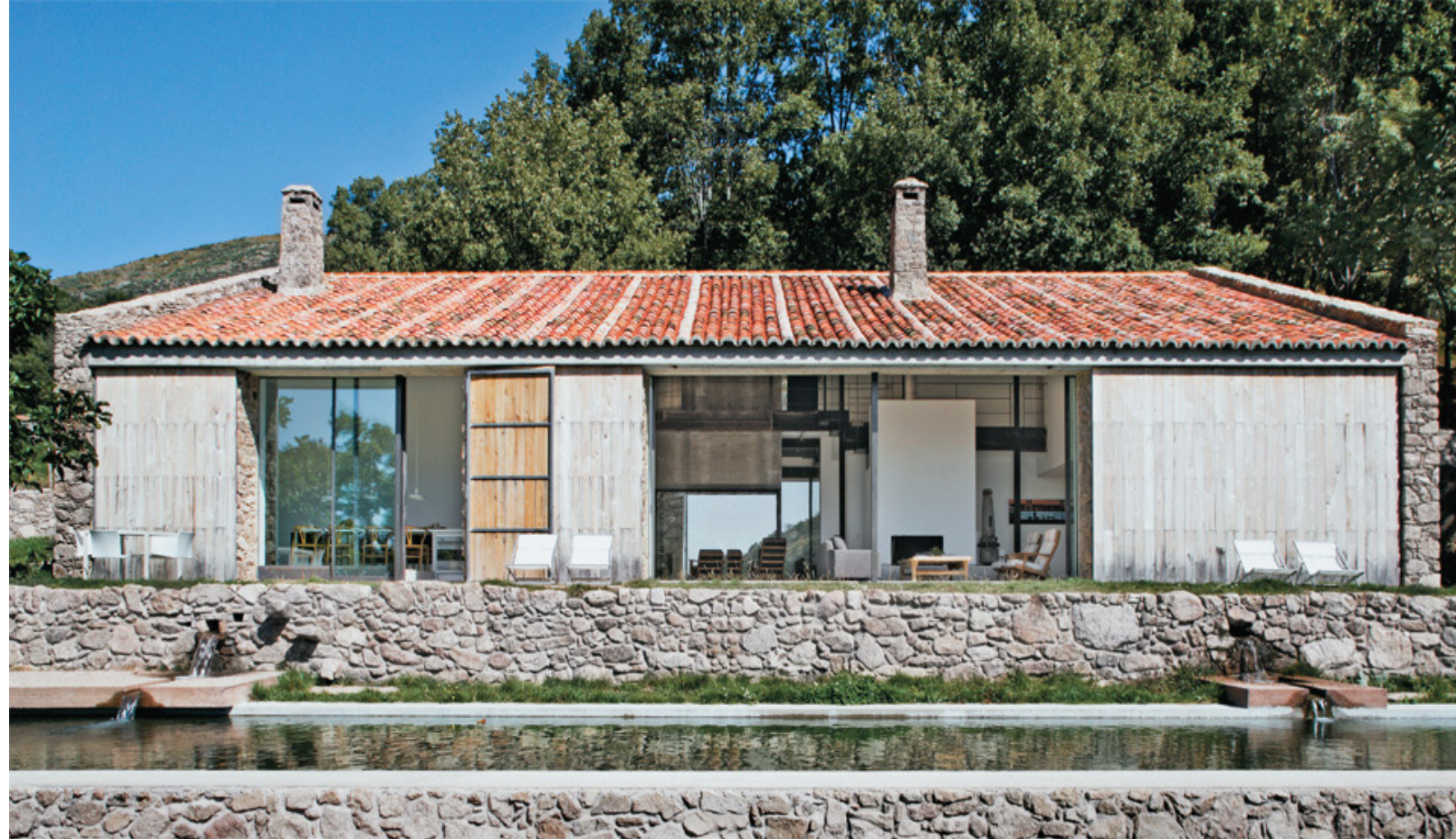
Fachada sur estado rehabilitado
