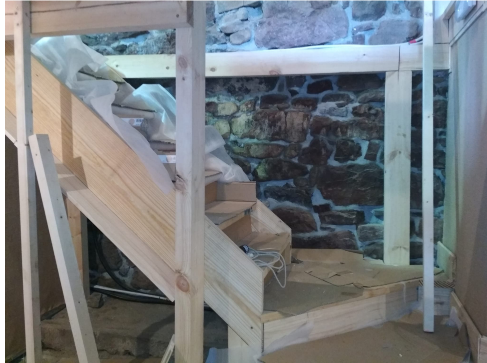
Construcción de escalera interior
