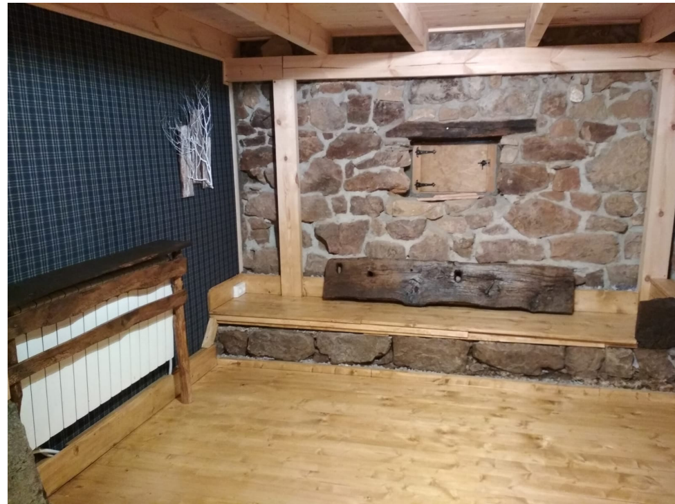
Colocación de entelados en tabiques secos
