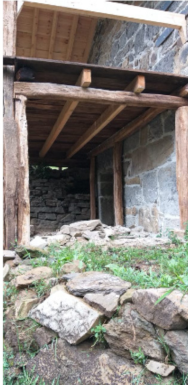
Constucción forjado porche planta primera
