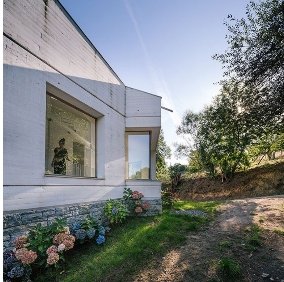
Bloque nuevo estado rehabilitado
