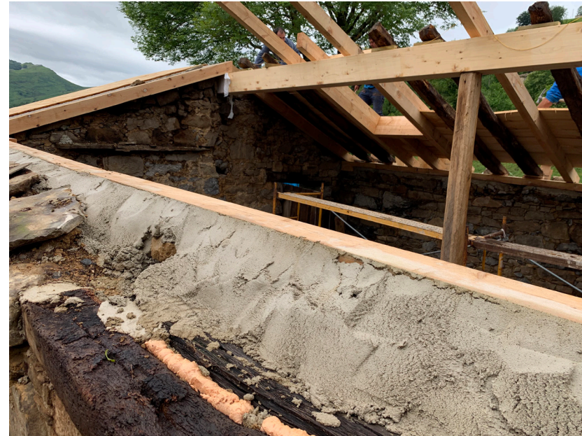
Colocación vigas perimetrales de madera sobre muro
