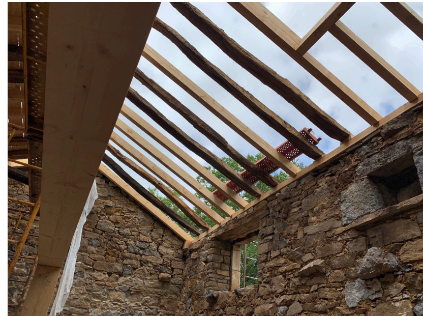
Colocación de pares de madera de cubierta
