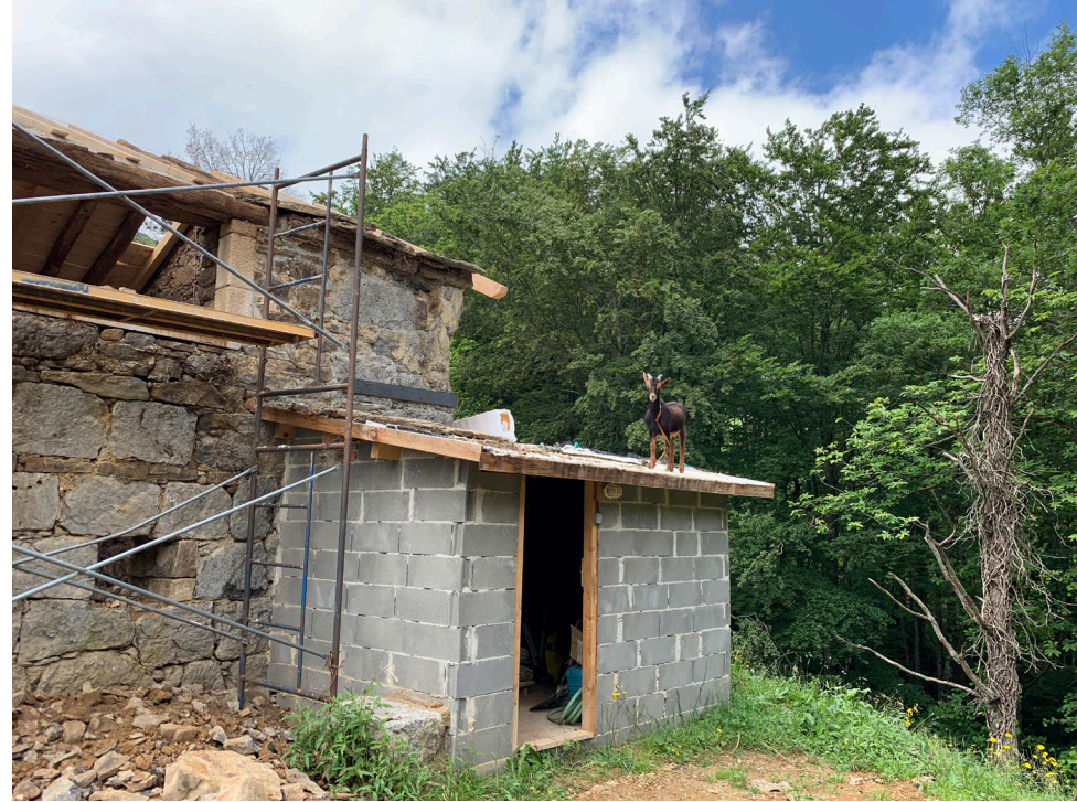
Construcción de cuarto de instalaciones
