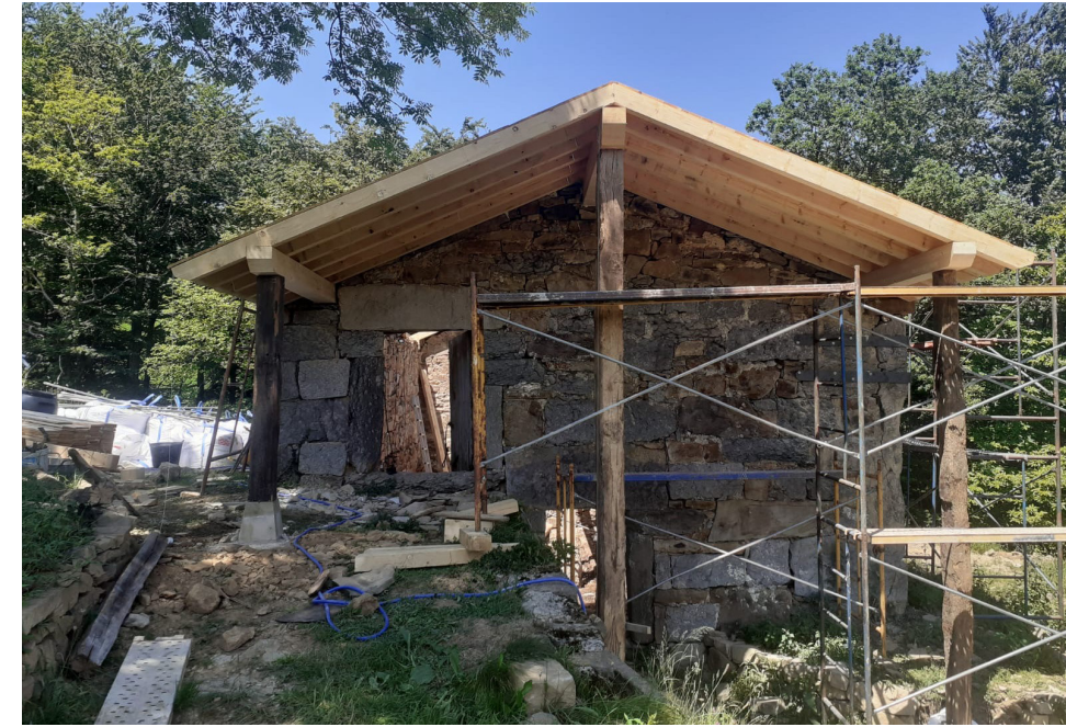
Formación de porche en planta primera
