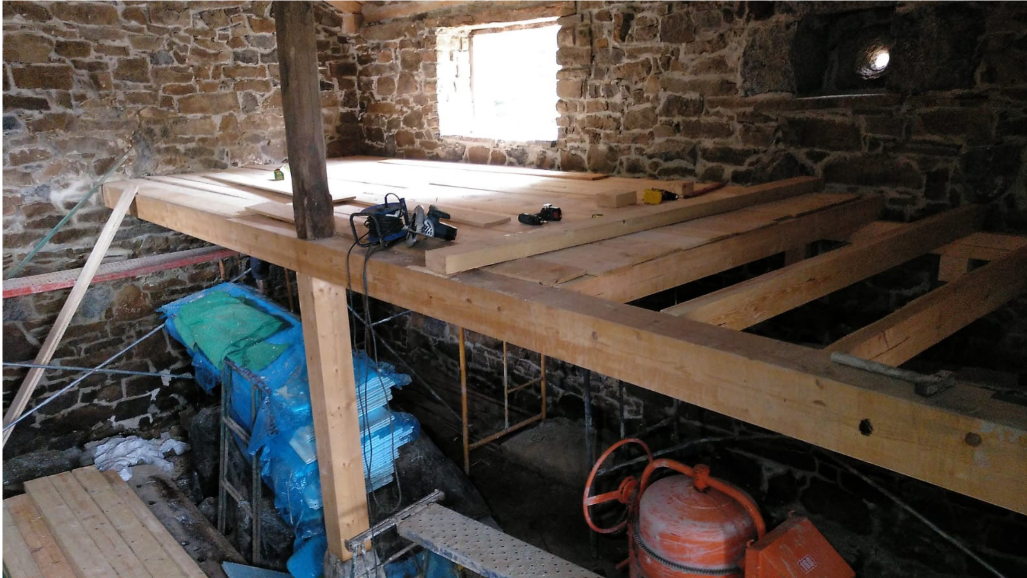
Montaje forjado planta primera
