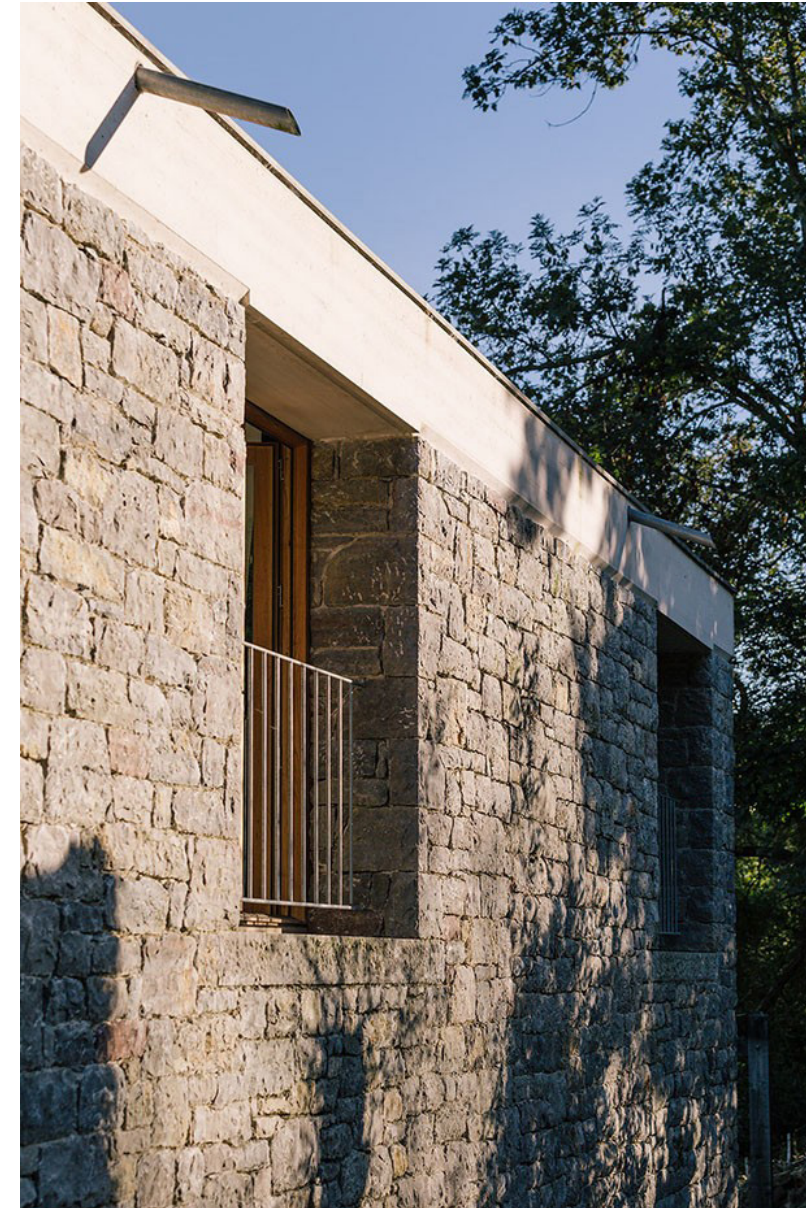
Fachada oeste estado rehabilitado
