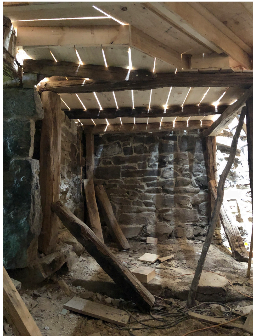
Estructura soporte plataforma de acceso
