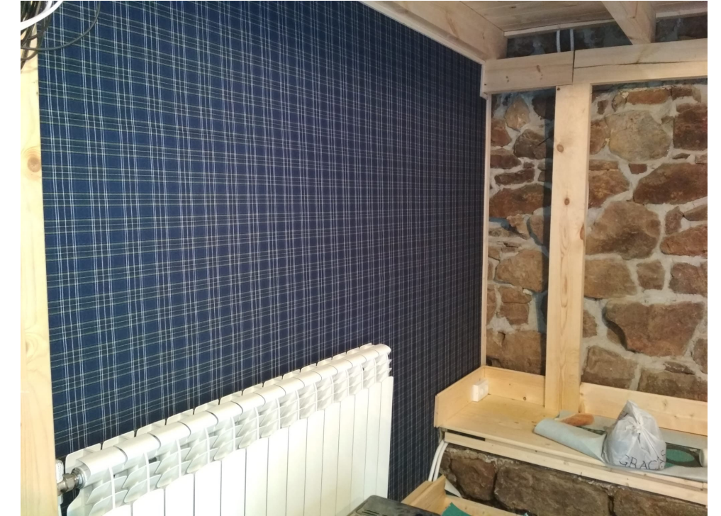
Montaje de detalles de junquillo y rodapiés en tabiques
