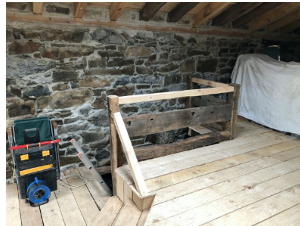
Instalación de barandilla hueco de escalera
