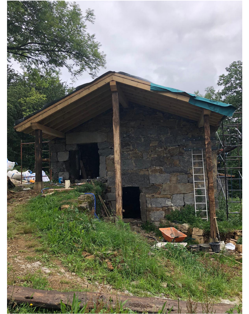
Formación de porche en planta primera
