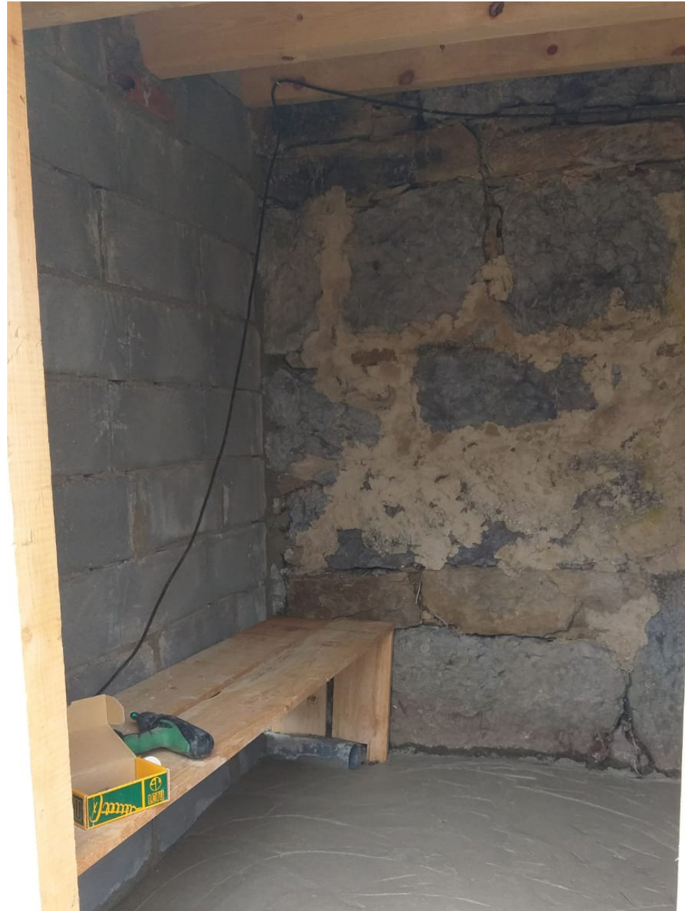
Construcción de cuarto de instalaciones
