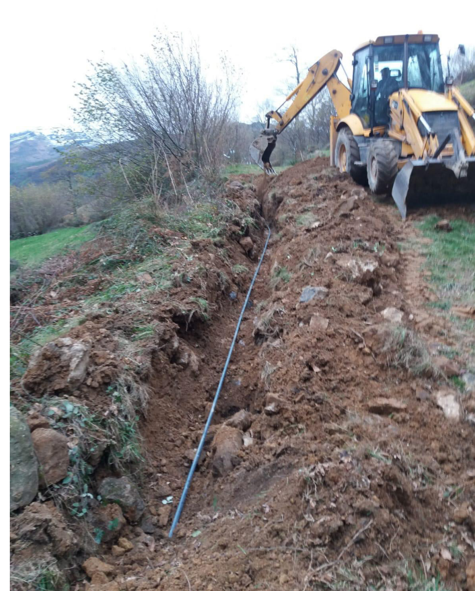
Apertura de zanja para acometida de agua
