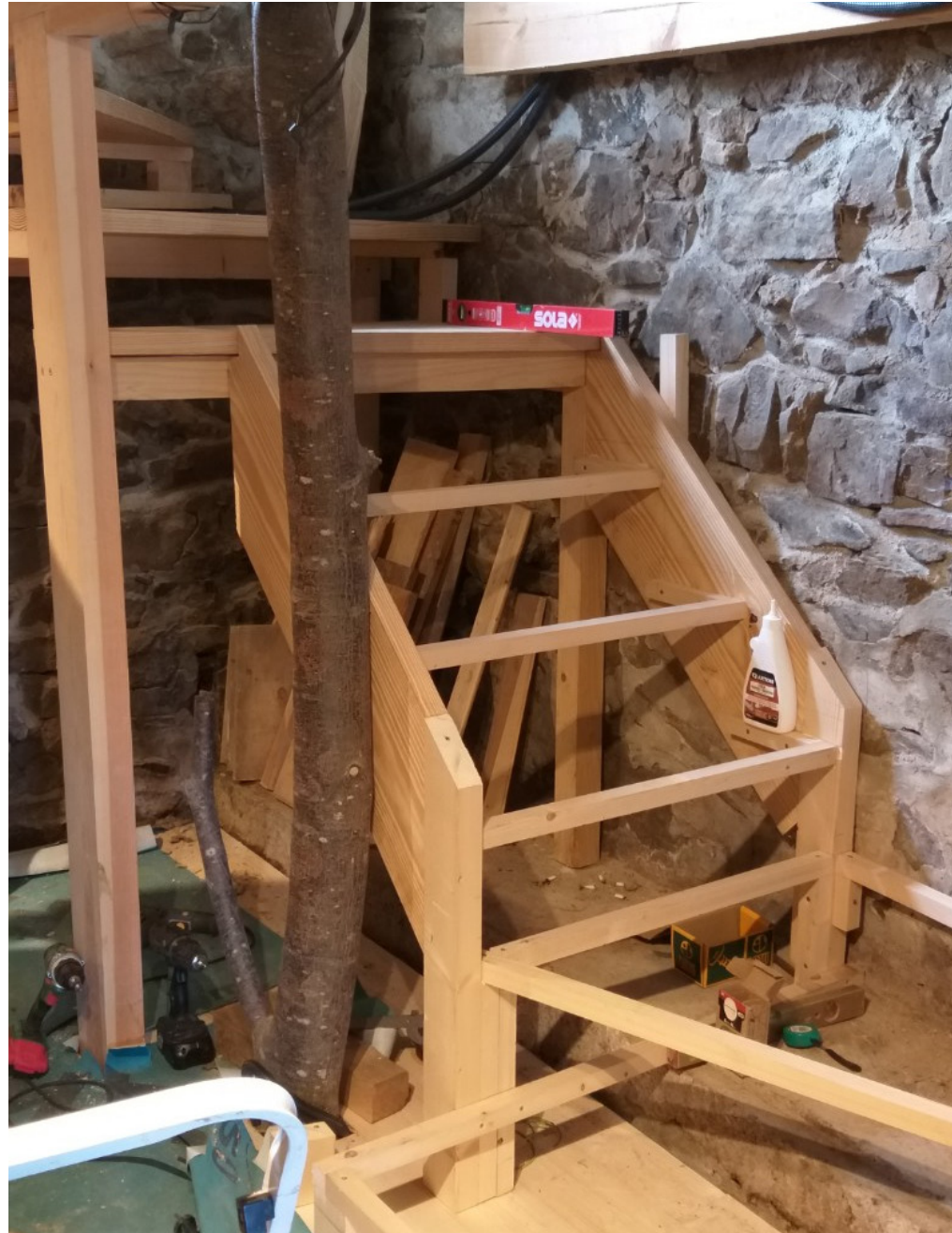
Construcción de escalera interior
