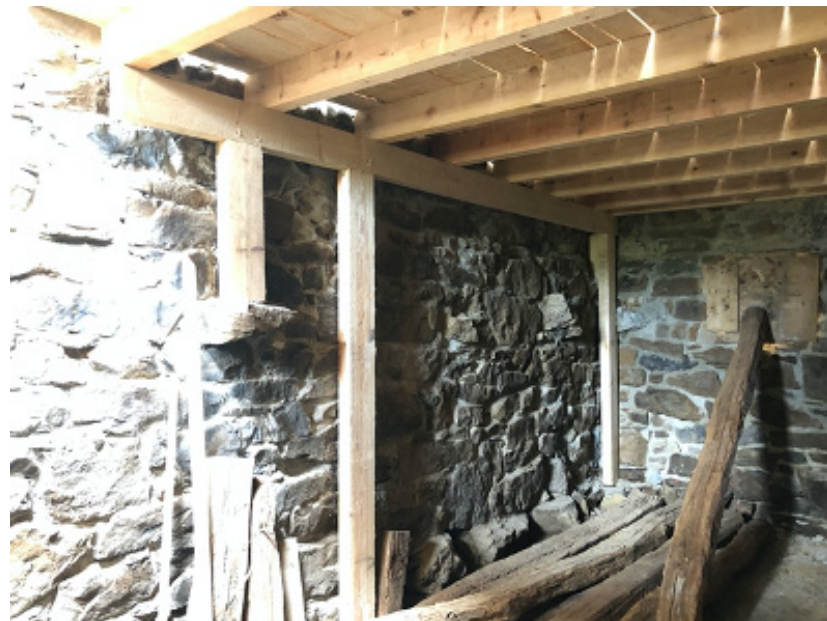
Montaje de estructura forjado planta primera
