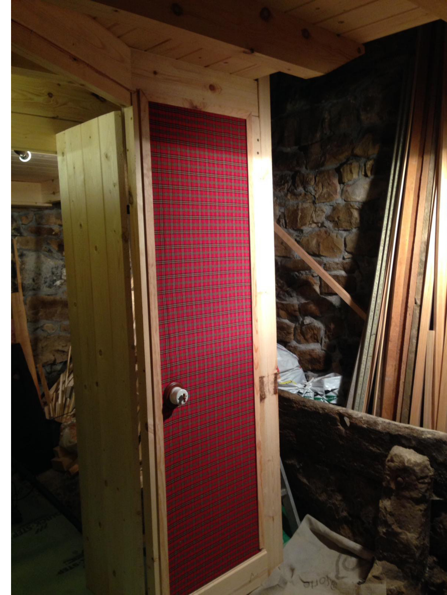
Colocación de entelados en tabiques secos
