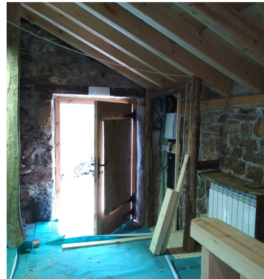
Colocación de puerta de acceso a cabaña
