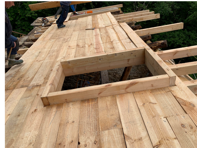
Colocación de tablazón de madera
