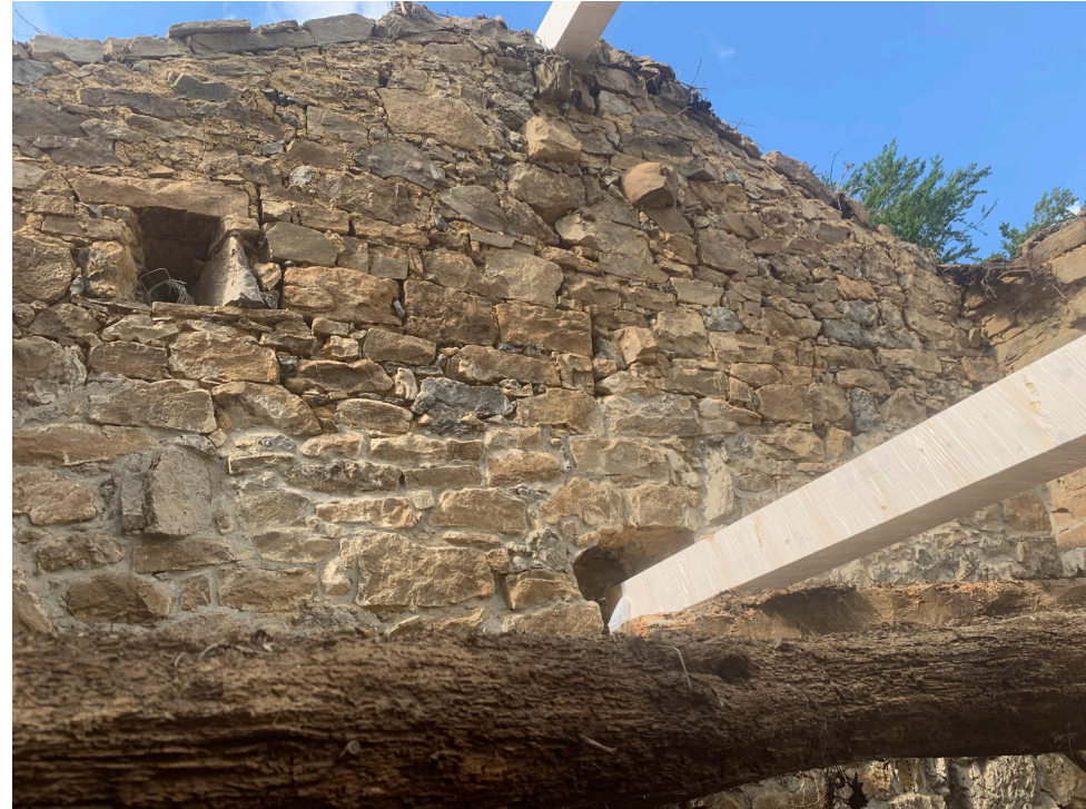
Detalle apoyo viga forjado planta primera
