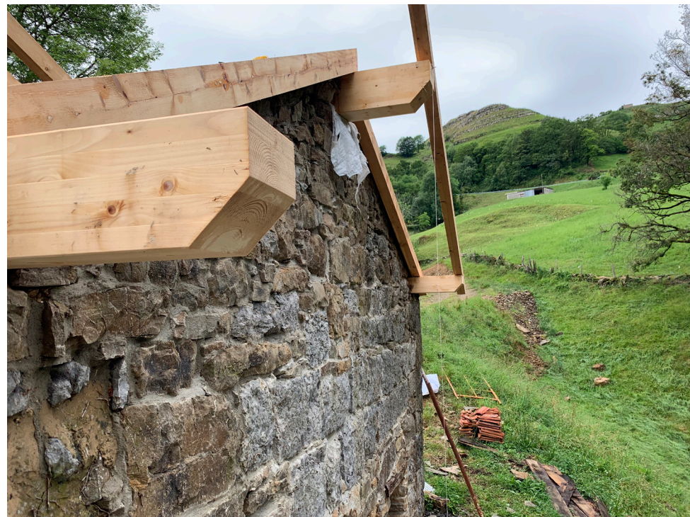
Construcción de faldones de cubierta
