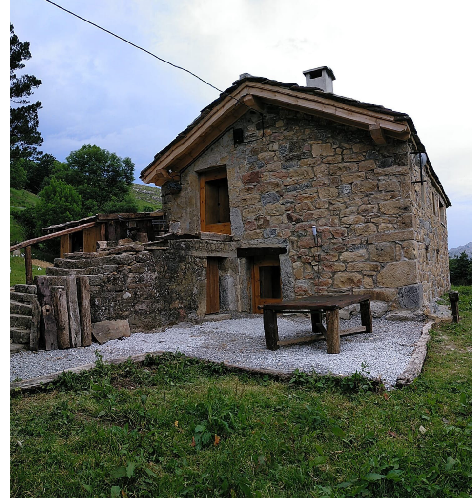
Fachada sur estado rehabilitado
