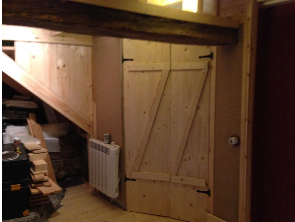
Colocación de carpinterías interiores
