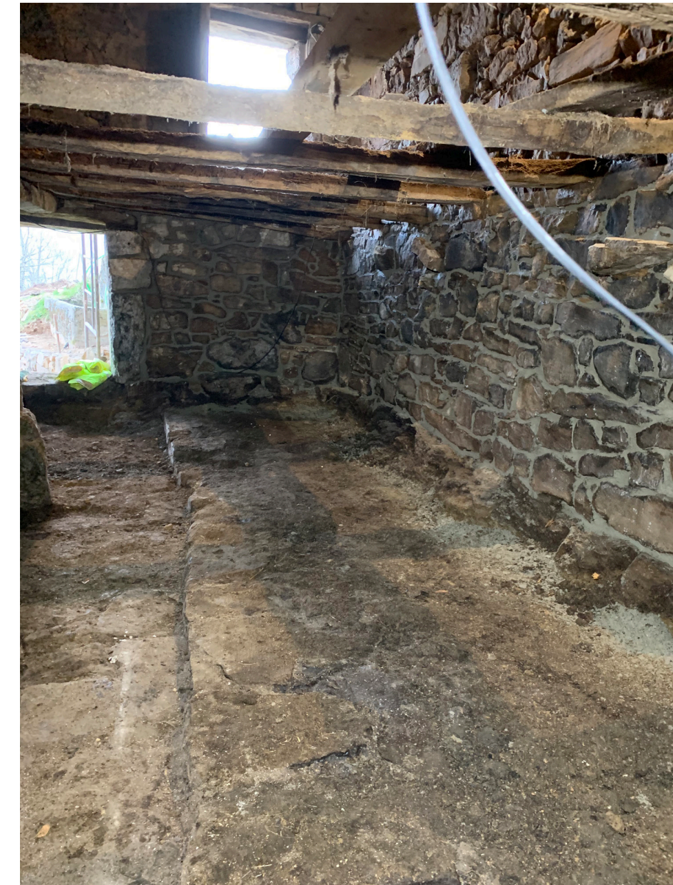
Rejunteo de yendas con mortero de cemento
