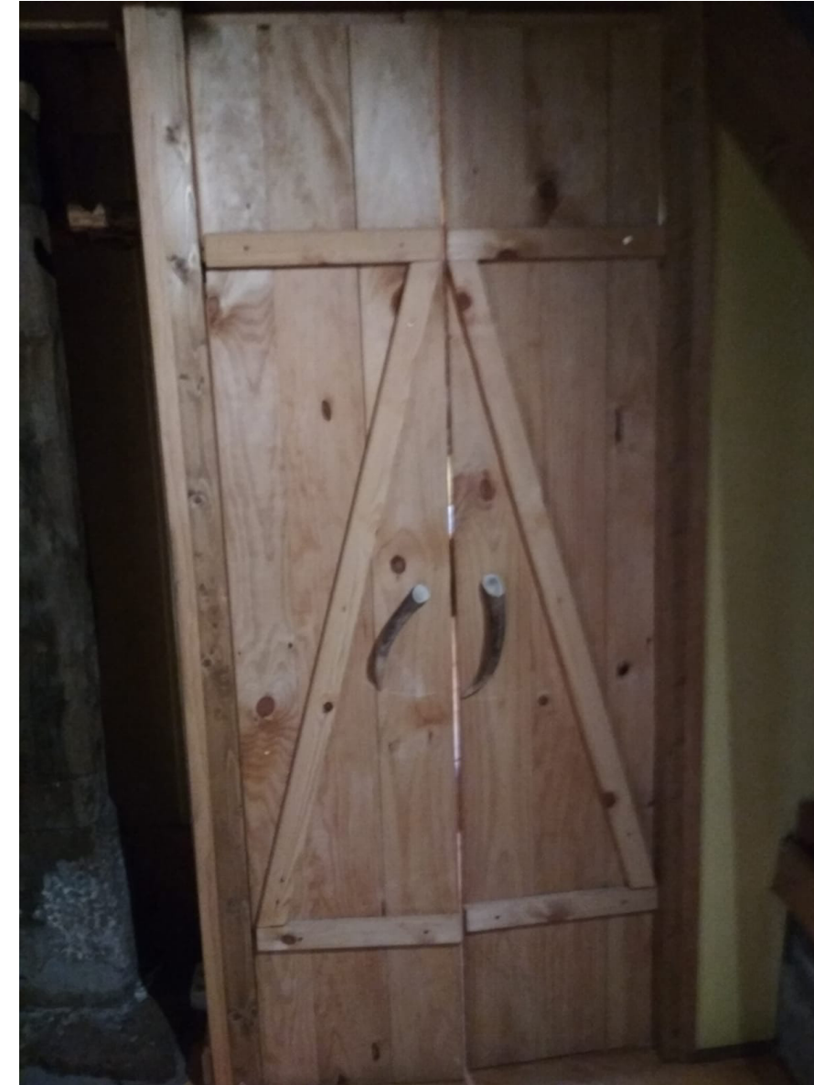
Colocación de carpinterías interiores
