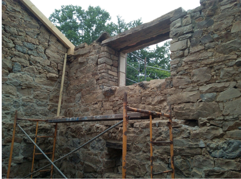
Apertura de huecos en forma de ventanas
