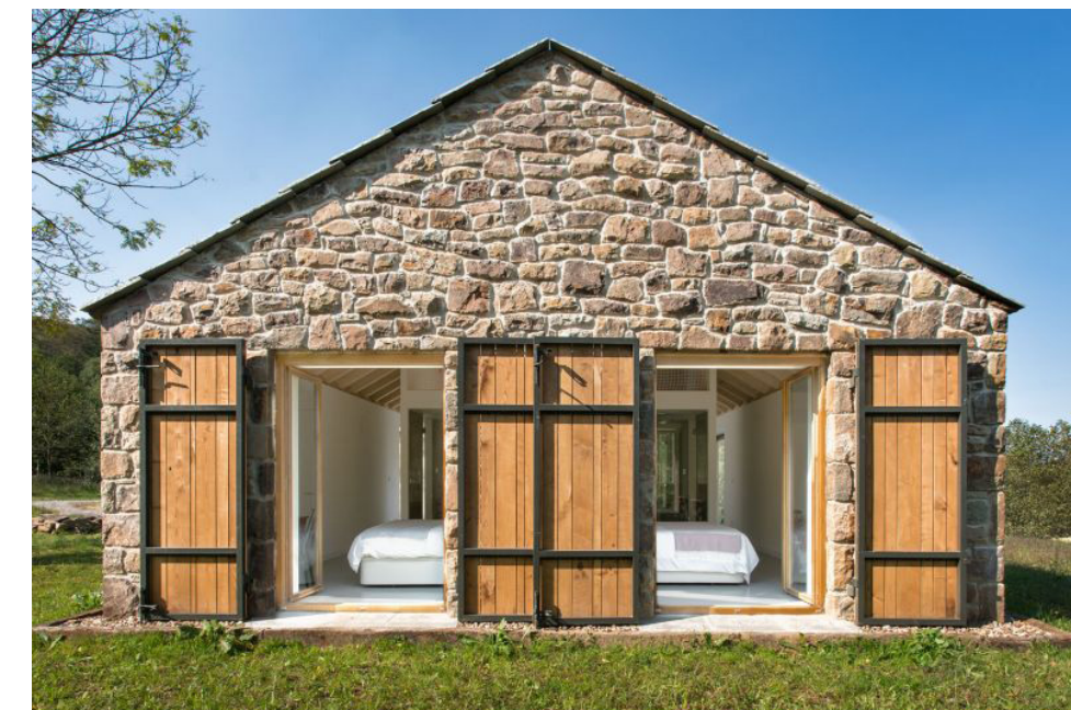
Fachada este estado rehabilitado
