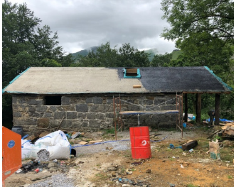
Solera de hormigón en cubierta
