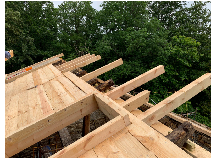
Colocación de tablazón de madera
