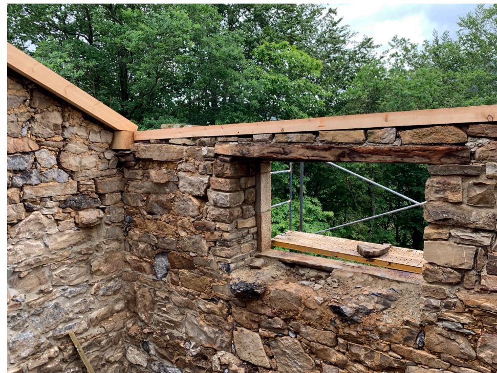
Colocación vigas perimetrales de madera sobre muro
