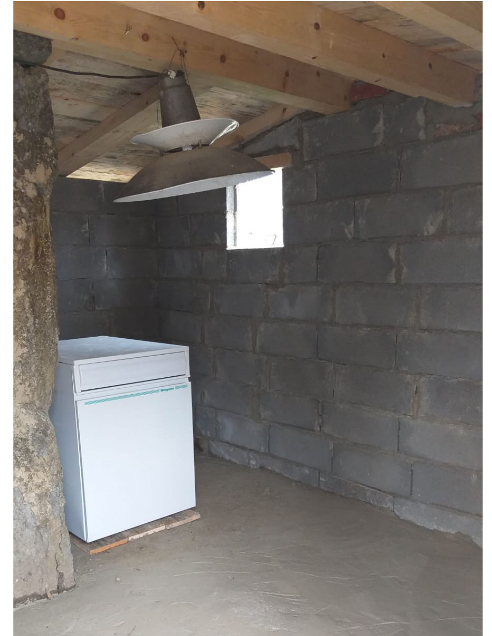
Construcción de cuarto de instalaciones
