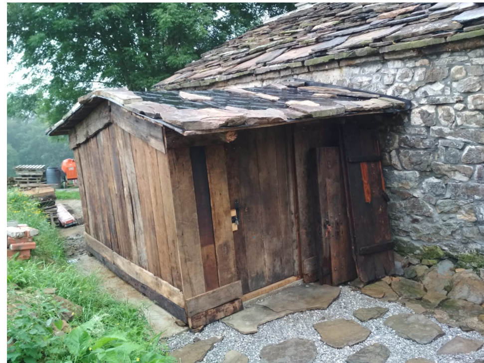
Colocación de acabado de madera en cuarto de instalaciones
