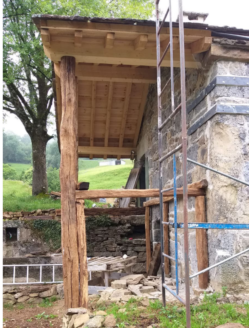
Formación de porche en planta primera
