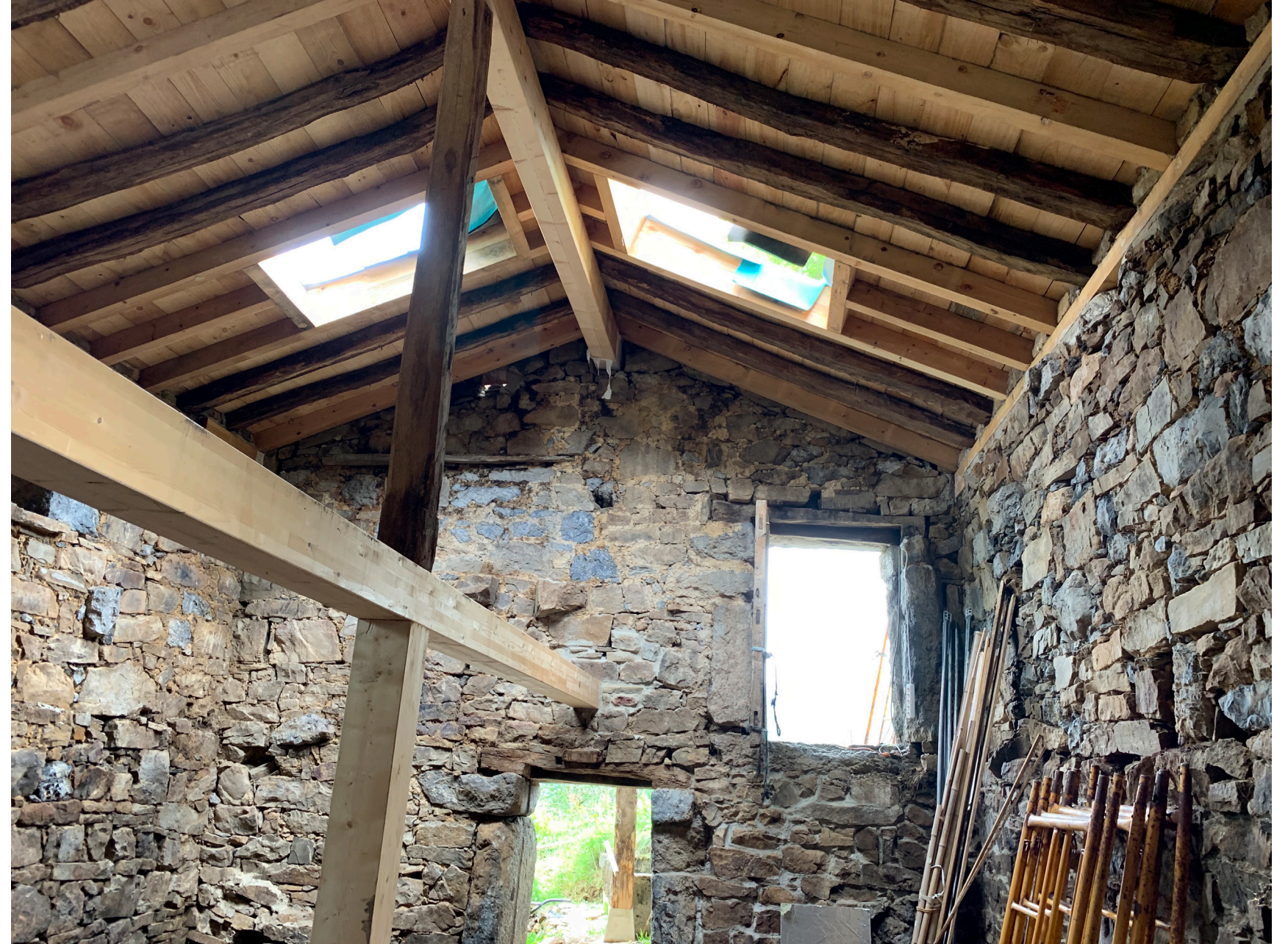
Aspecto interior de la cubierta
