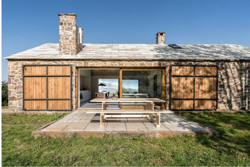
Espacio exterior estado rehabilitado
