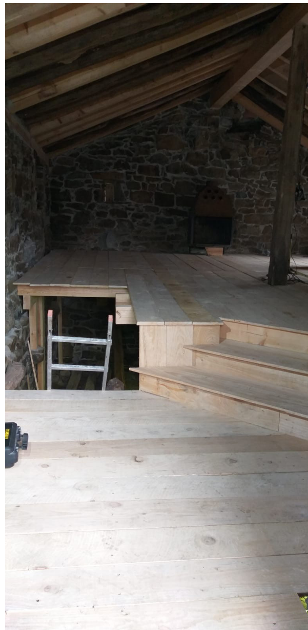
Montaje de tarima de madera aserrada forjado planta primera
