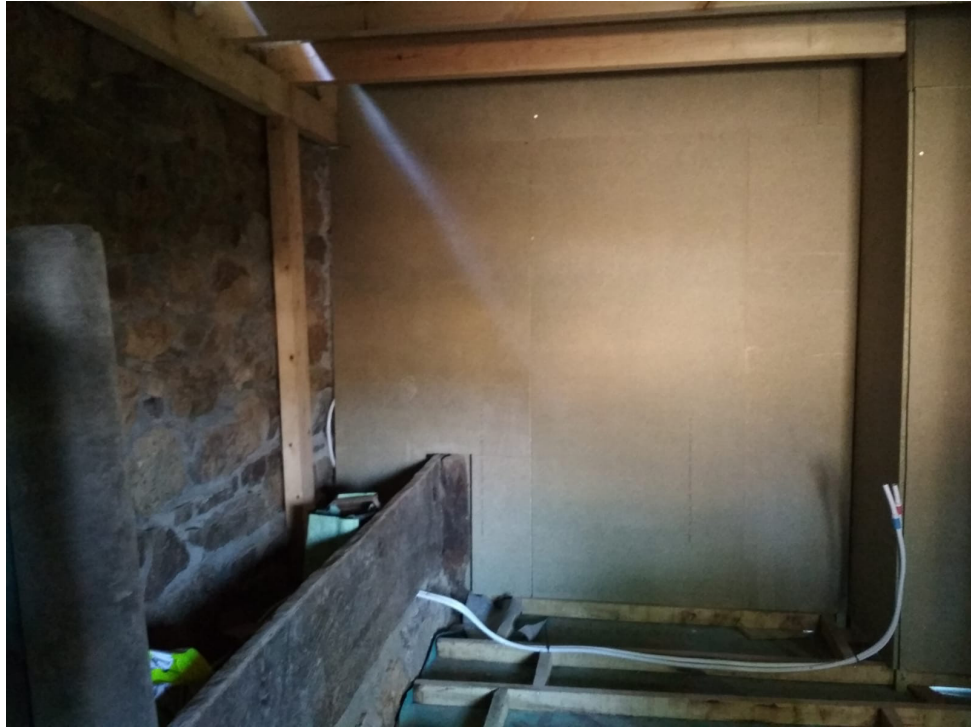
Colocación de instalación de AFS y ACS
