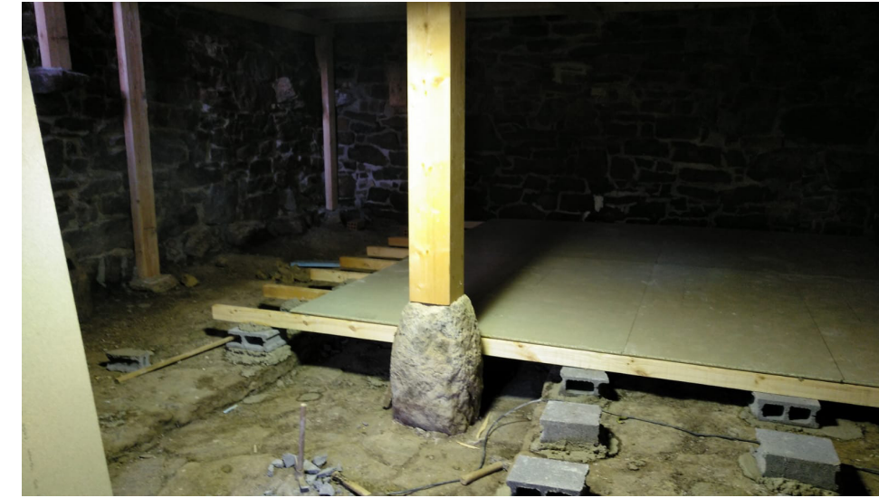
Colocación de suelo en planta baja
