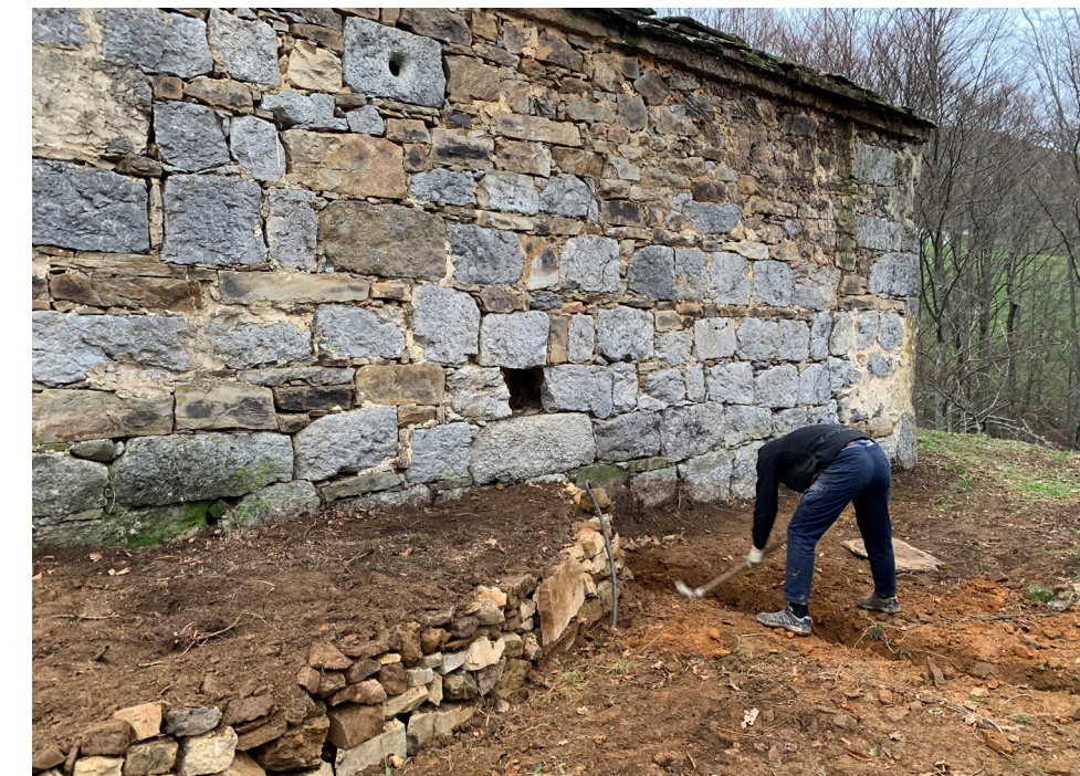
Apertura de zanja para colectores de saneamiento
