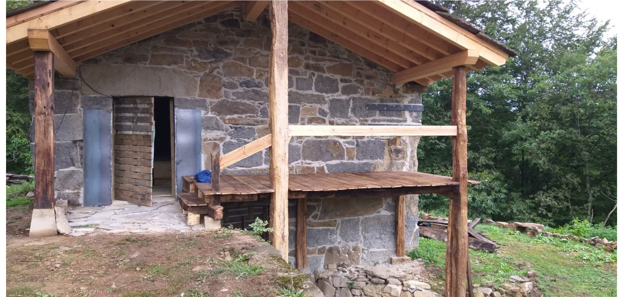
Constucción forjado porche planta primera
