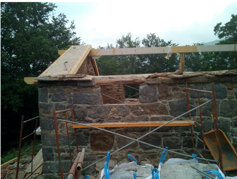
Construcción de zunchos perimetrales de hormigón
