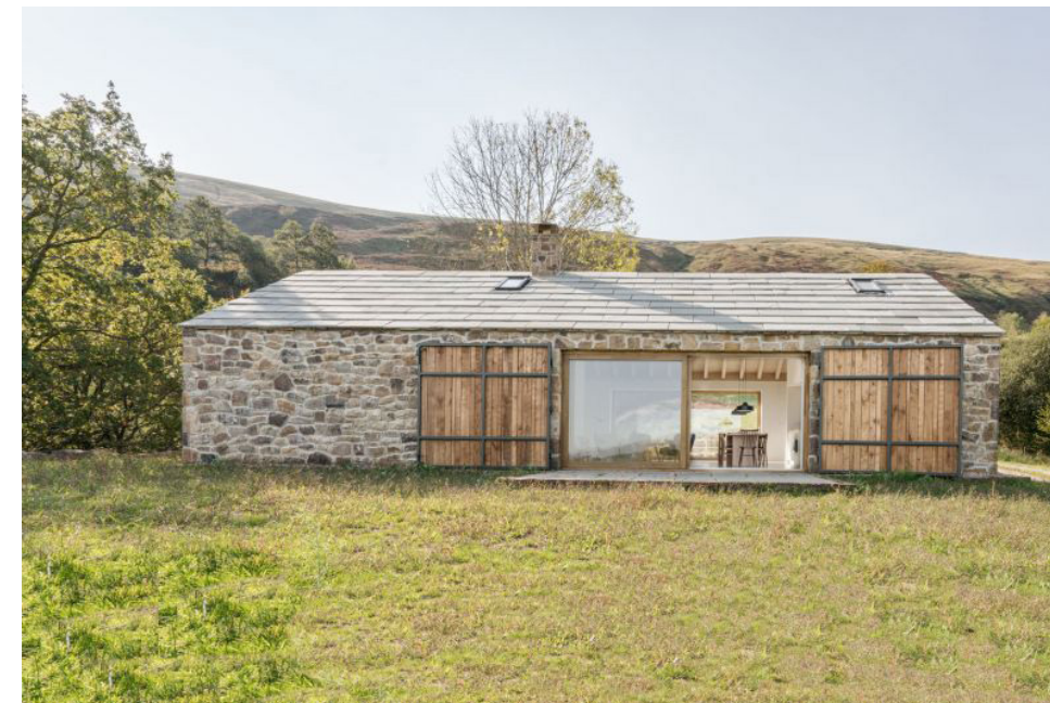
Fachada norte estado rehabilitado
