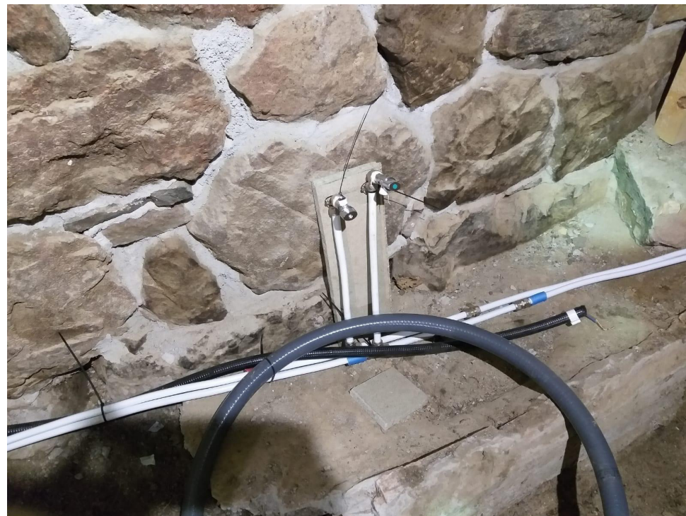
Instalación de sistema de calefacción por medio de radiadores
