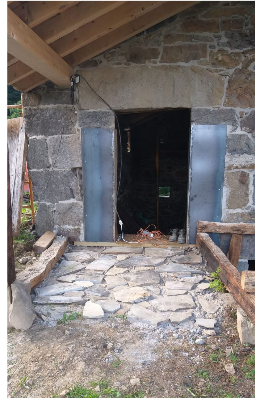
Refuerzo escuadra de acero para solucionar patologia en puerta de acceso
