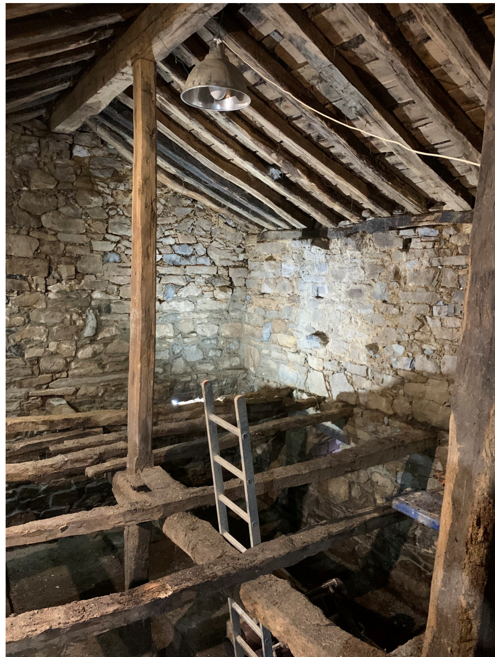
Estado interior tras limpieza de muros
