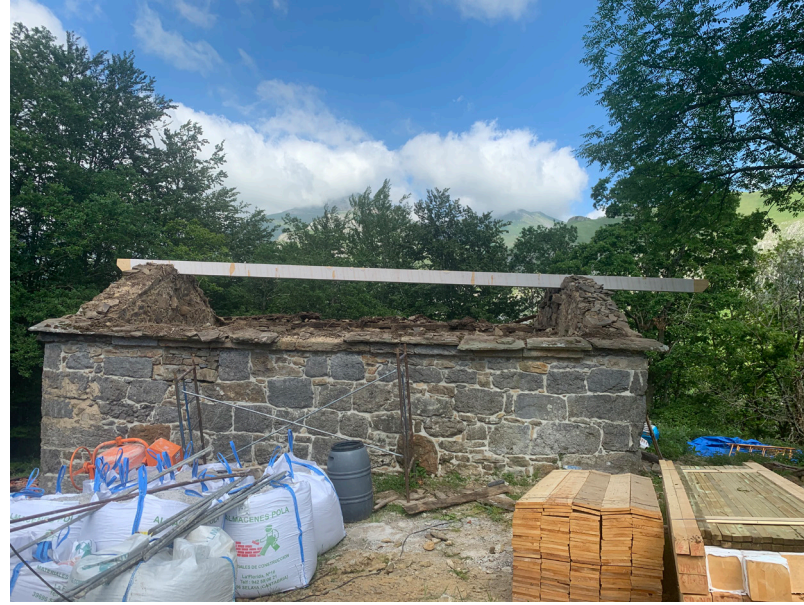
Colocación de viga cumbreira
