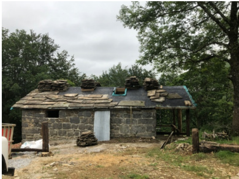
Colocación de lasras de piedra
