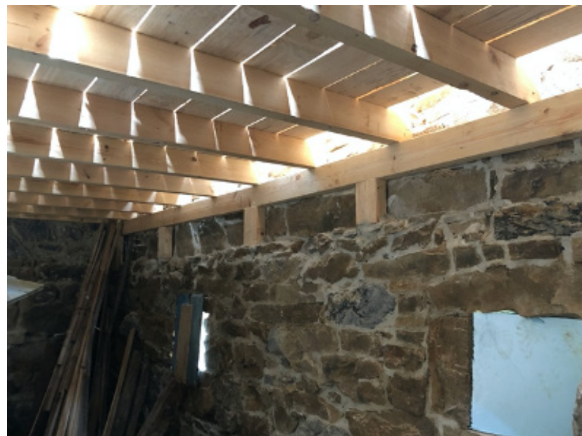
Enanos de apoyo viga durmiente forjado planta primera
