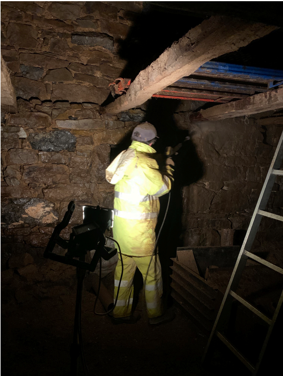
Limpieza de muros de piedra por medio de agua a presión
