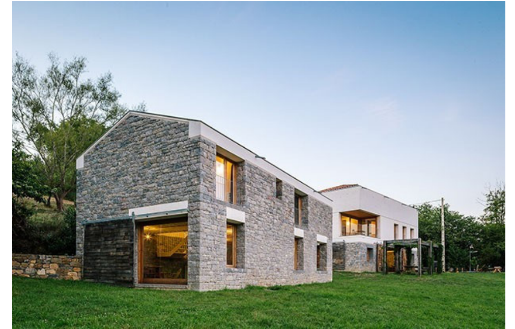
Fachadas sur y este estado rehabilitado
