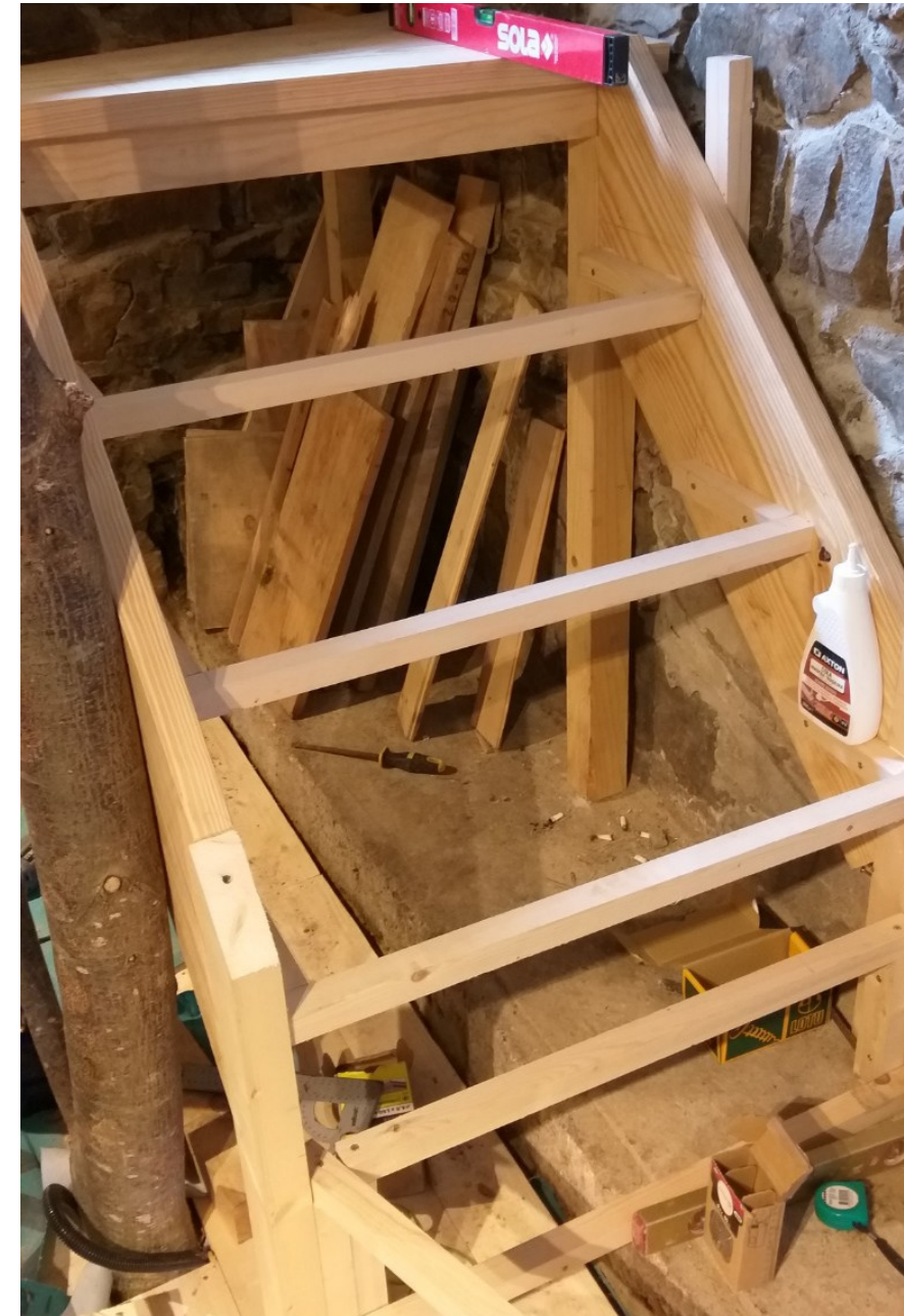
Construcción de escalera interior
