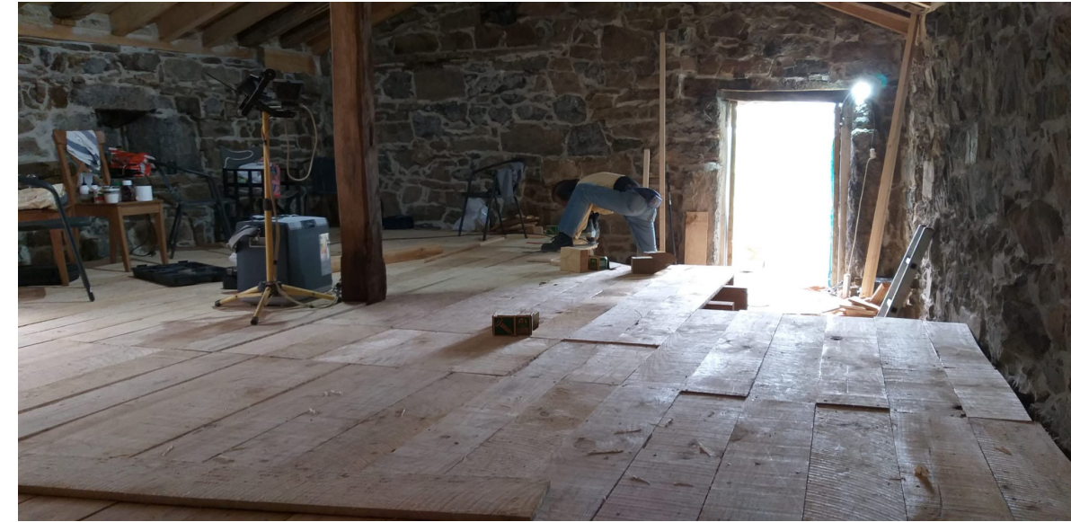
Montaje de tarima de madera aserrada forjado planta primera
