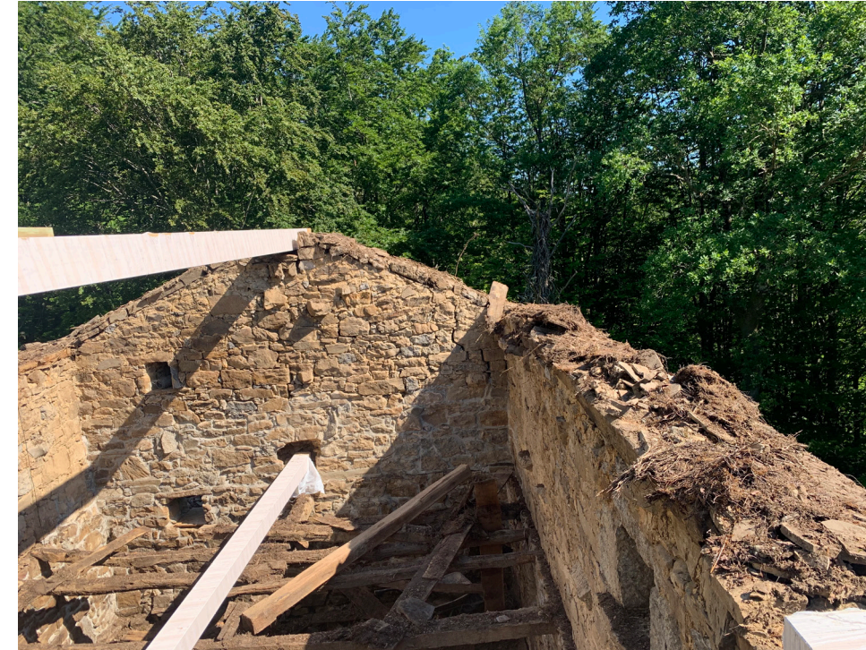
Montaje viga cumbreira y viga forjado planta primera
