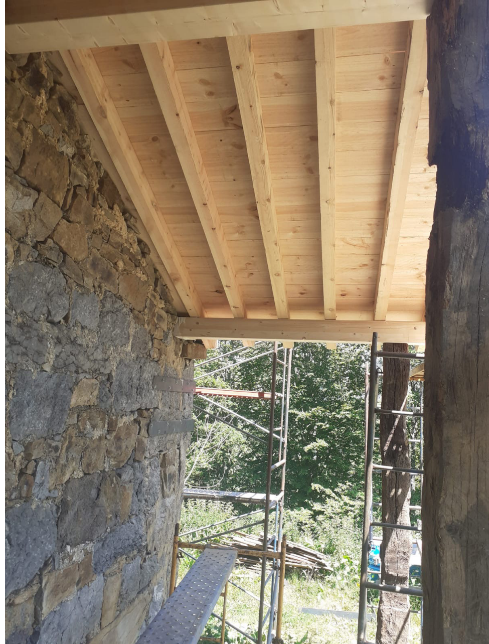
Formación de porche en planta primera
