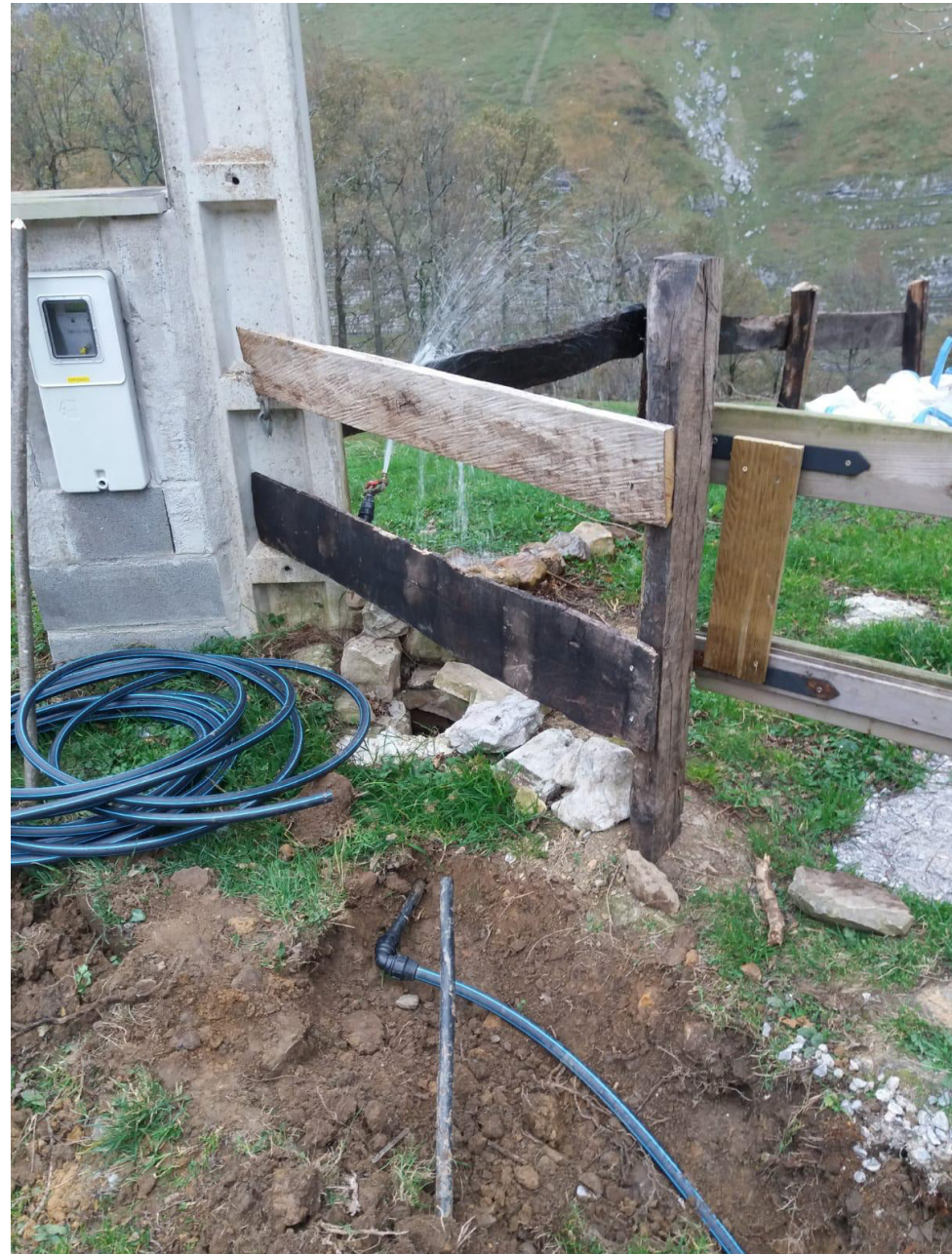
Apertura de zanja para acometida de agua
