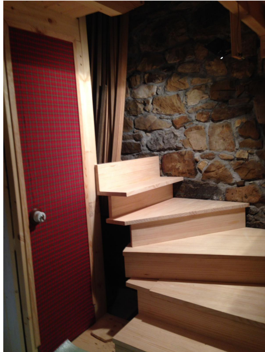
Construcción de escalera interior
