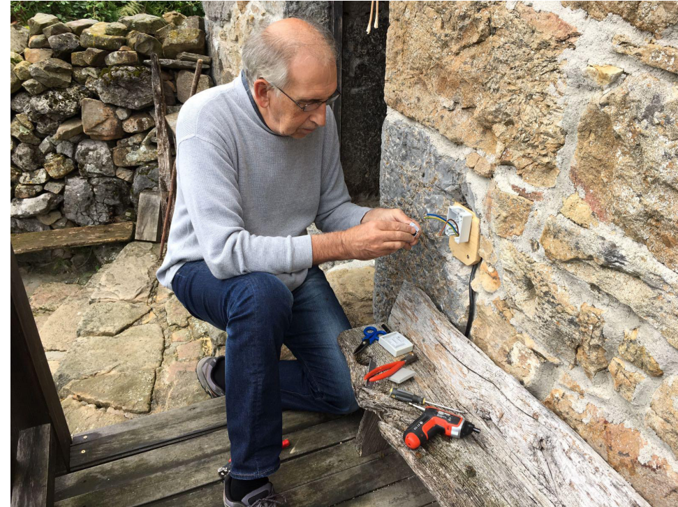
Instalación de enchufes
