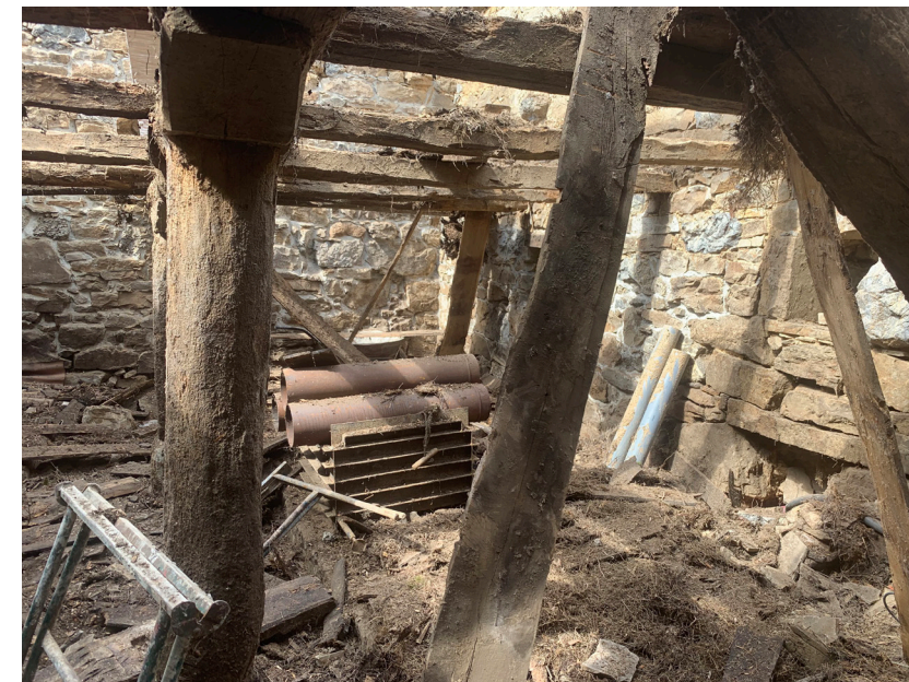
Desmonte de cubierta original
