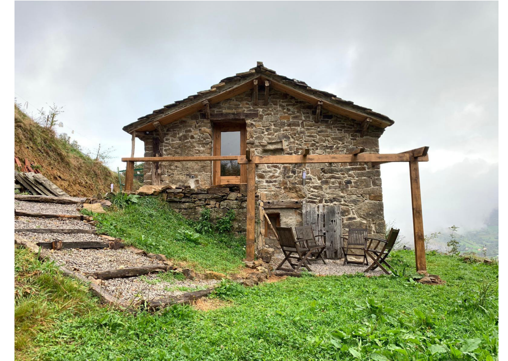
Fachada sur estado rehabilitado
