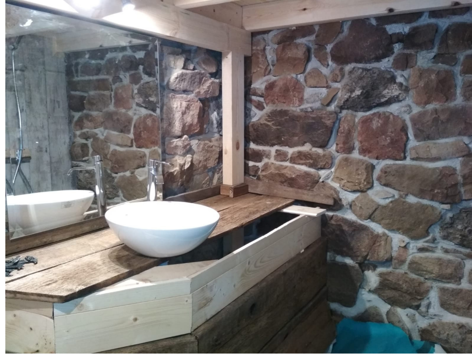
Instalación de lavabo en baño
