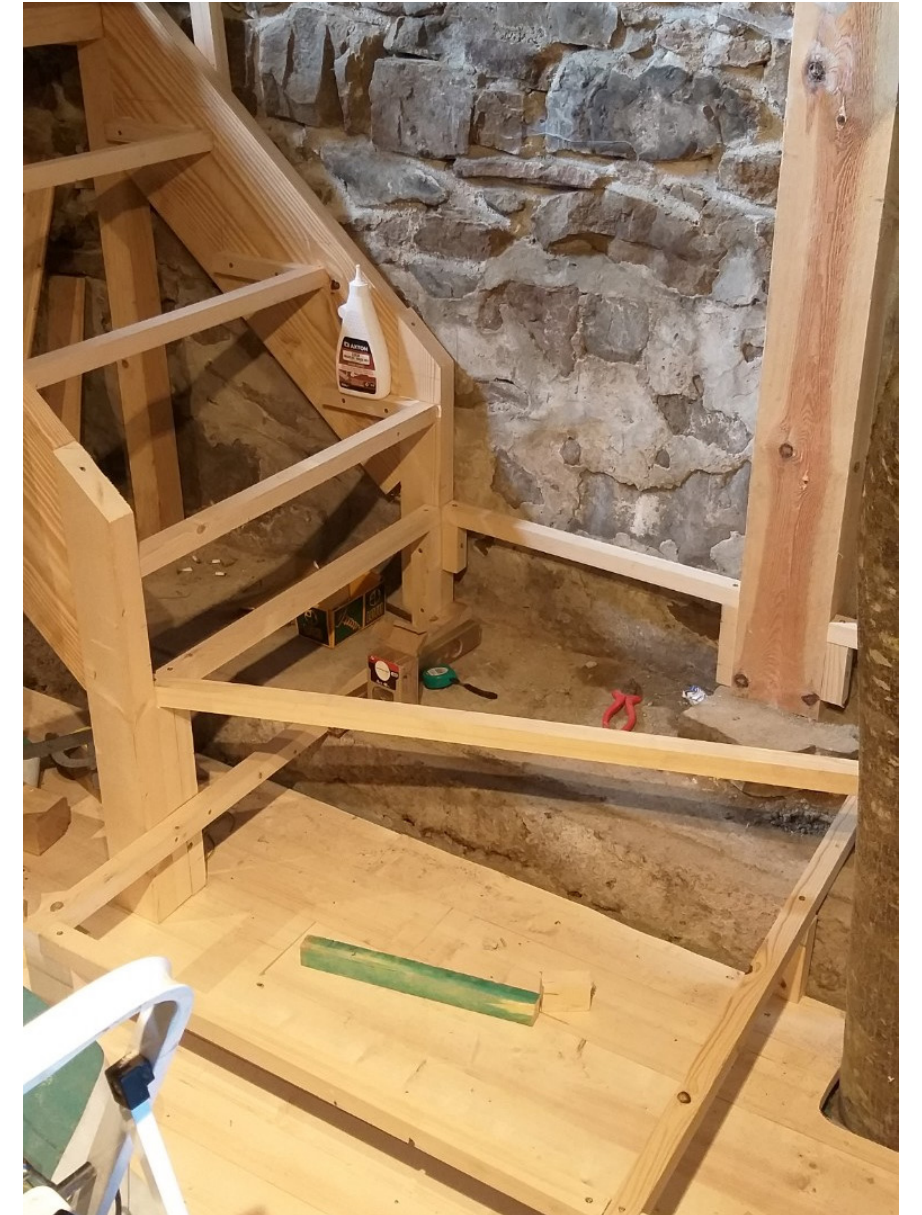
Construcción de escalera interior
