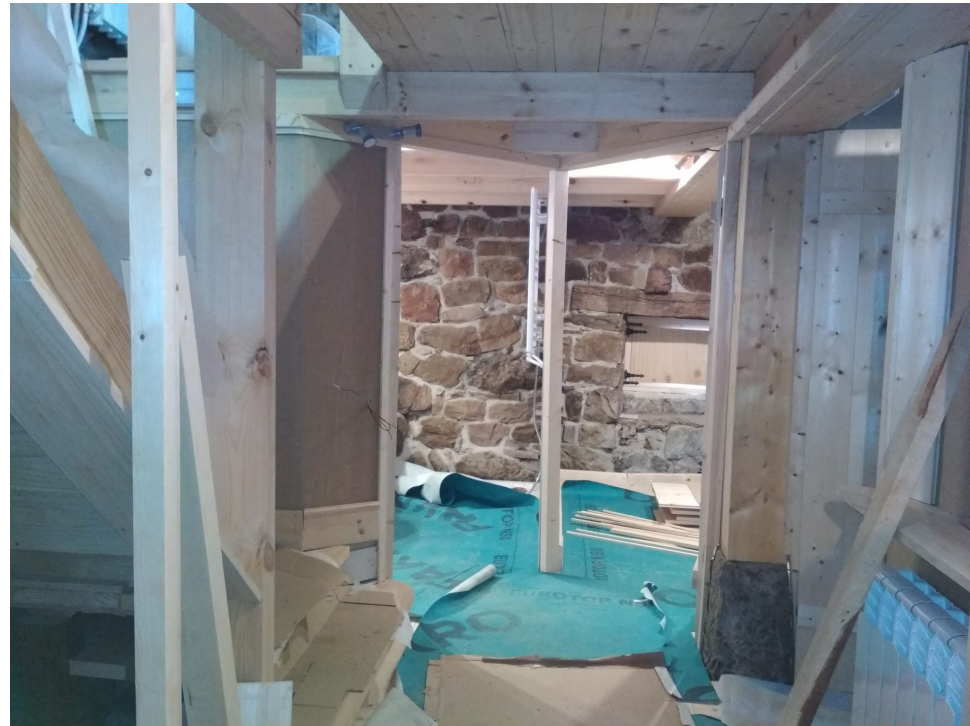
Construcción de tabiques divisorios en planta baja
