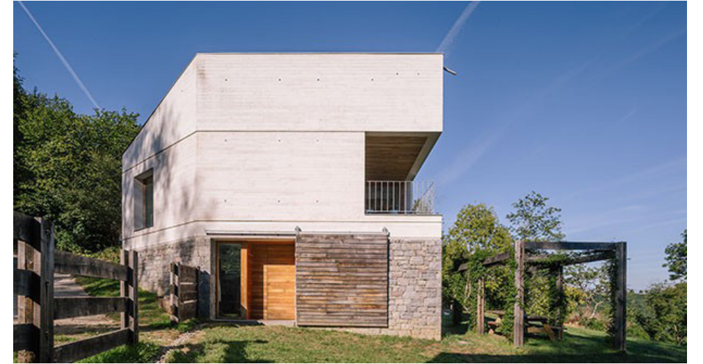
Bloque nuevo estado rehabilitado
