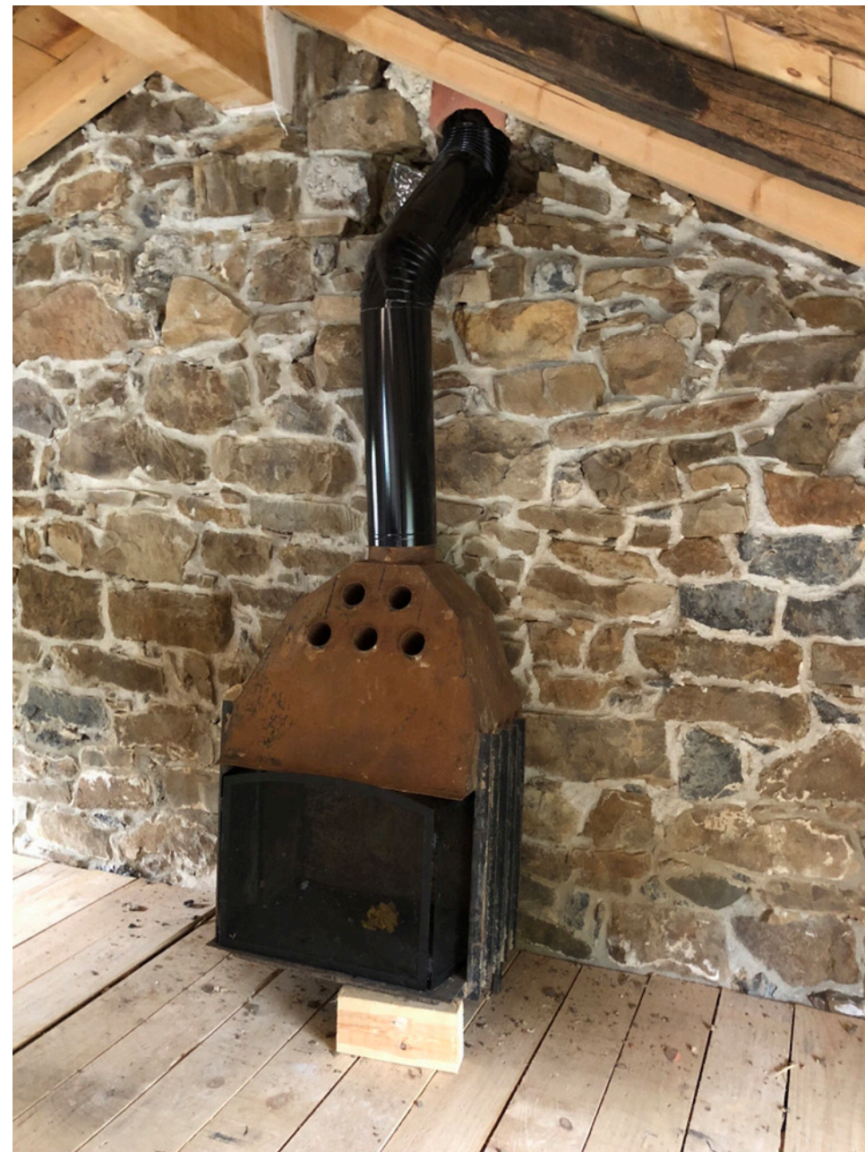
Instalación de chimenea en planta primera
