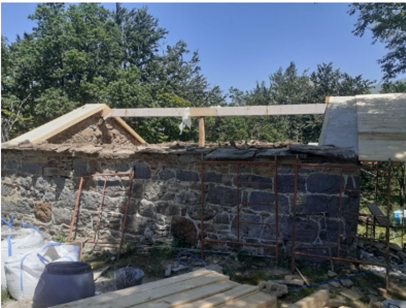
Construcción de zunchos perimetrales de hormigón
