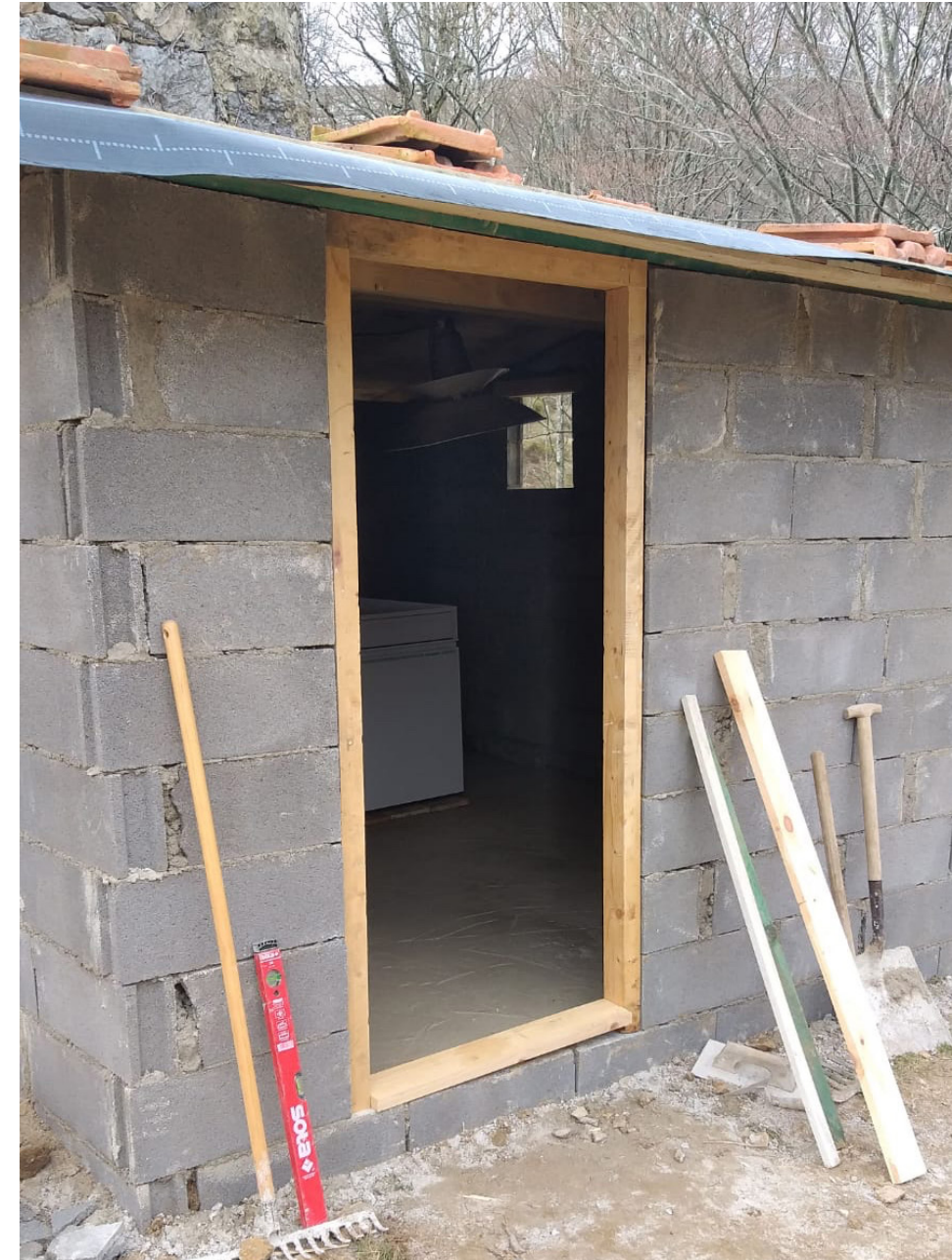
Construcción de cuarto de instalaciones
