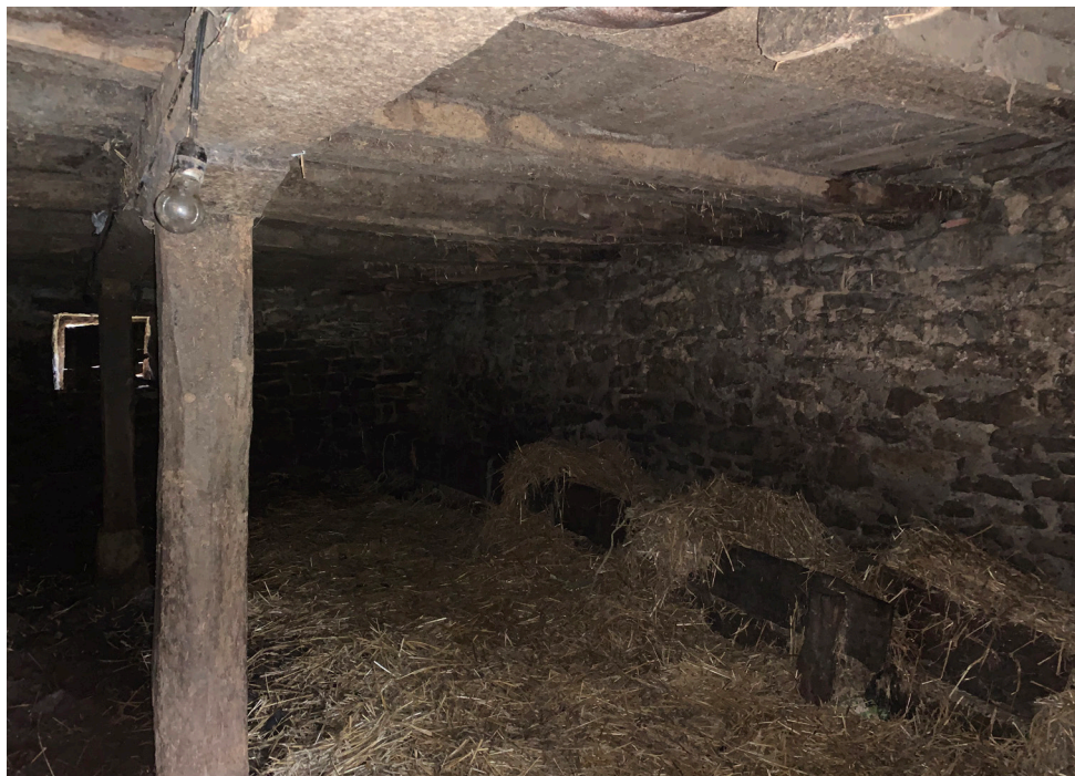
Espacio interior planta baja estado original
