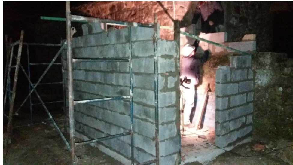
Construcción de cuarto de instalaciones (Cabaña ya rehabilitada)
