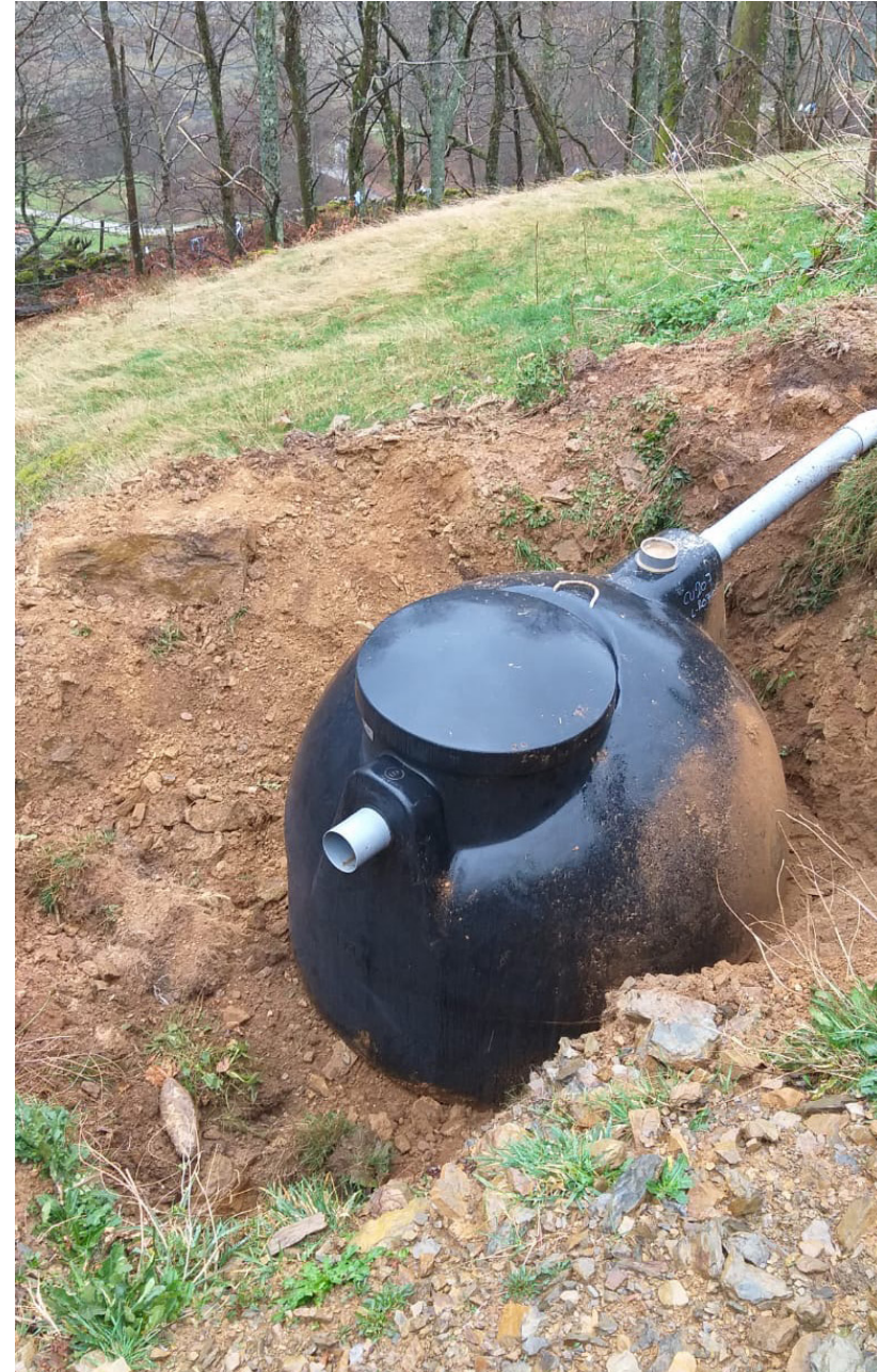
Colocación de fosa séptica
