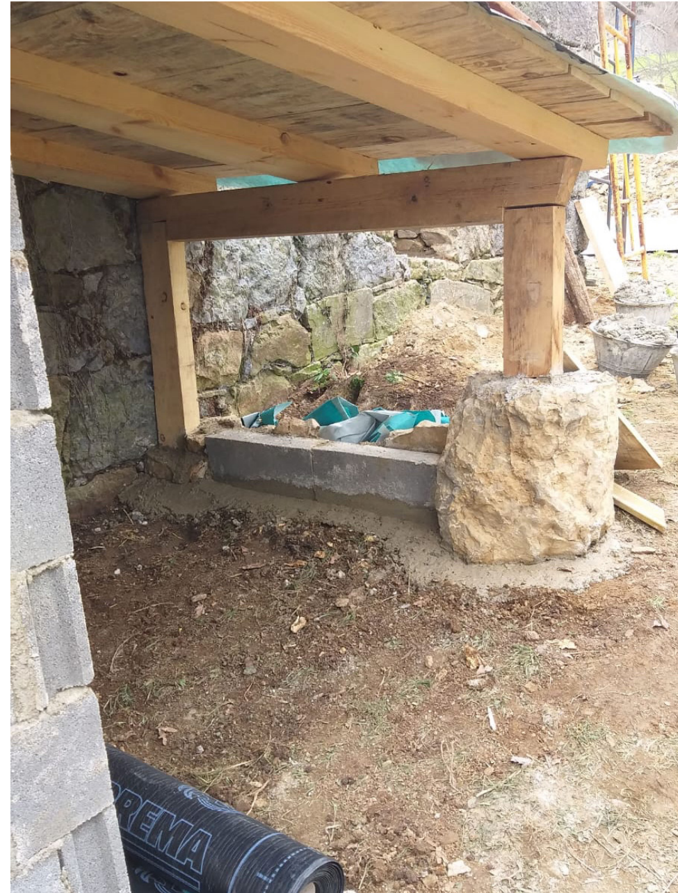
Construcción de cuarto de instalaciones
