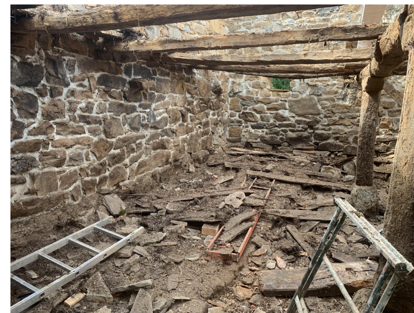
Desmonte de cubierta original
