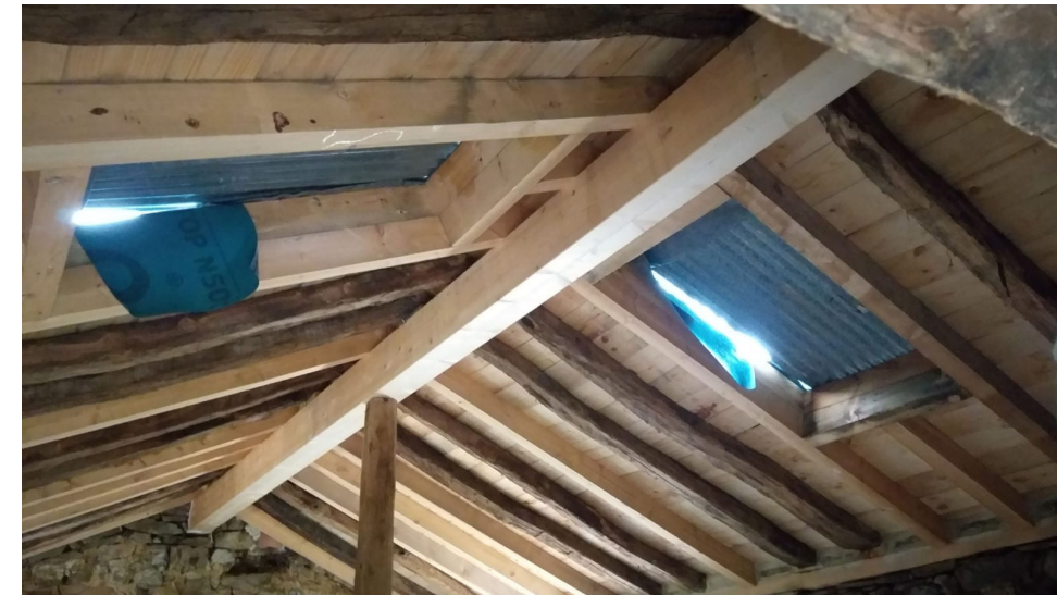
Aspecto interior de la cubierta
