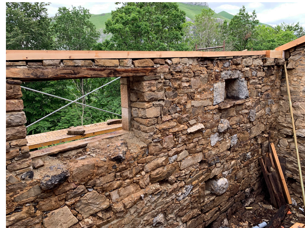
Colocación vigas perimetrales de madera sobre muro
