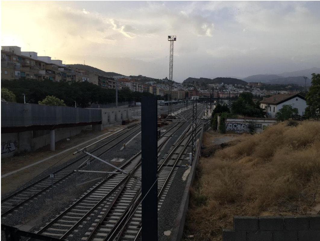
Figura 38. Fotografía de la línea férrea Bobadilla-Granada a su paso por Camino de Ronda
