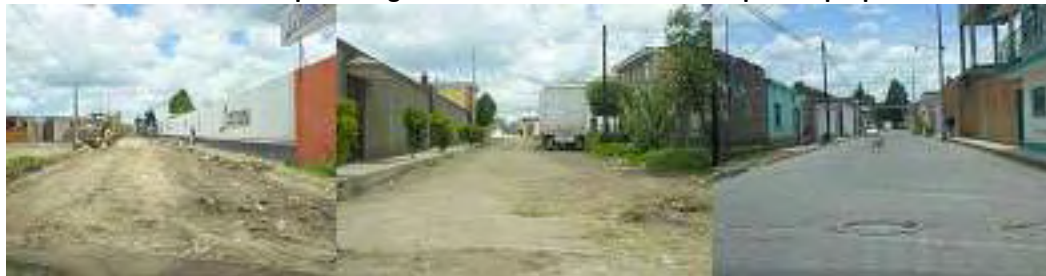
Calle en construcción de guarnición. Propietario de la vivienda
