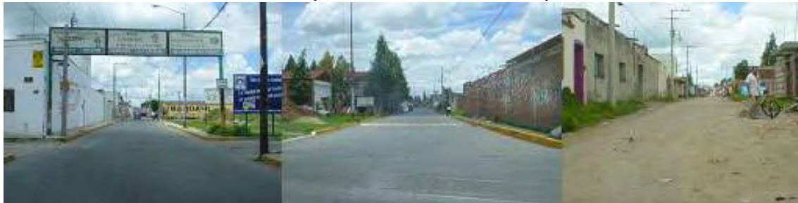
Calle principal de acceso. Sin red de drenaje pluvial
