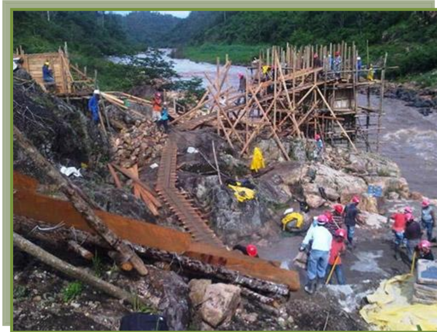
Figura 5. Construcción del Proyecto Hidroeléctrico Piedras Amarillas-Patuca III. (Fuente: www.laprensa.hn ).
