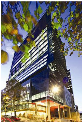
Fig.15: Vista lateral del Edificio Ark Fuente: http://www.construnario.com/
