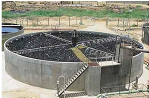
Figura 6.22. Sistema de filtro biológico o percolador.
