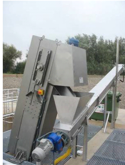
Figura 8. Rejas limpieza continua y automática
