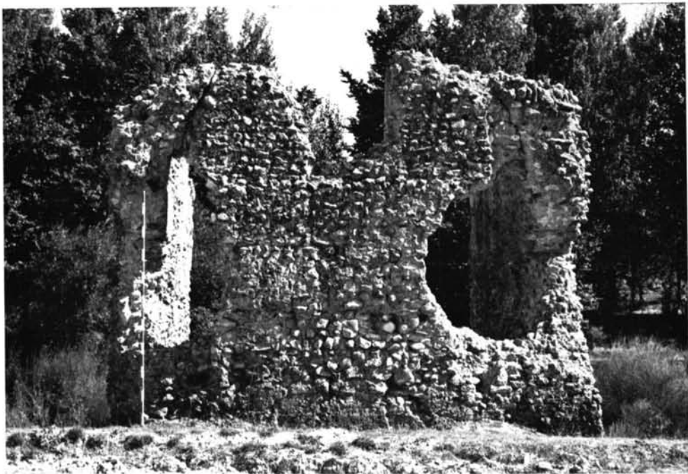
1. El sepulcro turriforme hispanorromano de Vildé (Soria) visto desde el lado E. En primer término los bloques de hormigón derrumbados.—2. El mismo edificio, lado occidental, desde el camino de la Pisa.
