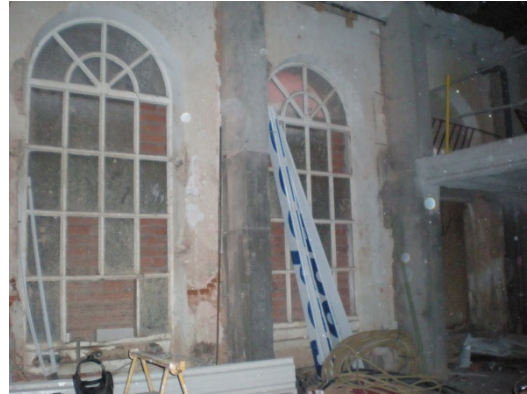
Figura 7. 5_ Estado actual de fachada a calle Correos.
