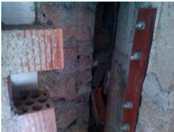
Figura 8. 2 Fotografía de medianera
