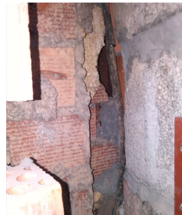
Figura 8. 1 Fotografía de medianera
