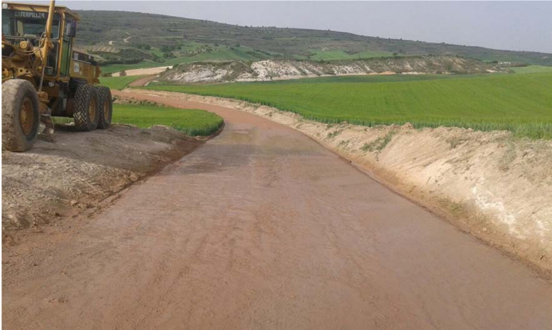
Foto Nº 9.- Material granular aportado recién sellado.
