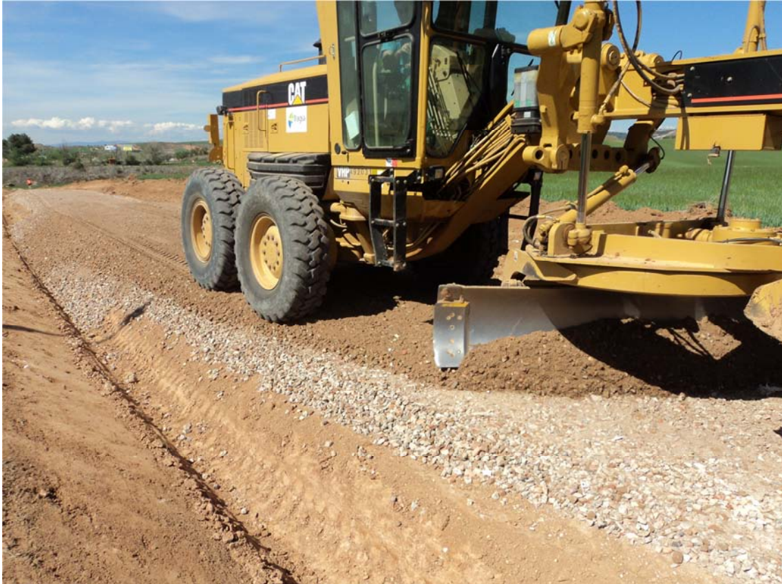
Foto Nº 8.- Motoniveladora extendiendo y perfilando el material granular.
