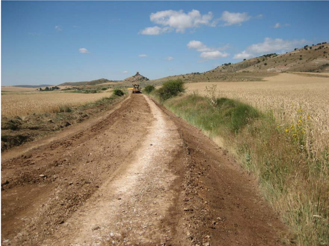
Foto Nº 6.- Motoniveladora perfilando cunetas.
