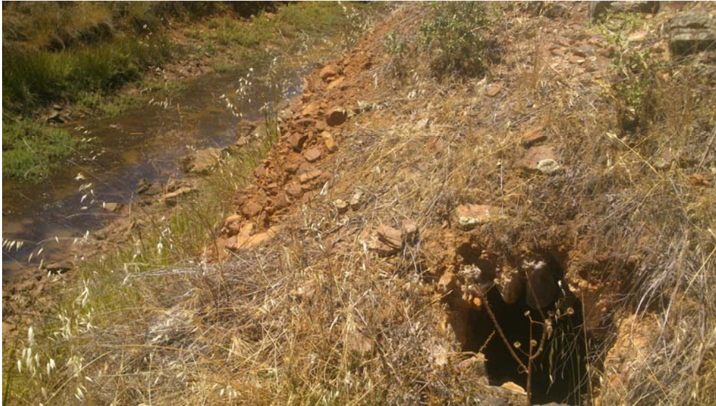
Fotografía Nº 16: El antiguo drenaje subterráneo. A la izquierda la zanja de drenaje. (07/06/2014)
