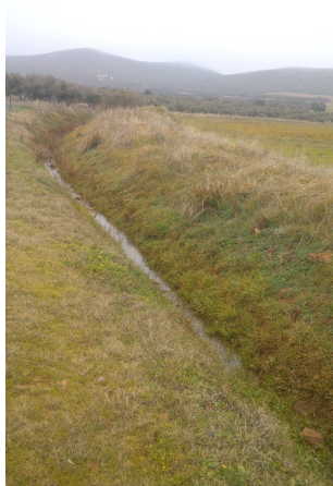
Imagen 1.10 El drenaje perimetral (14/01/2014)
