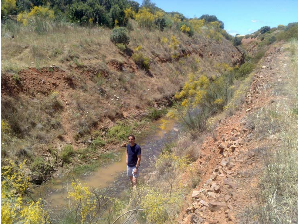
Fotografía N° 14 La zanja longitudinal o principal el 10/11/2011.
