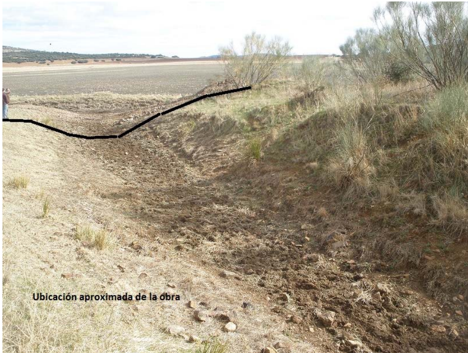
Imagen 10.5. Entrada del drenaje longitudinal. Al fondo la laguna.
