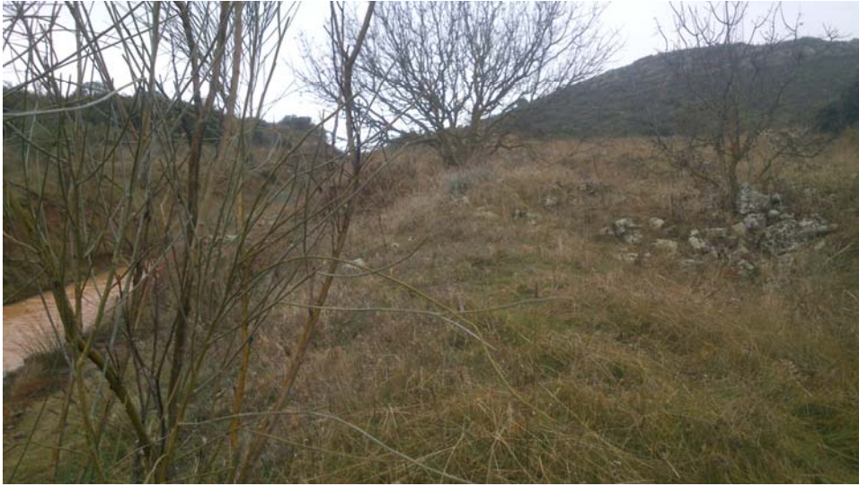
Fotografía N°18: Los acopios del terreno en la zanja longitudinal (14/01/2014)
