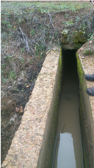
Imagen 1.12 El drenaje principal o de desagüe. subterráneo
