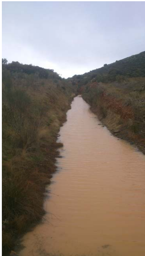
Fotografía N° 15: El drenaje longitudinal el 14/01/2014
