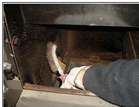
Figura 5.8 Limpieza cámara de combustión.
