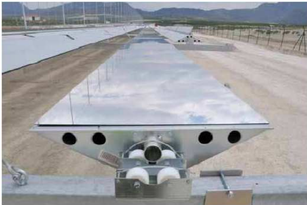
Figura 64: Reflector primario de la planta PE1
