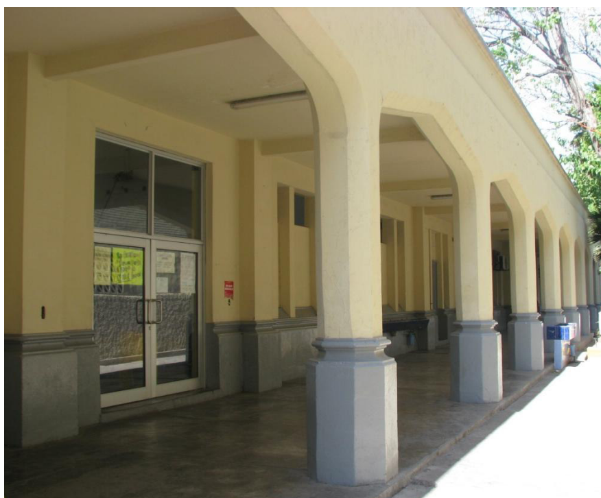
En el patio, arcos del portal sur.
