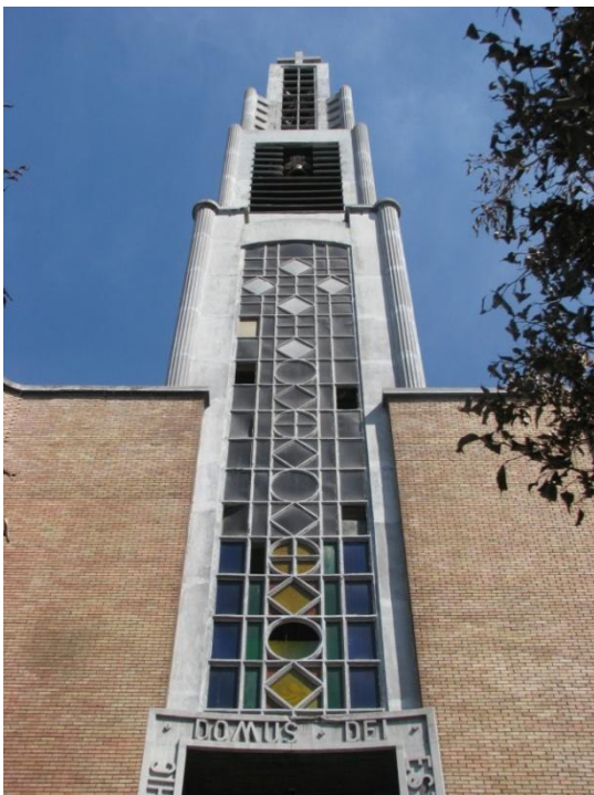
Torre campanario vista de frente.
