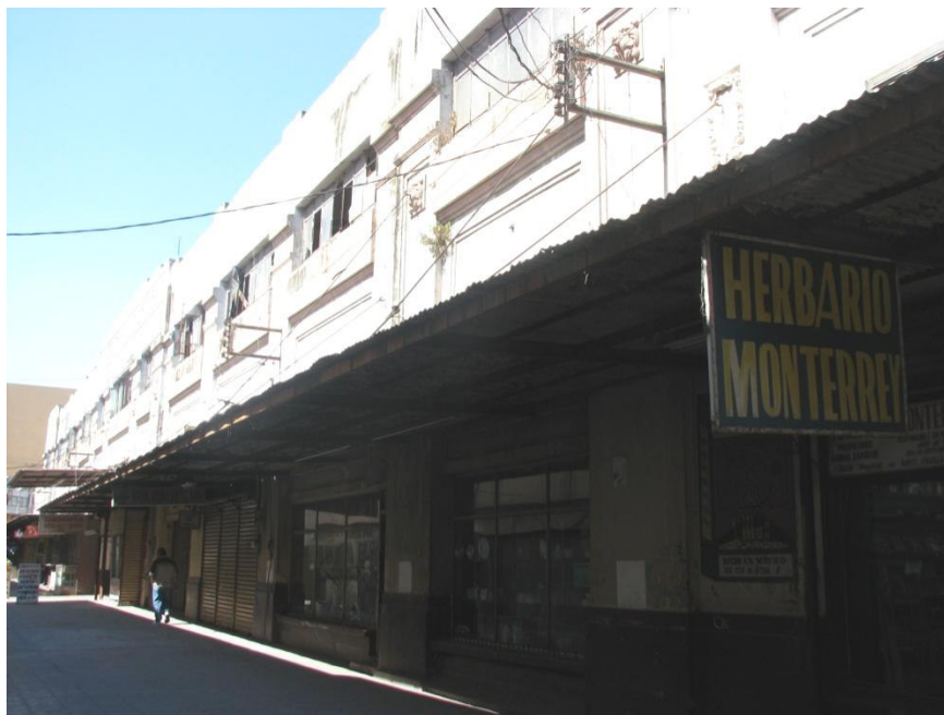
Fachada principal sur hacia la Privada Colón.
