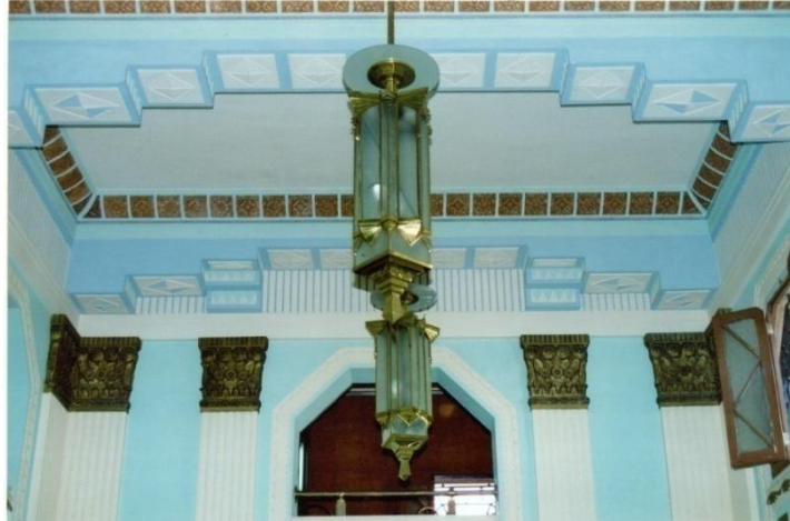
Edificio Bacardí, interior. Al fondo pilastras estriadas con capiteles corintios. Al frente y atrás traveses escalonados con decoraciones de puntas de diamante y las magníficas lámparas Déco Zigzag.
