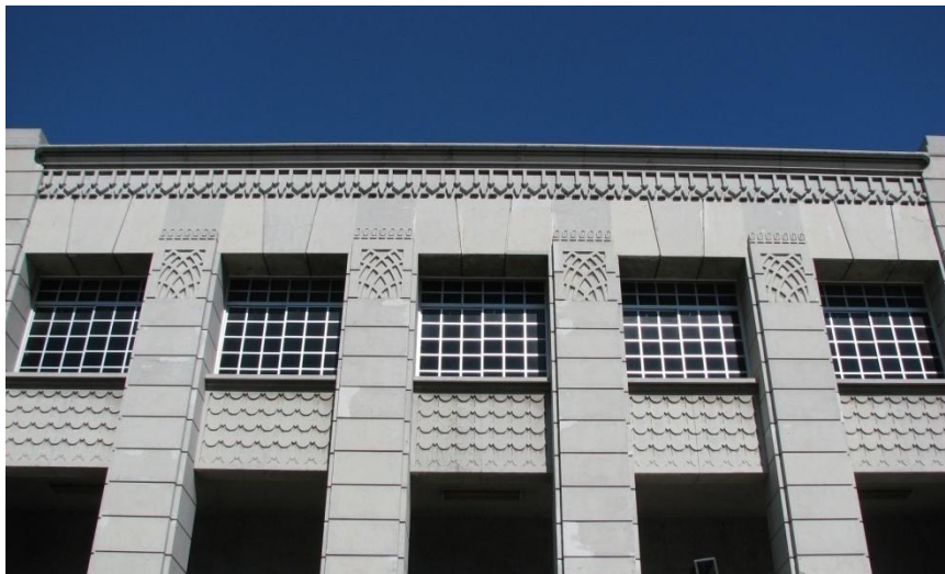
Decoraciones de la parte baja de las ventanas, del remate de los pilares y de la banda superior del teatro.
