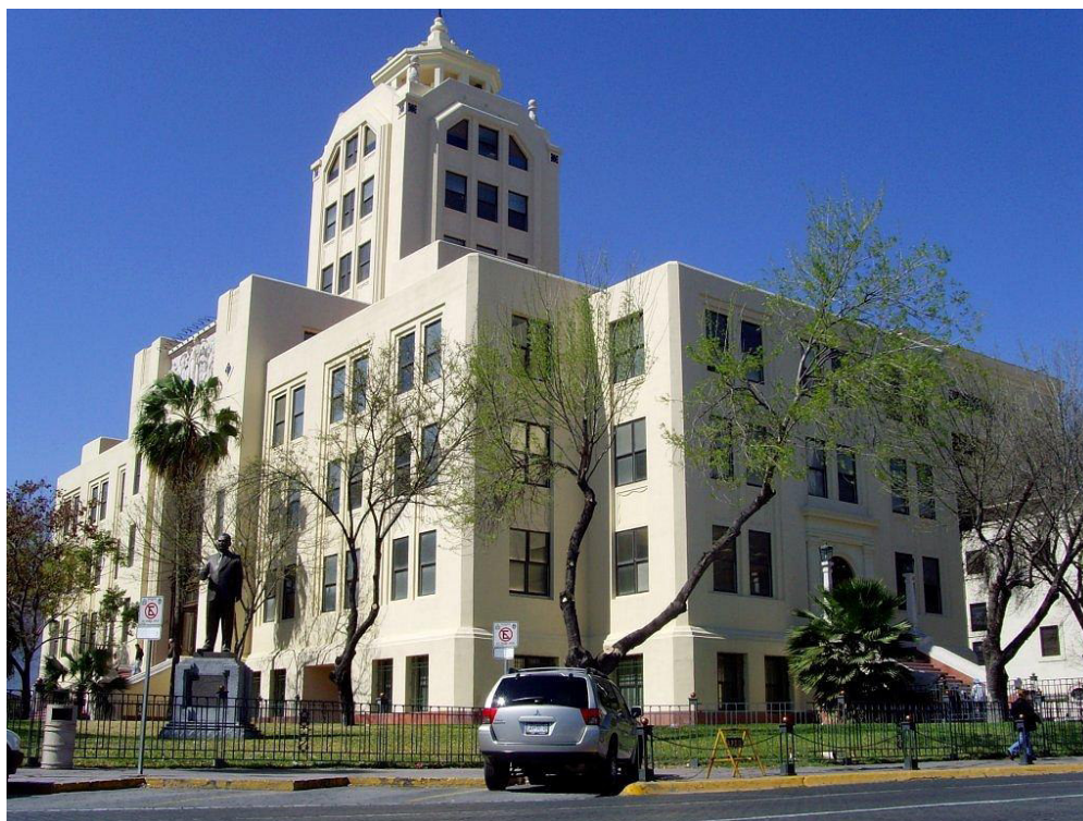
Palacio Federal, fachada sur y oriente.
