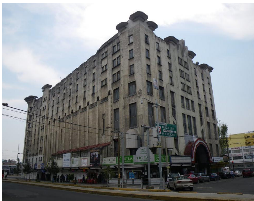
Juan Segura, Edificio Ermita , puerta de acceso al teatro, México, D.F., 1931. 138
