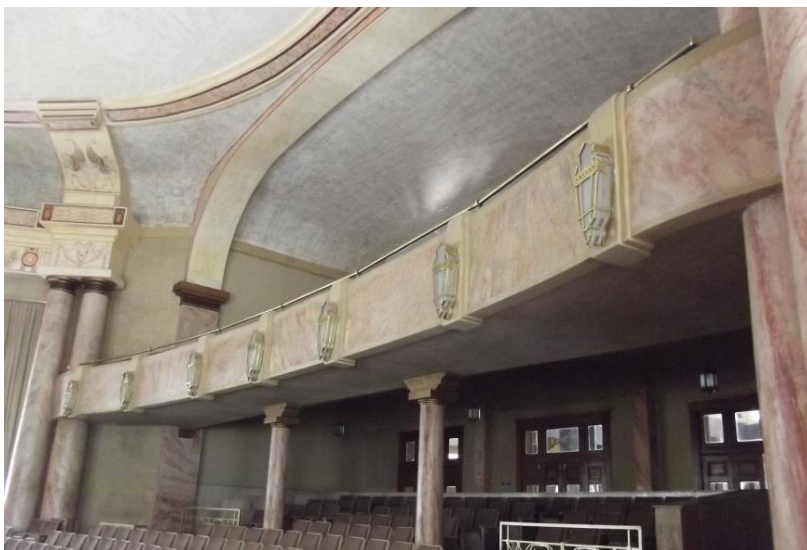
Barandal de la galería con las lámparas colocadas sobre las bandas.
