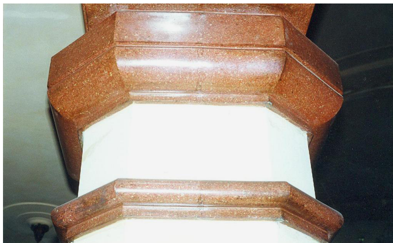
Detalle del capitel de una columna.
