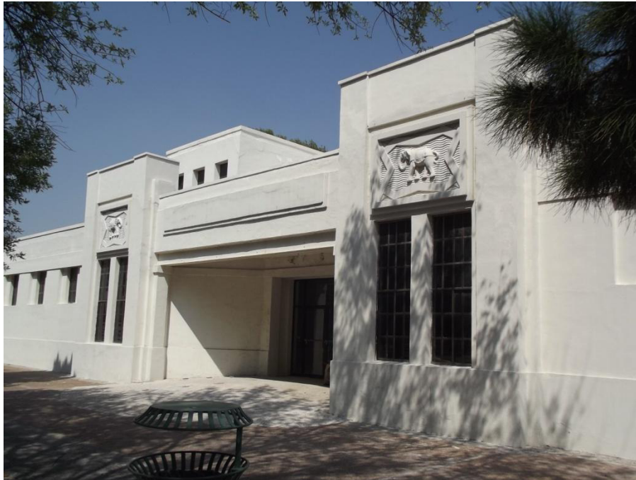
Parte central de la fachada sur. En los poliedros, arriba de las ventanas se aprecian los relieves.
