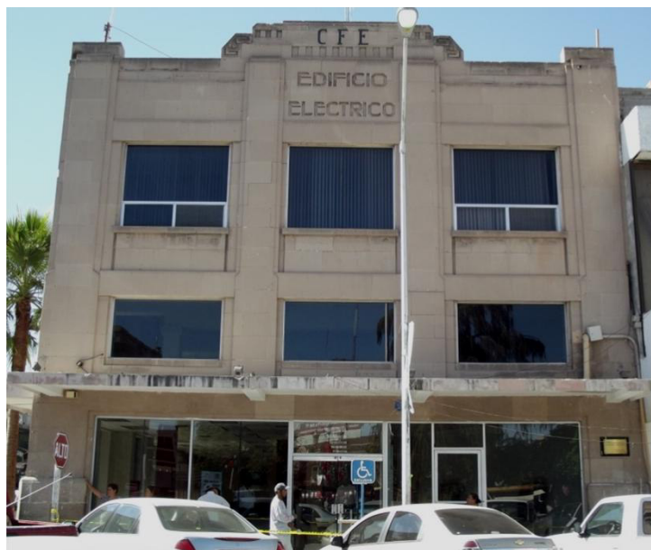
Fachada principal sobre la calle Valdés Carrillo.
