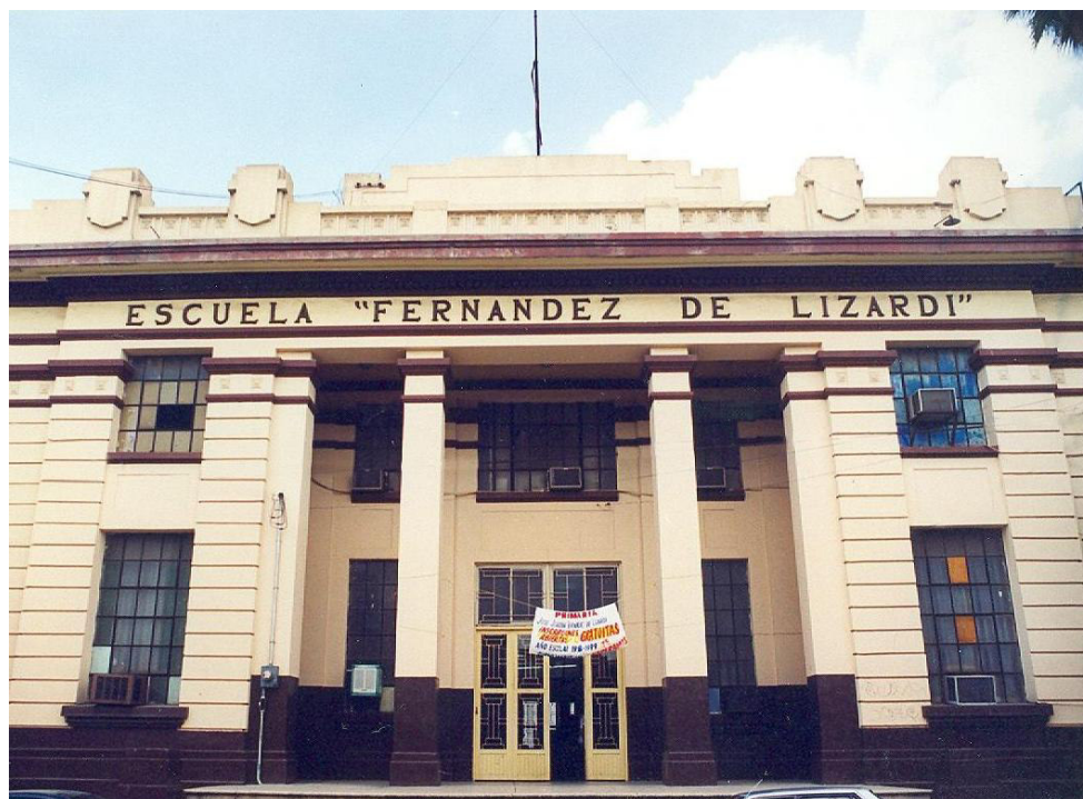
Acceso principal de la escuela en la portada sur sobre la calle Serafín Peña.
