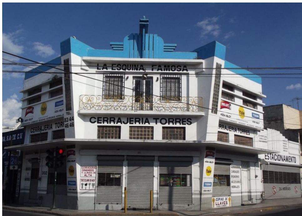
Vista de la fachada principal.
