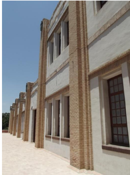
Segundo y tercer piso vistos por la parte posterior.
