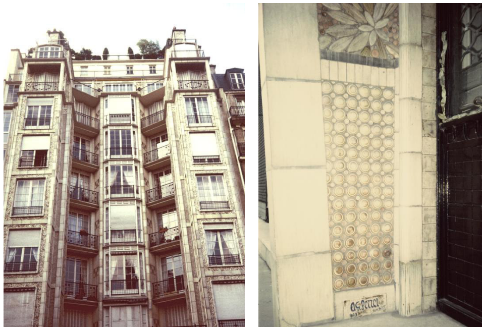
August Perret, apartamentos de la 25 Bis Rue Franklyn . En la imagen de la derecha, detalle de la puerta de entrada y firma de Perret en la parte baja. París, 1903.
