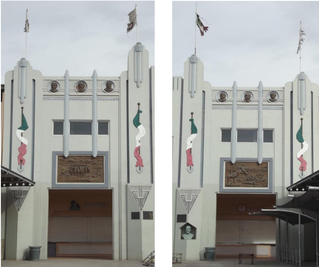
Puertas laterales. Arriba de los relieves las molduras atravesando los ventanales y los frisos.
