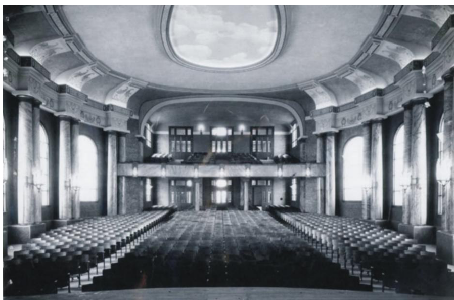
Paraninfo en la década de los años cuarenta con los zócalos de las columnas. 227
