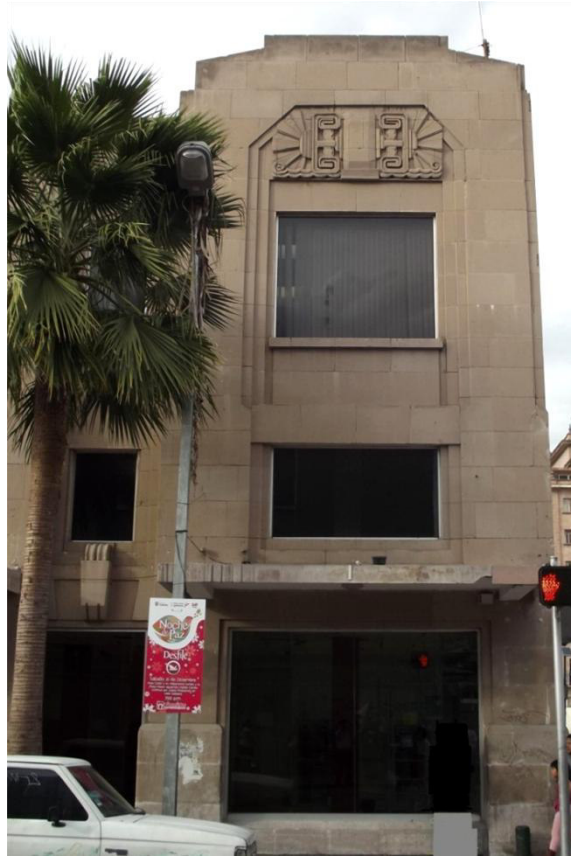
Tercera portada de la fachada sur que solamente abraza dos tramos.
