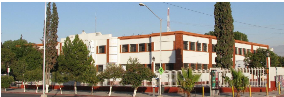
Vista del lado derecho de la fachada principal, con el muro rehundido y la última parte desplazada hacia el frente. Las fachadas laterales tienen un sentido funcionalista, como se aprecia aquí en la fachada sur.
