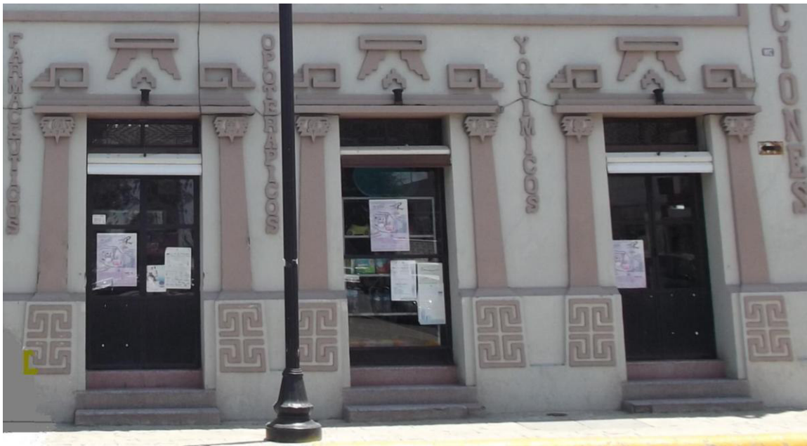
Tres de las cuatro puertas de la fachada norte sobre la calle Morelos.
