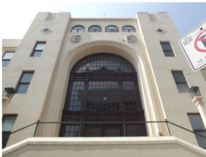
Detalle de la fachada norte.
