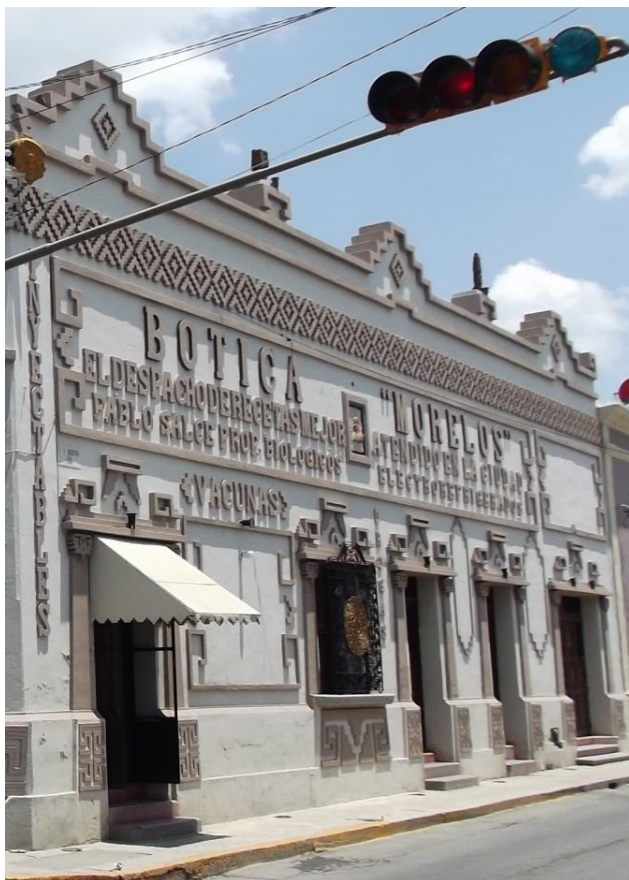
Fachada poniente sobre la calle Madero.
