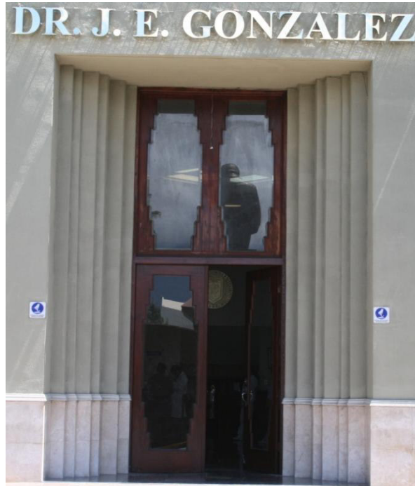
Puerta de la entrada principal.
