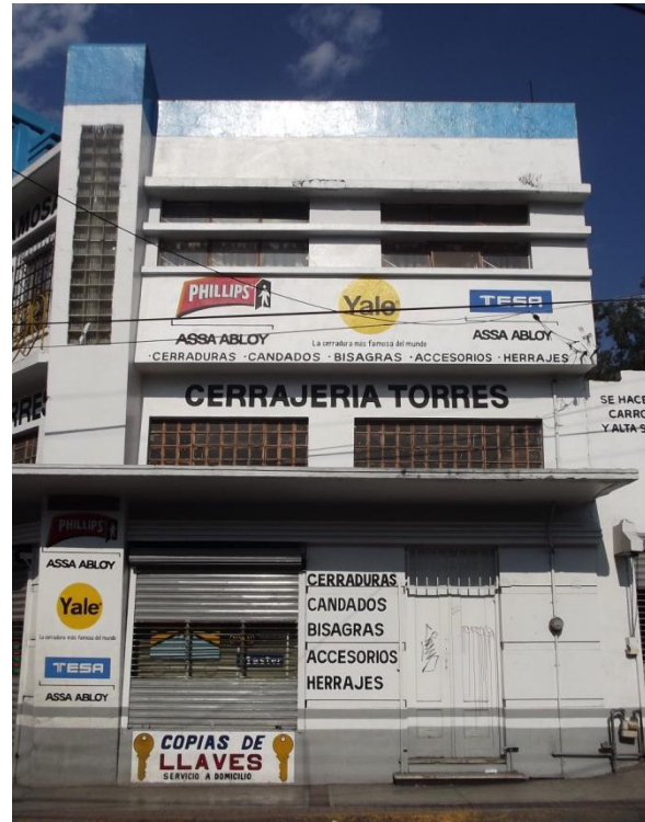
Fachada poniente sobre la calle Galeana.
