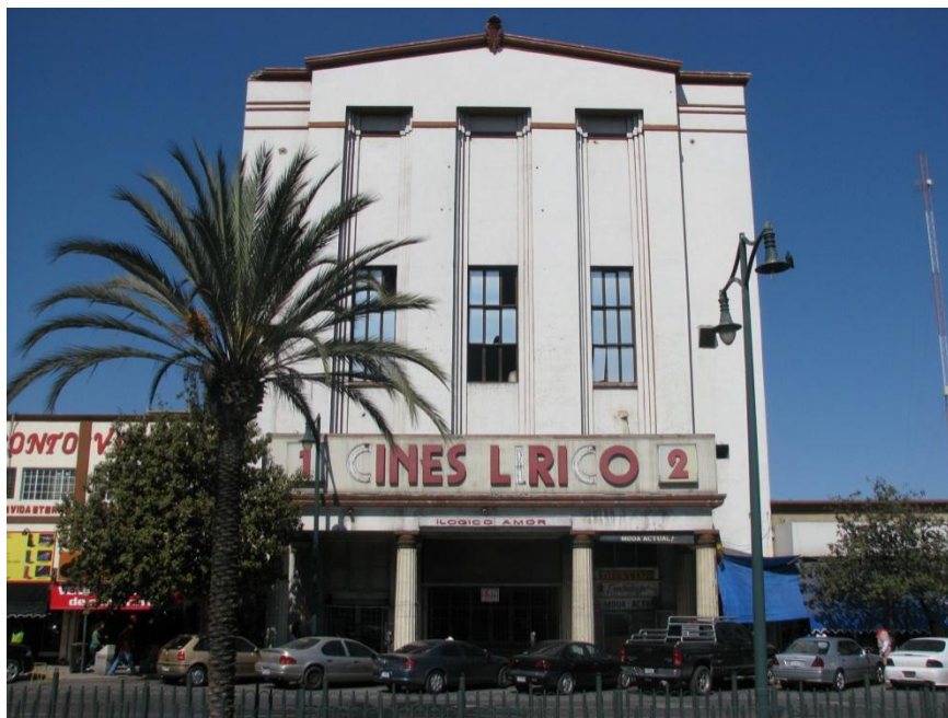
Estado actual del Cine Lirico.
