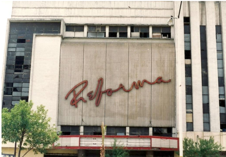
Detalle del cuerpo central de la fachada en 1992 cuando ya estaba cerrado. 134
