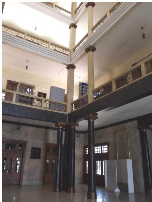
Interior donde se aprecian los cuatro pisos y las herrerías de los barandales.
