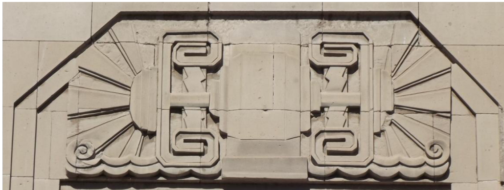
Relieve de la parte superior de la tercera portada de la fachada sur.
