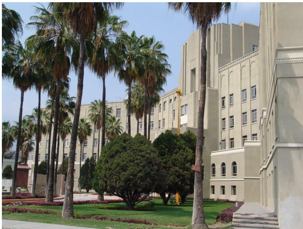
Vista de la fachada principal desde el lado suroriente desde donde se ve el cuerpo adherido de dos niveles y las molduras de las cornisas con decoración de gotas elípticas. 110
