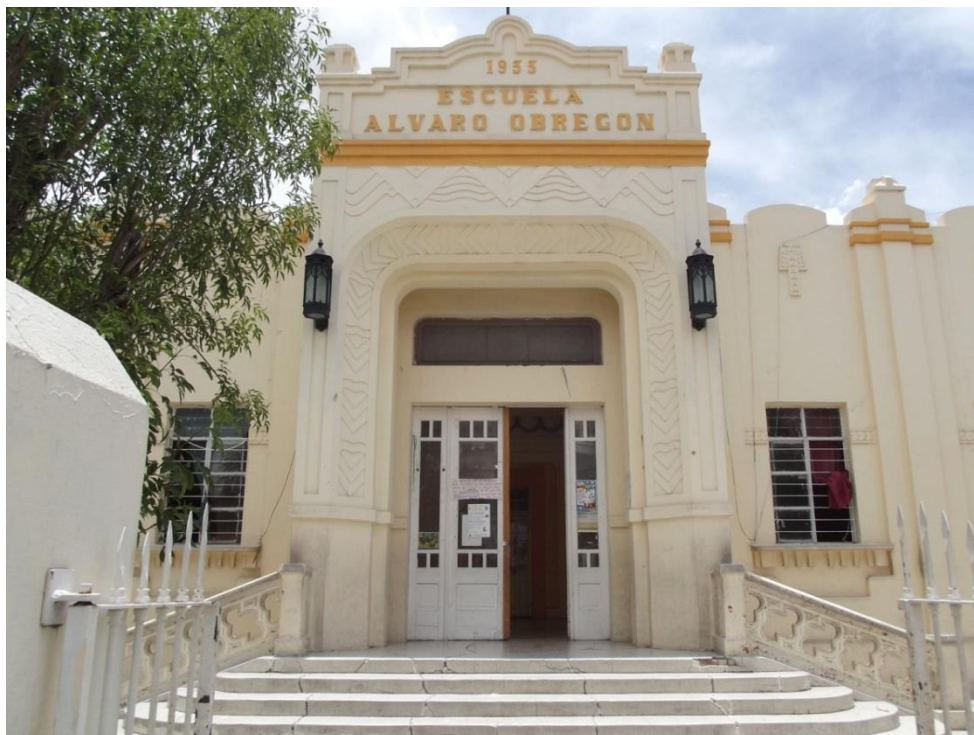
Acceso de la escuela. Se parecían los peldaños curvos, el barandal con las celosías en forma de pétalos trebolados. En la puerta destacan las decoraciones de tipo Art Déco Zigzag .
