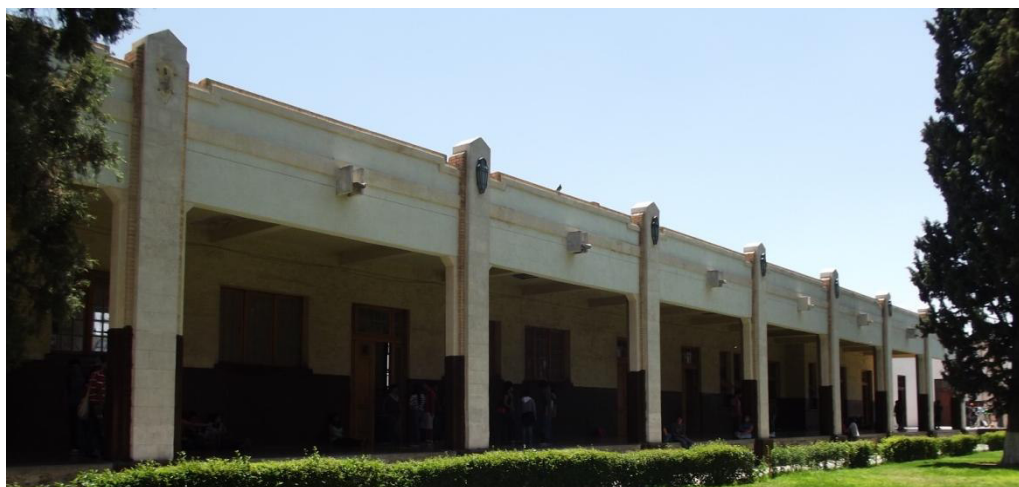
Corredor y aulas de la parte trasera de la zona oriente del edificio que miran hacia el norte.
