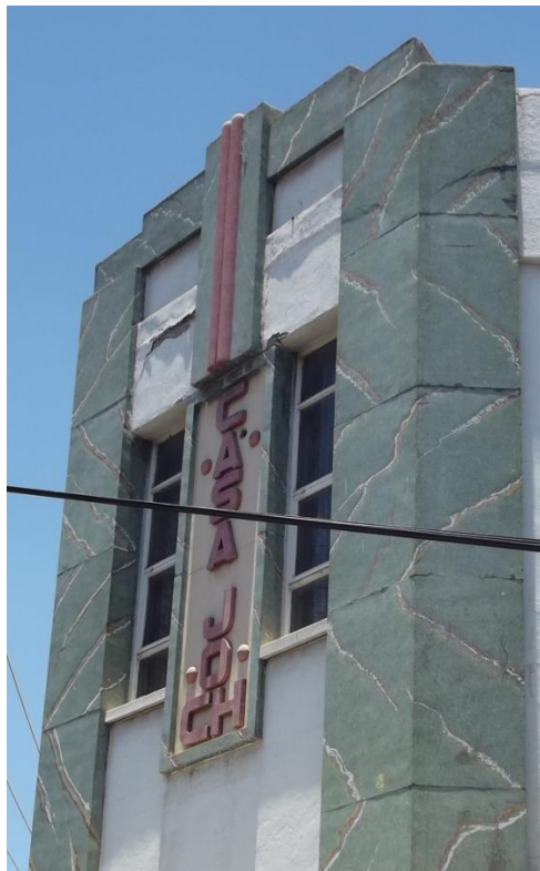
Detalle del remate escalonado, la placa con las molduras y el letrero.
