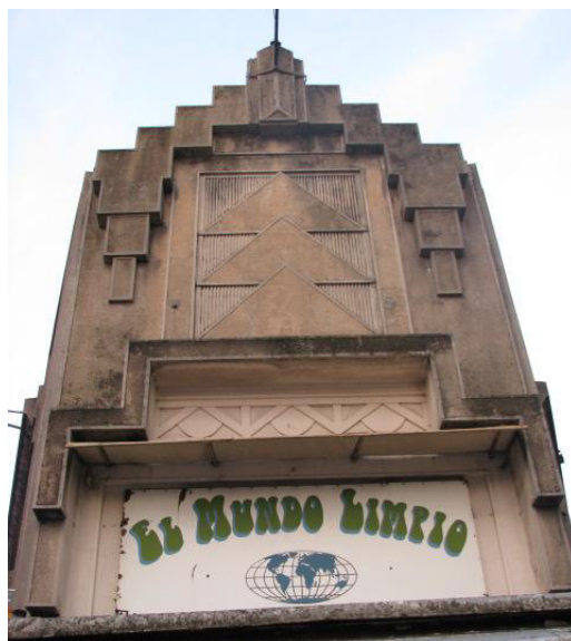
Detalle de la parte superior del comercio en el cruce de Diagonal 80 con Avenida 47, La Plata.
