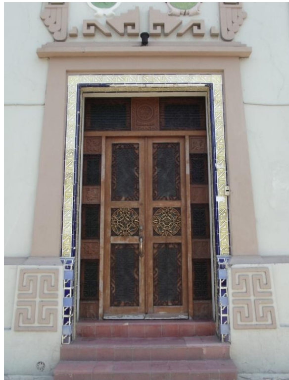
Primera puerta de izquierda a derecha de la fachada norte sobre la calle Morelos.
