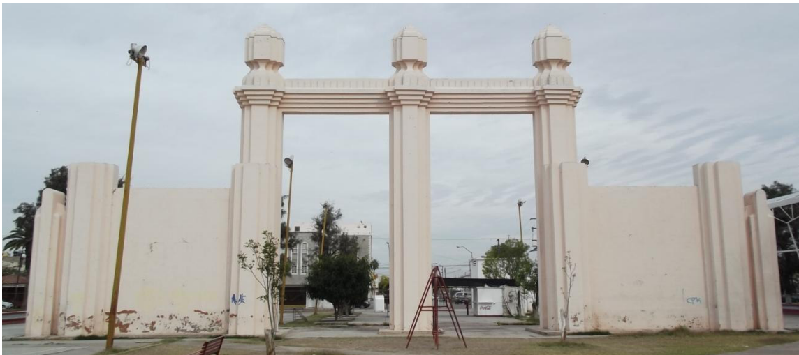
La estructura principal vista de sur a norte con los prismas adosados a las columnas laterales y los muros.
