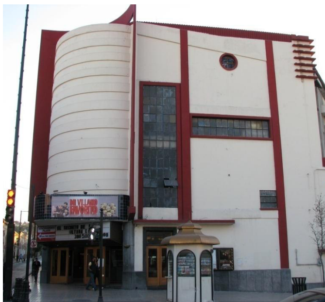
Fachada lateral poniente por la calle Victoria.
