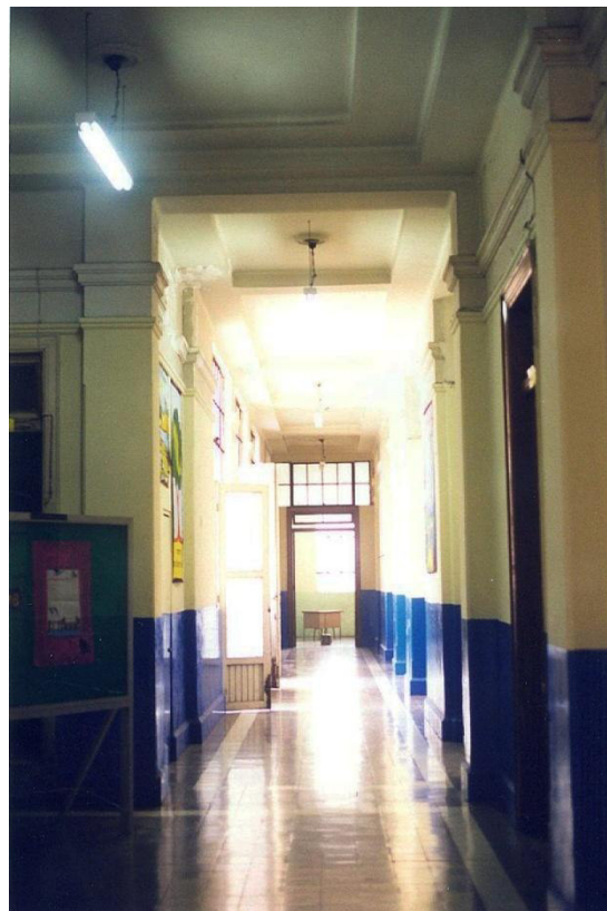
Pasillo interior con las pilastras y en el techo los rectángulos rehundidos.
