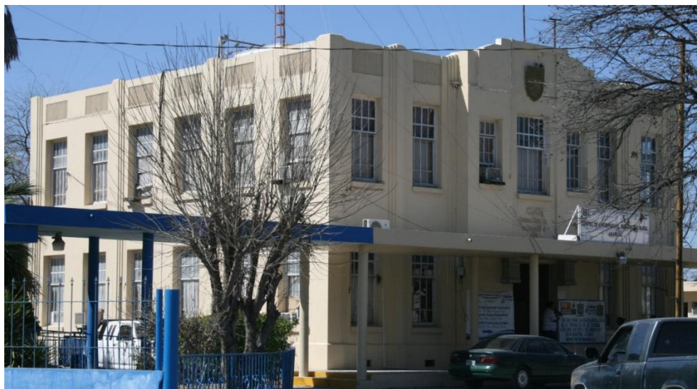
Vista de frente y de la fachada lateral sur.
