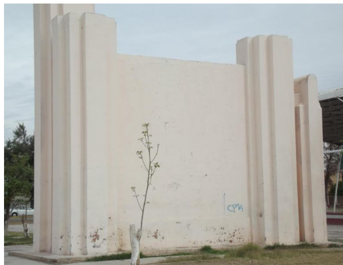
Muro derecho donde se aprecia la última parte con el prisma yuxtapuesto por el lado oriente.
