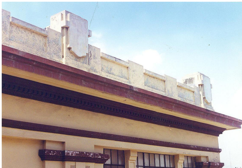
Detalle de la parte superior del cuerpo lateral poniente con la cornisa y la moldura dentada, así como el pretil y los dados del remate.
