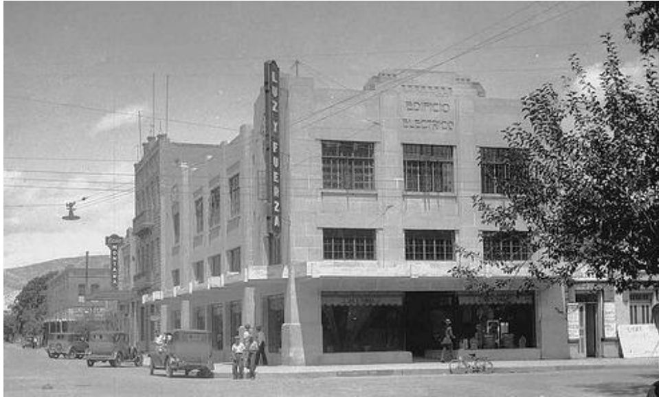
Edificio eléctrico recién inaugurado. 244
