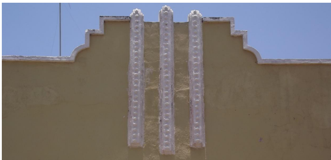
Detalle de la moldura de la parte superior, un piñón y las molduras estriadas con decoraciones de pomas.
