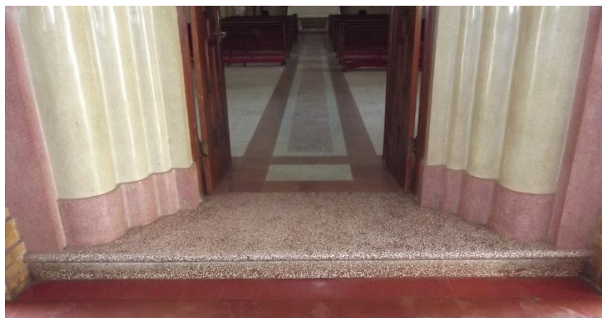
Detalle de la parte baja del piso y del arco.
