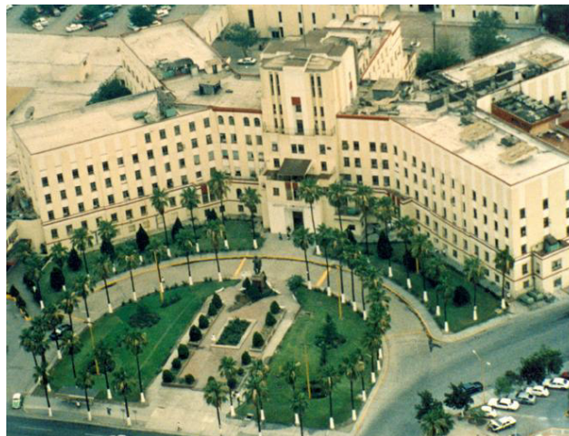
Vista aérea del hospital antes de la remodelación de 2006. 106
