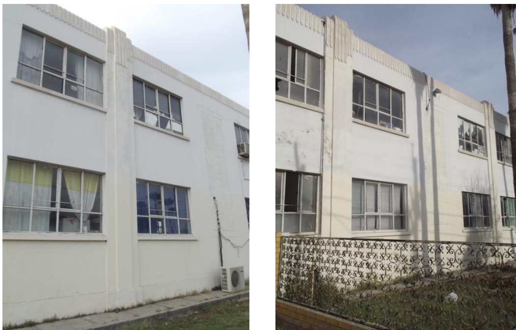
Detalle de las fachadas de la calle Hidalgo, la primera, y de la calle Juárez, la segunda. Se aprecia la composición de las pilastras con bandas superpuestas y de las decoraciones por medio de lengüetas tanto de las pilastras como del remate de los muros.
