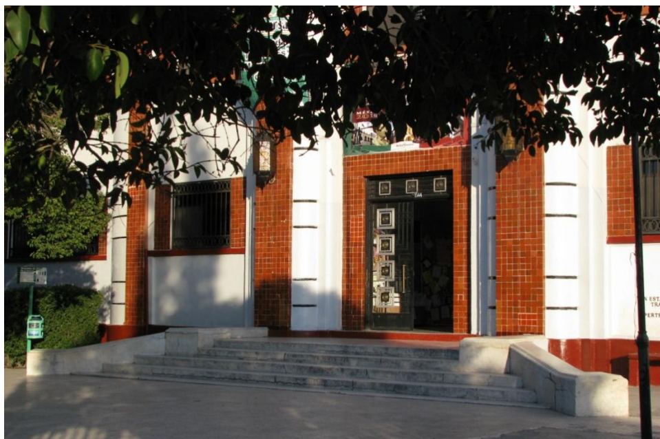
Escalera y puerta de entrada. En los barandales se aprecia el recorte en los extremos que simula dos bandas superpuestas.
