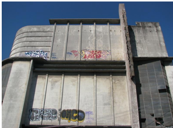
Fachada lateral sur. Del lado derecho está el ventanal en forma de prisma irregular.
