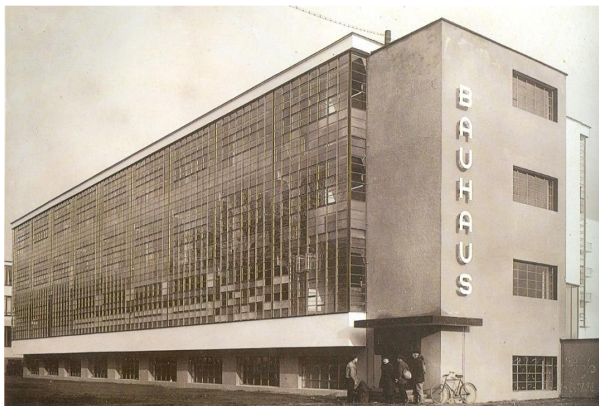
Walter Gropius, Edificio de la Bauhaus , en Dessau, foto de 1927. 167
