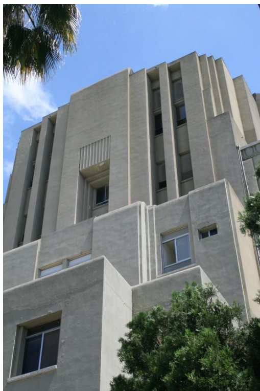
Detalle de la elevación de los tres cubos del cuerpo central. 109
