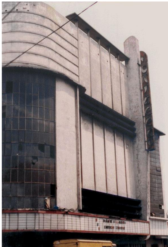
El cine aún abierto al público en 1992 pese al deterioro. Sólo funcionaba la luneta. 130
