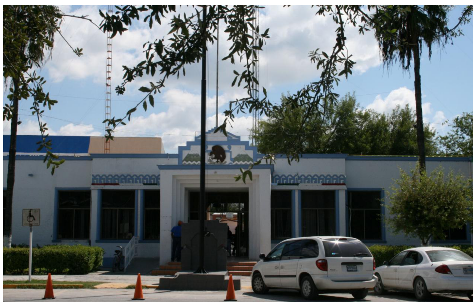
Palacio Municipal de Anáhuac. A los lados de la puerta están las decoraciones con grecas.
