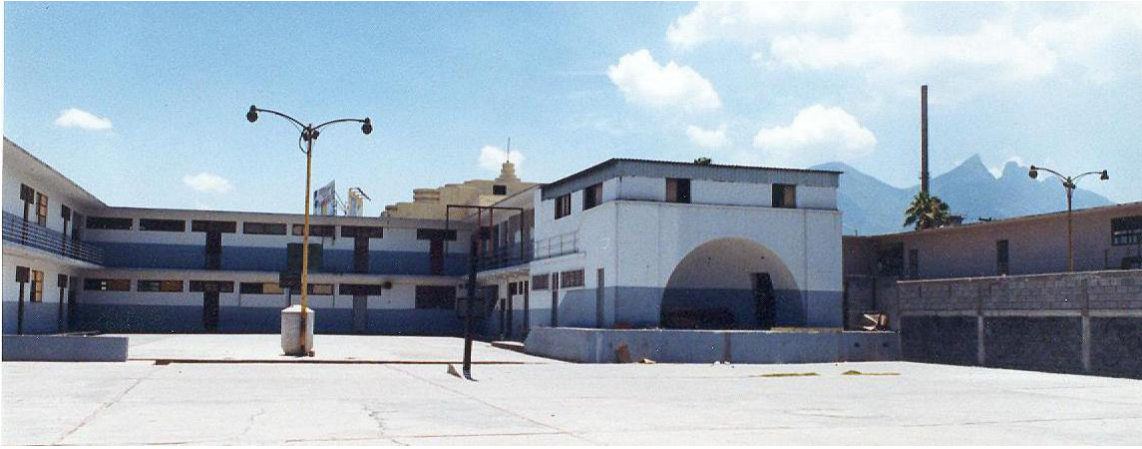
Portal en el cuerpo central y la inclusión de unas construcciones en el cuerpo lateral sur.
