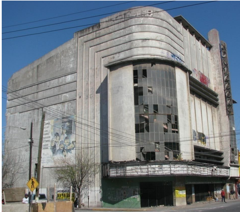
Condiciones actuales de la fachada.
