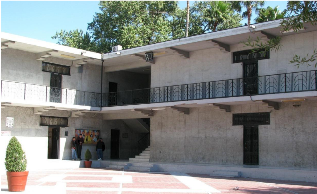
Vanos de acceso en forma de T de los salones. En ambos niveles las marquesinas sostenidas por las ménsulas escalonadas.
