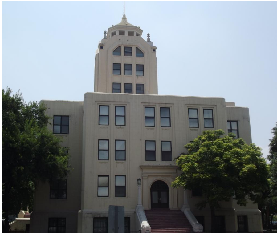
Vista de la torre desde la fachada poniente.
