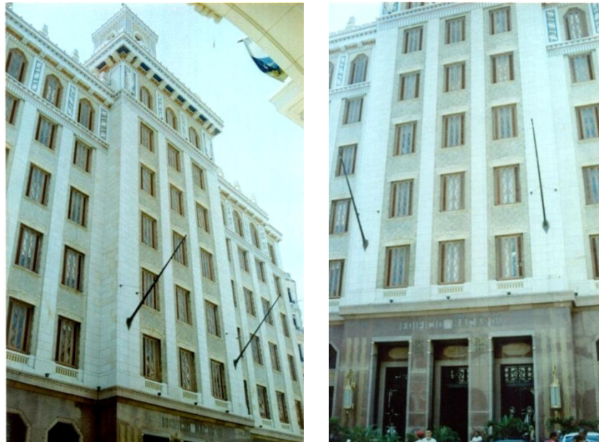
Esteban Rodríguez Castells, Edificio Bacardí , La Habana, 1930. Vista de conjunto y detalle de las puertas del acceso principal.
