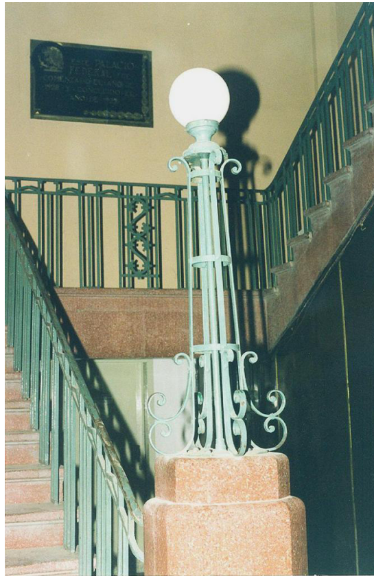
Lámpara en el inicio de la escalera.
