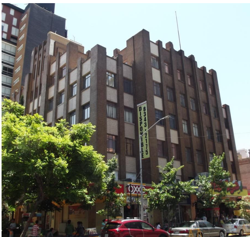
Vista desde el lado nororiente sobre la calle P. Mier . En la fachada principal u oriente de la calle Parás es donde se ubica la torre de seis pisos.
