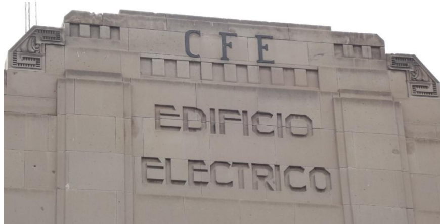
Detalle del piñón de la fachada principal.
