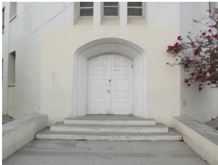
Entrada principal y puerta de acceso.
