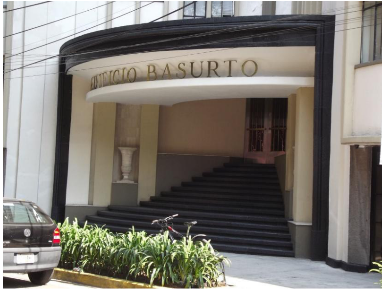
Edificio Basurto, Puerta de entrada, México, D.F., 1934.
