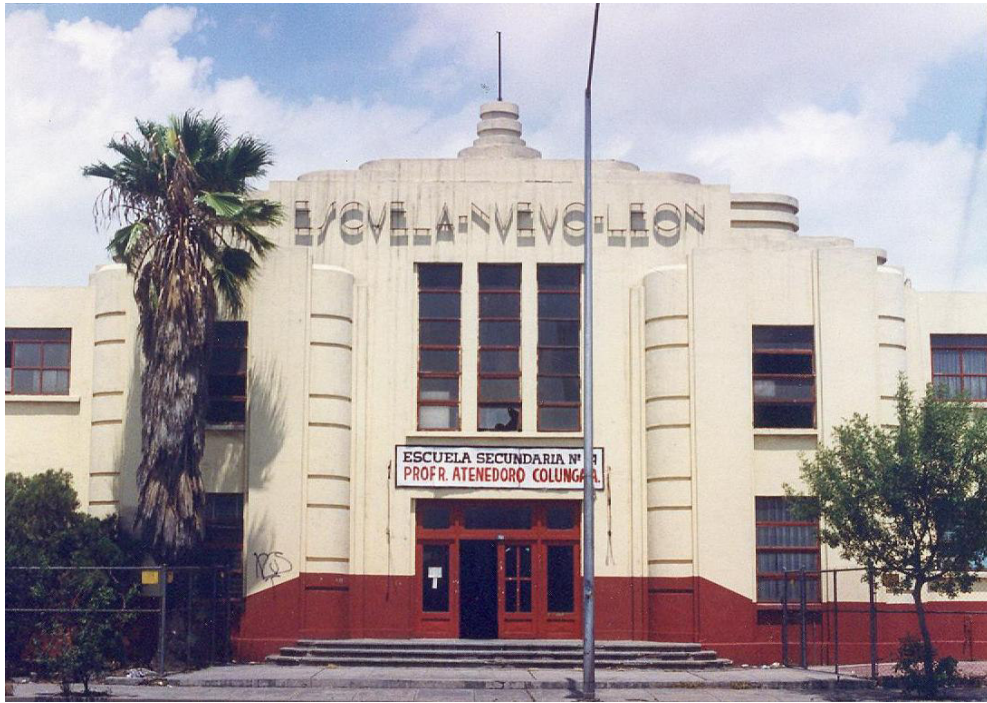
Entrada principal. A los lados los lienzos superpuestos y los medios cilindros. Atrás del letrero los escalonamientos curvados y en la parte superior los anillos de la base de la astabandera.
