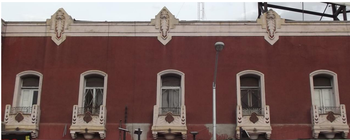
Balcones de la calle Cepeda.
