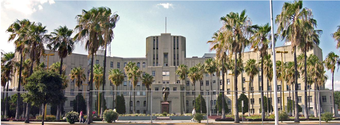
Vista frontal del Hospital. 107
