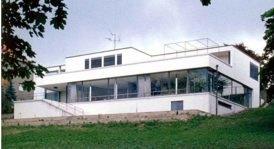
Mies van der Rohe, Casa Tugendhat , en Brno, 1928-1930. 171
