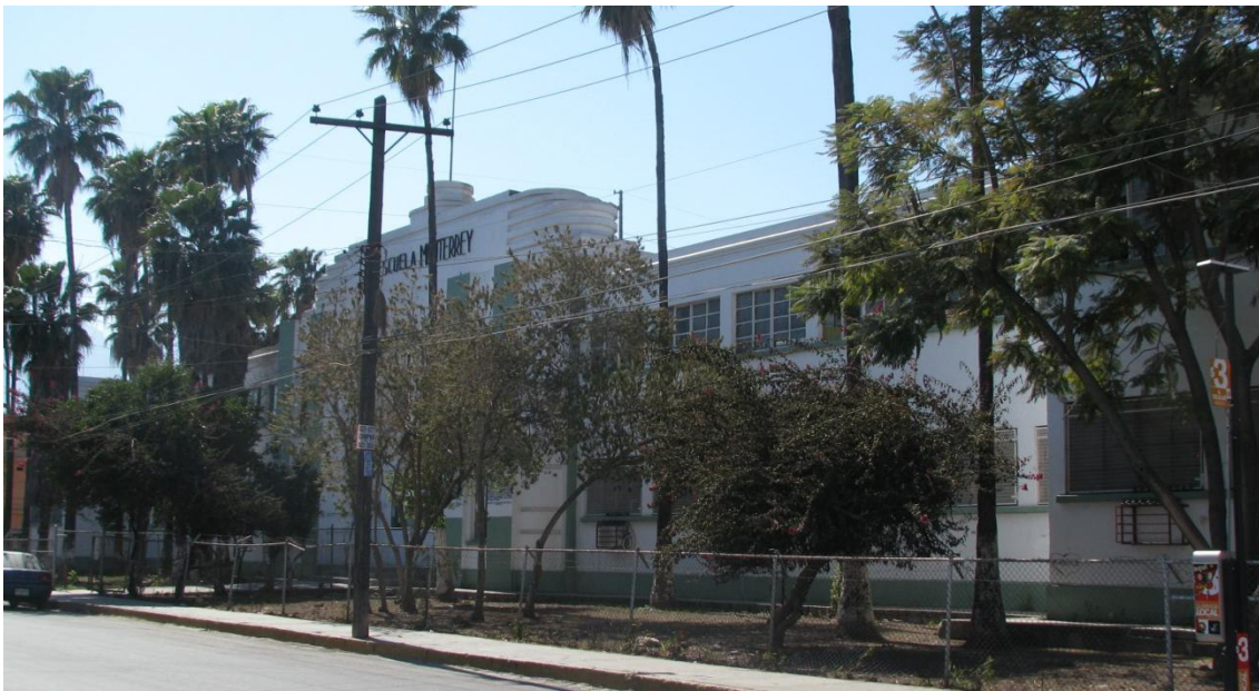
Vista del edificio pero con la invasión de árboles es difícil captar sus componentes estilísticos.
