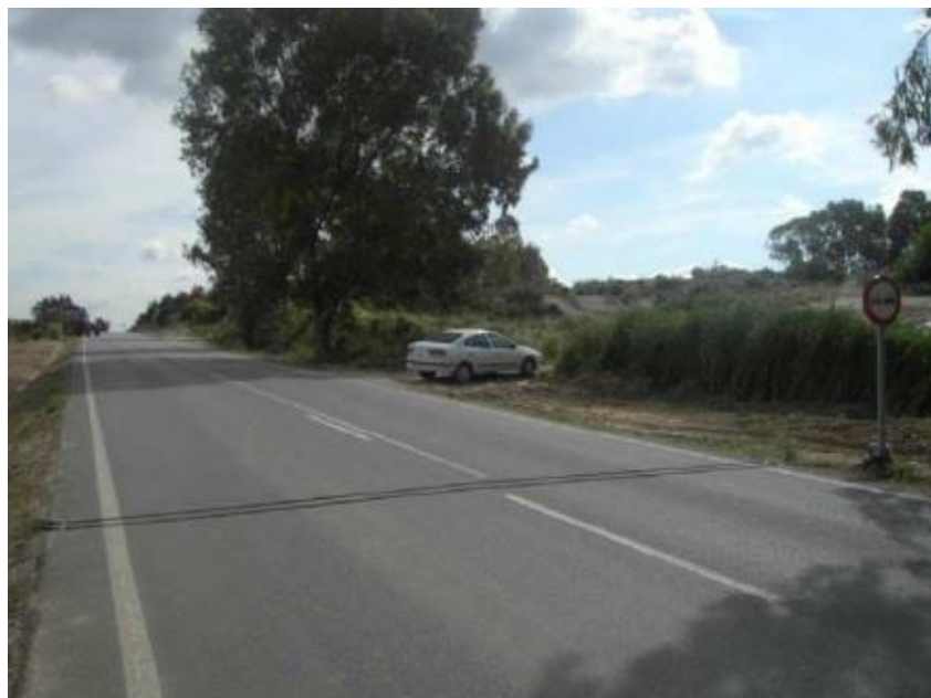
Figura 1.3.: Aforador móvil instalado en una carretera
