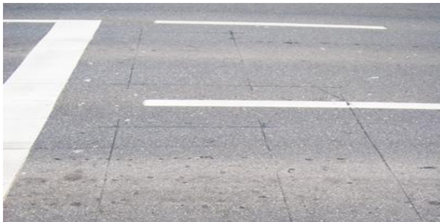
Figura 1.4.: Espira electromagnética enterrada en la calzada
