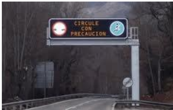
Figura 1.9.: Panel de mensaje variable en carretera
