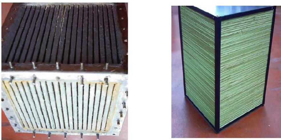
Figura I.5: Detalle de intercambiadores de placas de metal (izquierda) y papel (derecha)
