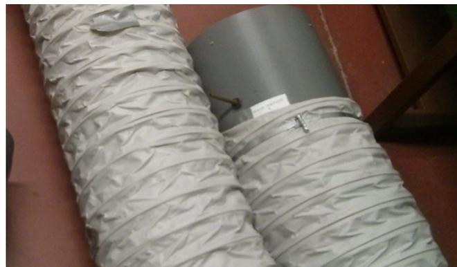
Figura III.5: Detalle de los conductos de aire flexible
