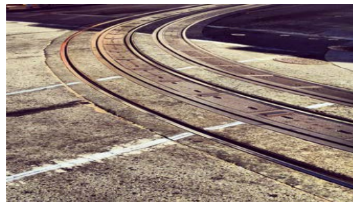
(30) Detalle de los raíles para el sistema de tracción de cable en la ciudad de San Francisco. 21
