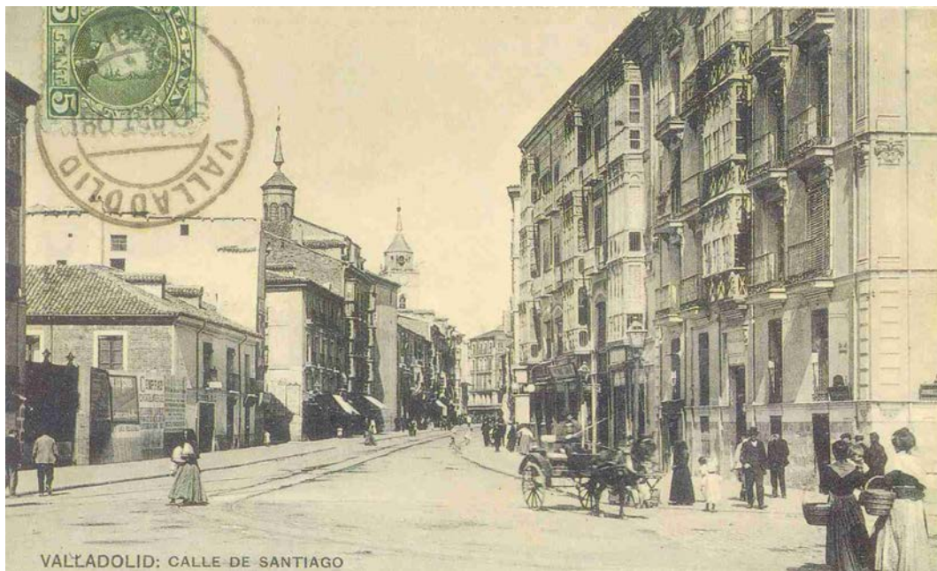
(73) Calle Santiago con los raíles del tranvía instalados en la calle. 20
