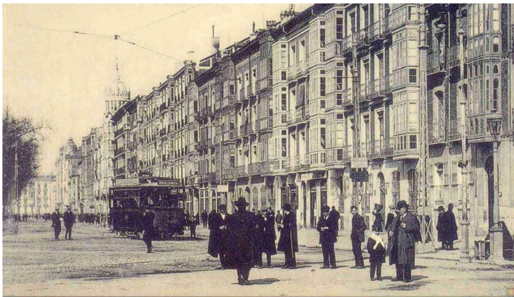
(118) Tranvía eléctrico circulando por la Avenida de Alfonso XIII. 38
