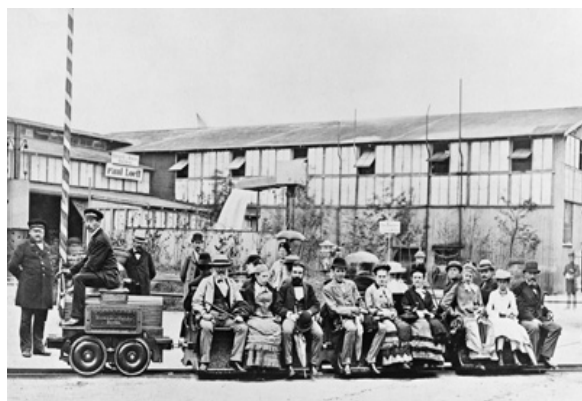
(31) Primer ferrocarril eléctrico (alimentado desde una fuente externa), construido por Siemens en la Exposición Universal de Berlín en 1879. 22
