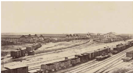
(48) Estación de Valladolid, año 1864. 6
