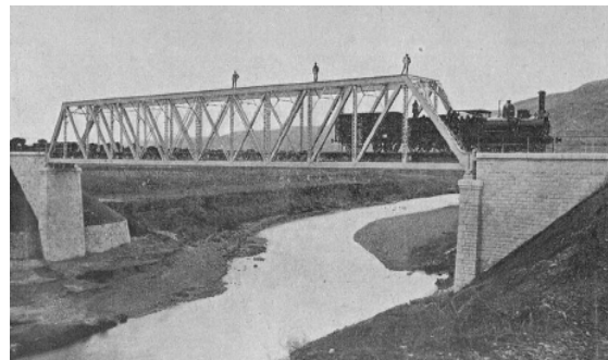
(47) Puente del Carrascal sobre el Duero en la línea Valladolid-Ariza. 5
