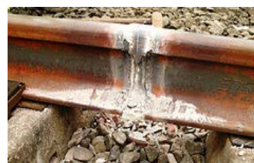
(109) Soldadura aluminotérmica. 20
