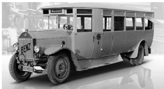
(34) Modelo de autobús desarrollado por Mercedes-Benz en el año 1925, el primero con bastidor bajo. 25
