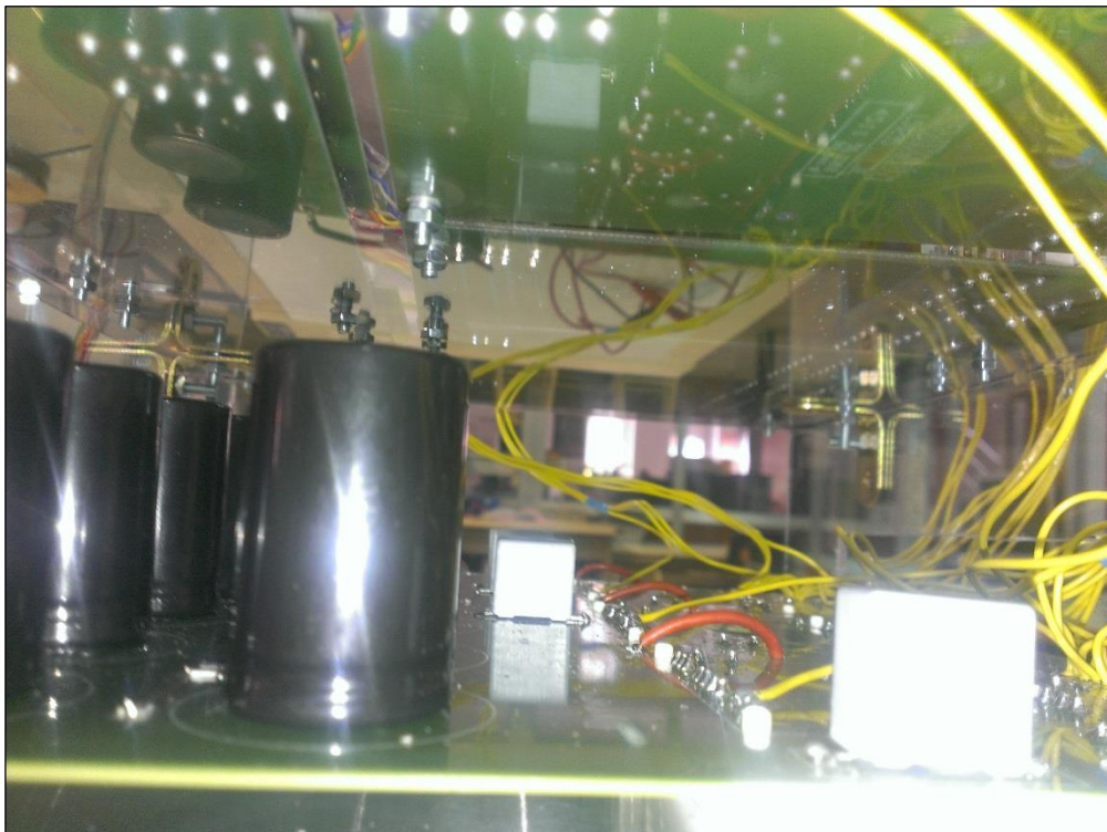
Figura 5.5 - Interior de la estructura (2)
