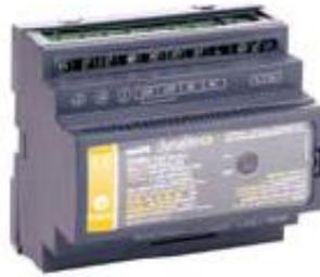
Fig. 3.15.- Controlador de carga de Philips Dynalite
