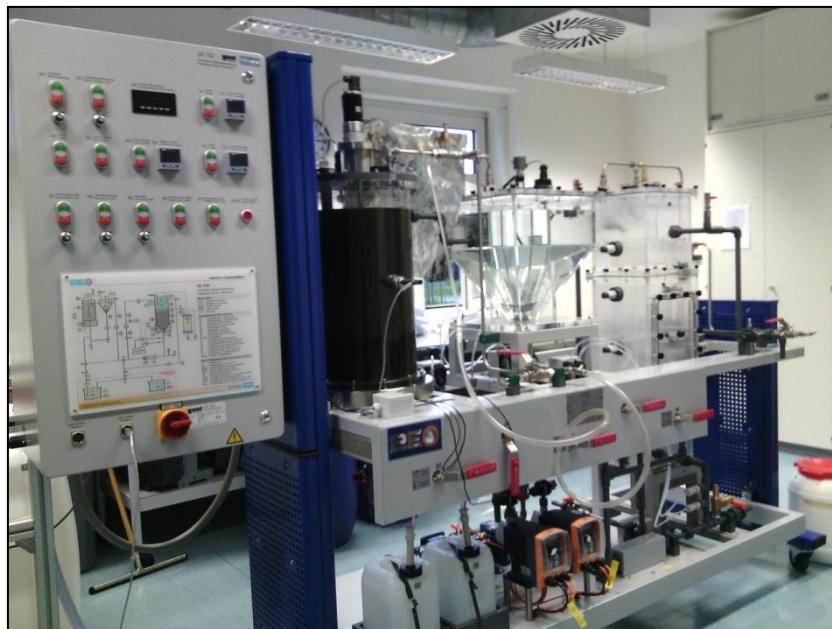
Ilustración 18. Tanque agitado y clarificador secundario preparado para el arranque
