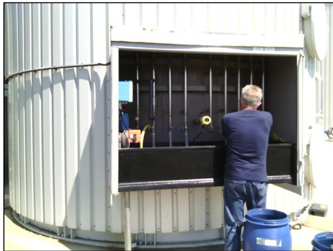
Ilustración 20. Extracción del fango del digester. WeserGold.
