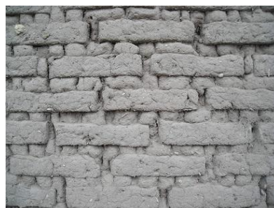
Figura 19. Muro de adobe. Fuente: http://www.sitiosolar.com/la-construccion-con-tierra-cruda-el-adobe-y-la-tapia/
