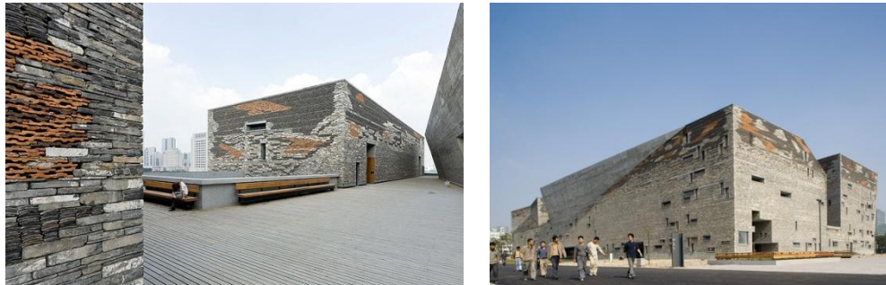
Figuras 4 y 5. Museo de historia de Ningbo. Wang Shu. Reutilización de materiales como tejas y piedra de otras construcciones. Fuente:
