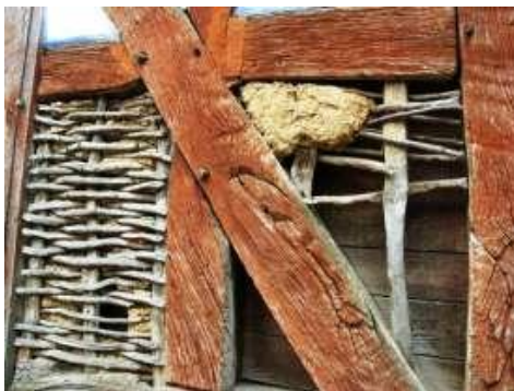
Figuras 2 y 3. Casa tipo fachwerk. Entramado y relleno con barro y paja. Fuente: http://mastersuniversitaris.upc.edu/tecnologiaarquitectura/tesis/Bohn.pdf
