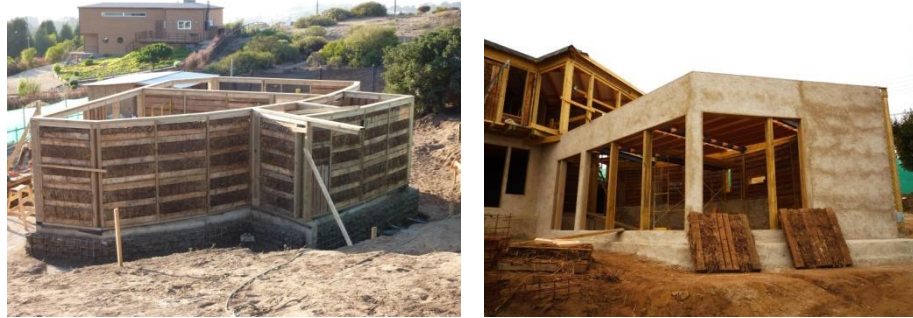
Figuras 80 y 81. Casa Jacinta. El palet en combinación con el adobe. Revestimiento. Fuente: J.SANCHEZ, P. SÁNCHEZ, J. ARIAS. Palet Project: Building with palets
