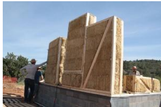
Figura 47. Muro sistema alfaWALL. Fuente: http://www.okambuva.coop/
