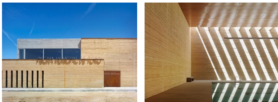
Figuras 14 y 15. Piscina Municipal de Toro. Fuente: http://vier.es/portfolio/piscina-toro/
