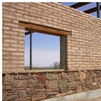
Figura 32. Muro BTC . Apertura de huecos y basamento
