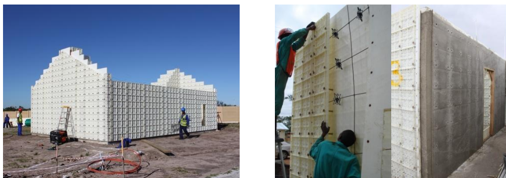
Figuras 6 y 7. Sistema Moladi. Utilización de un encofrado modulado. Fuente: http://www.plataformaarquitectura.cl/cl/tag/moladi
