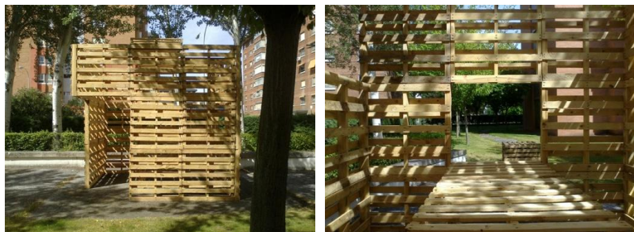
Figuras 77 y 78. Construcción con palets en la etsa, Valladolid.
