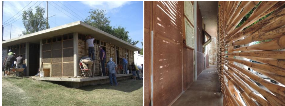
Figuras 22 y 23. Muros de bahareque a la izq. y celosía de carrizo a la dcha. Fuente: http://www.archdaily.mx/mx/762081/guadalajara-mexico-un-edificio-comunitario-de-muros-de-bahareque-y-celosia-de-carrizo
