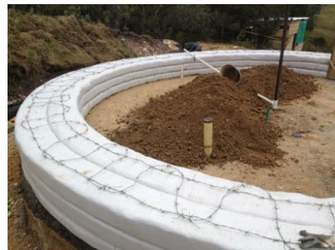
Figuras 26 y 27. Hiladas horizontales. Unión mediante alambre de púas. Fuente: http://www.casayburro.com/
