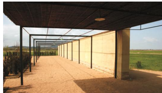
Figura 15. Tapial elevado sobre fábrica. Fuente://informesdelaconstruccion.revistas.csic.es
