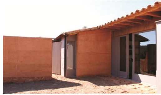
Figura 10. Prolongación aleros para protección. Fuente: http://informesdelaconstruccion.revistas.csic.es/index.php/informesdelaconstruccion/articulo/
