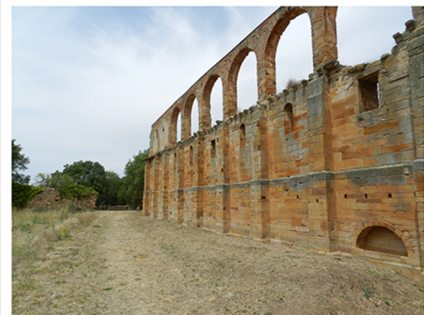
16. Vista de la fachada sur de la iglesia
