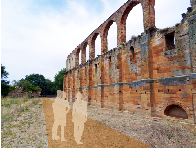
Vista 5: Camino que lleva a la cabecera de la iglesia.
