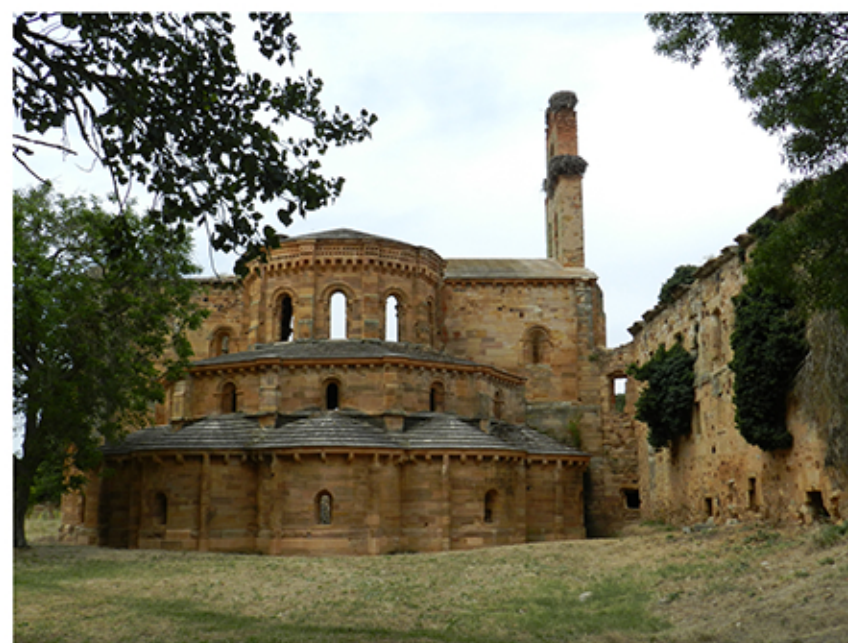
17. Vista exterior del ábside y cuerpo de dormitorios
