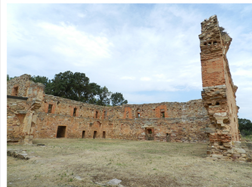
13. Vista del claustro de la hospedería desde el exterior
