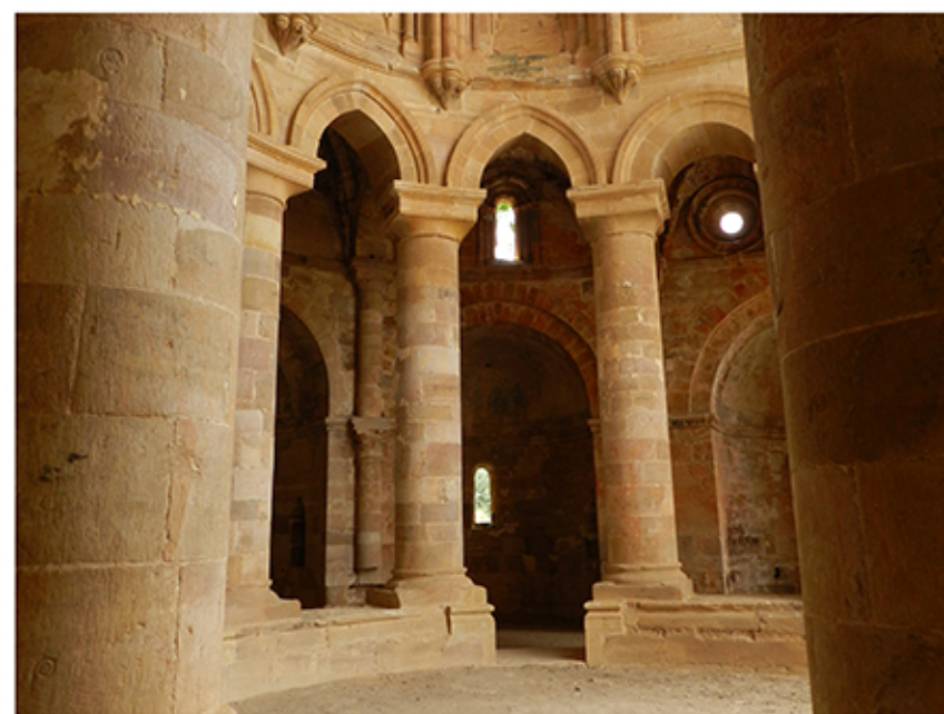
05. Vista del ábside de la iglesia
