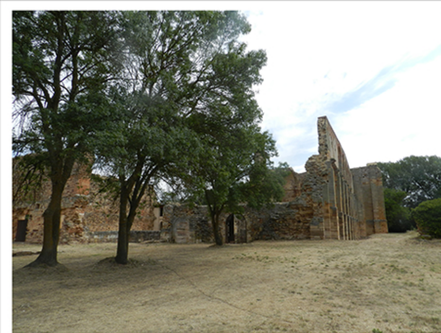
01. Vista de la fachada occidental de la iglesia
