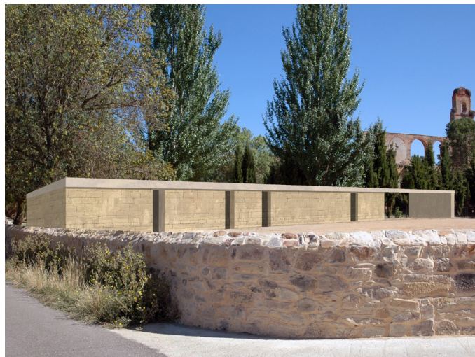
Vista 1: El pabellón de control desde el aparcamiento.
