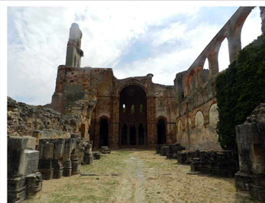
03. Vista de la nave central de la iglesia
