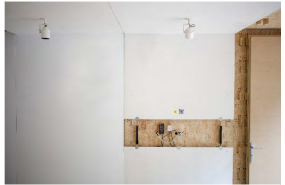
Fig. 44 Fotografías de montaje
