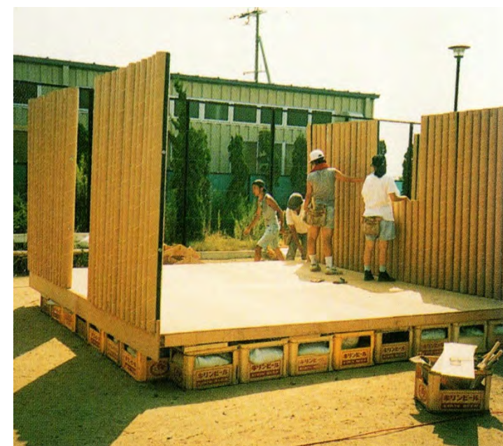
Fig. 70 Montaje de la Casa de troncos de papel
