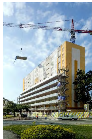
Fig. 53 Proceso de construcción
