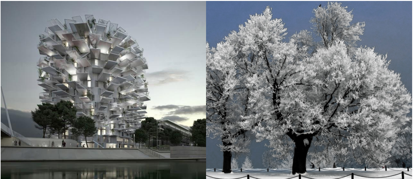
46. A través de estas dos fotos queda palpable la relación del edificio con el árbol blanco. La visualización de la torre ha sido extraída de la web del edificio www.larbreblanc.net debido a su novedad.
