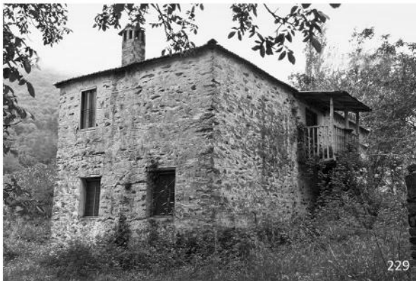
Casa de piedra tradicional, Skotino, Grecia.
