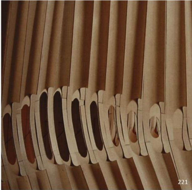
Superficie reglada laminada, ICD, M. Baur, F. Ernst y M. Vomhof, Stuttgart University.
