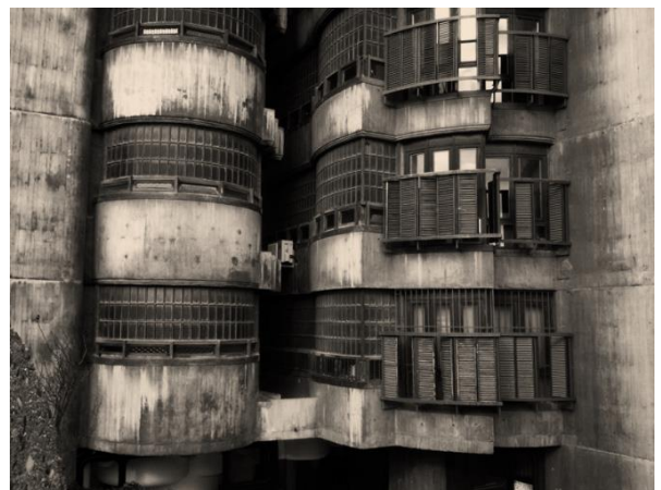
IMAGEN 29: vista exterior en fachada de la zona de cocinas del edificio
