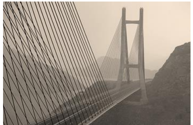
IMAGEN 11: puente sobre el Ebro de Carlos Fernández Casado
