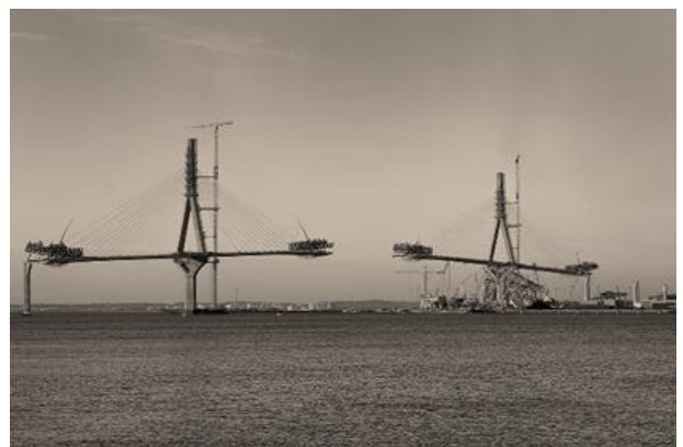
IMAGEN 13: Puente de la Pepa de acceso a la ciudad de Cádiz
