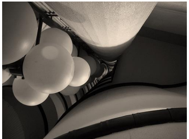
IMAGEN 27: el hueco de la escalera del edificio Torres Blancas
