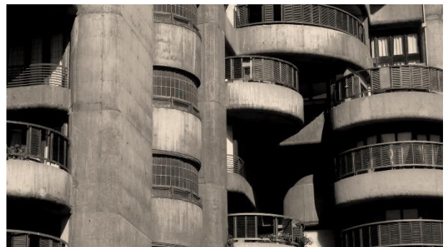
IMAGEN 21: detalle de las terrazas del edificio Torres Blancas
