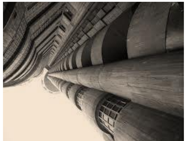
IMAGEN 61: vista del edificio tomada desde el suelo
