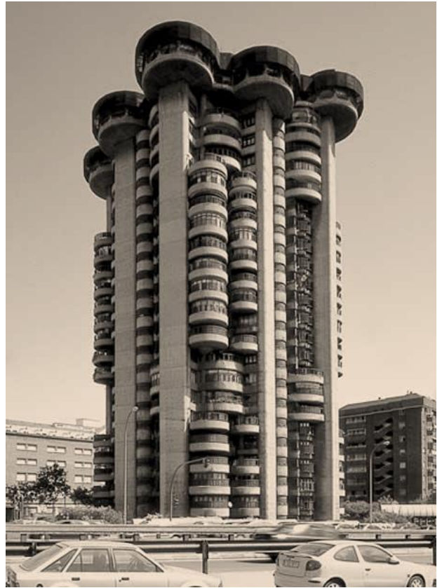
IMAGEN 20: vista del edificio Torres Blancas desde la Av. De América
