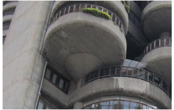
IMAGEN 58: detalle de apoyo de una de las terrazas sobre el pilar con ábaco
