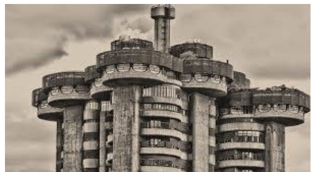
IMAGEN 35: vista del tramo superior de la torre
