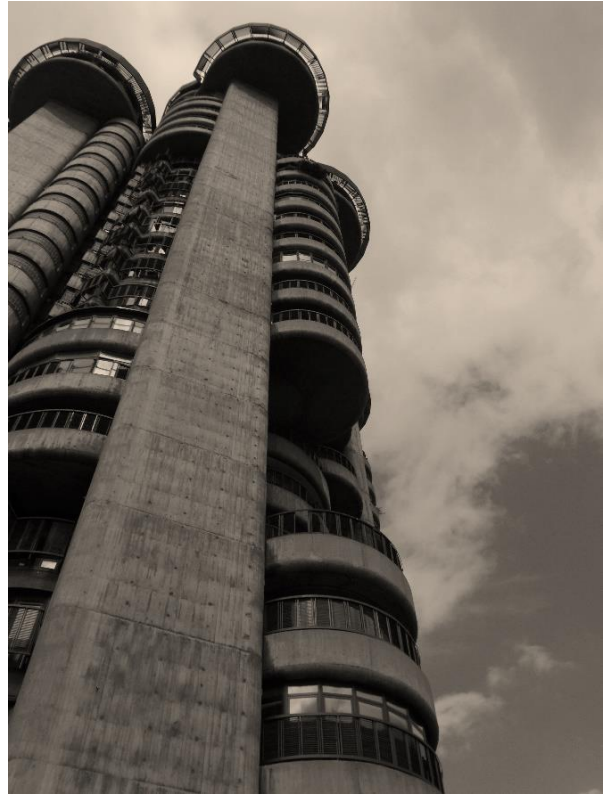
IMAGEN 42: vista en fachada de una de las pantallas estructurales del edificio
