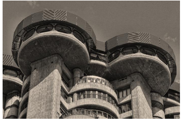
IMAGEN 54: vista del apoyo de los discos sobre las pantallas estructurales
