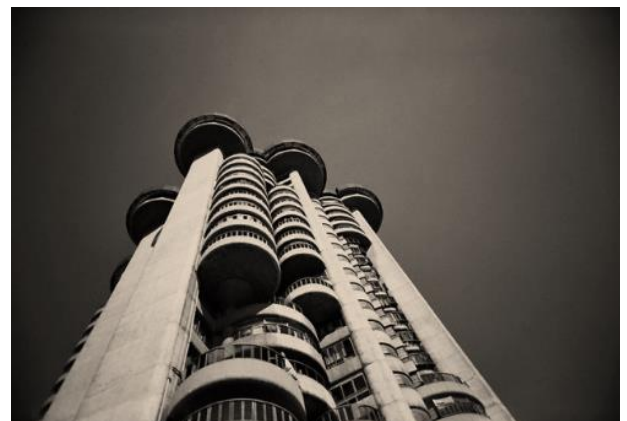
IMAGEN 25: vista parcial del edificio Torres Blancas
