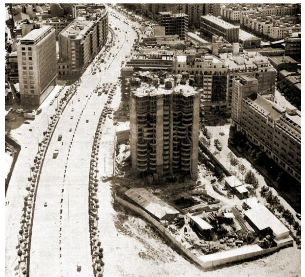
IMAGEN 23: vista aérea del edificio Torres Blancas durante su construcción
