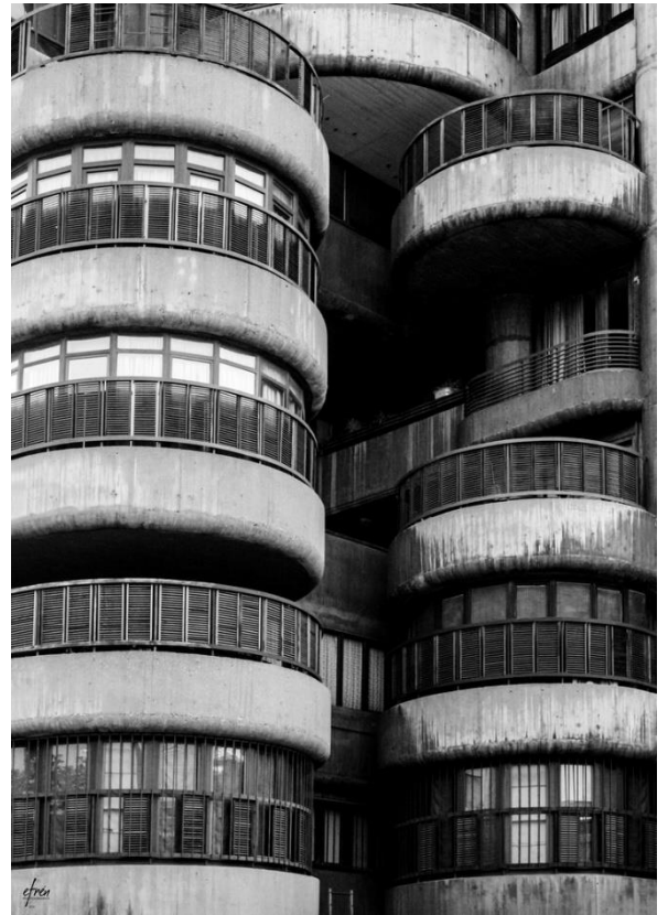
IMAGEN 48: detalle de las terrazas en voladizo del edificio
